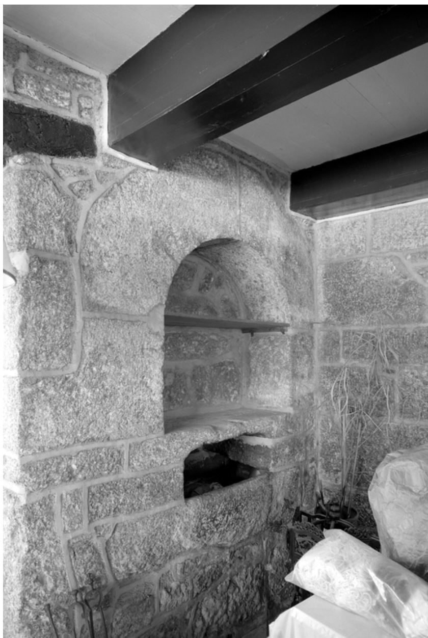
Rez-de-chaussée, aile ouest, mur nord : détail de l'évier
