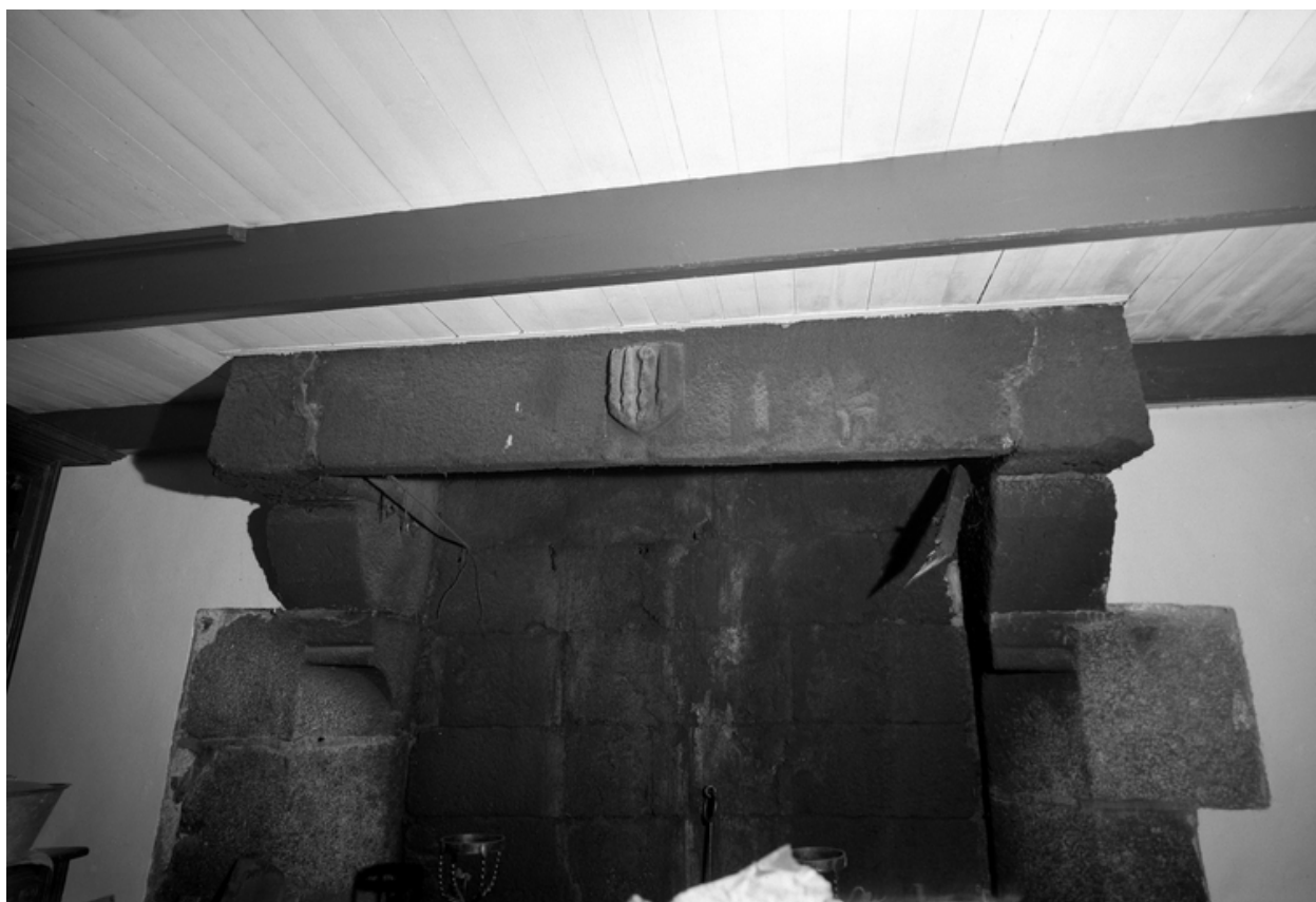
Rez-de-chaussée, mur est : détail de la cheminée
