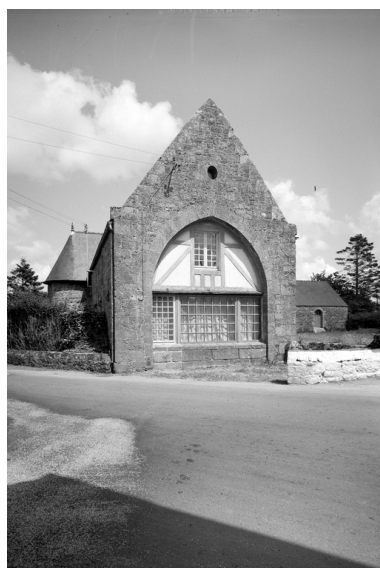
Vue générale nord ouest Phot. François Dagorn IVR53_19692200573V
