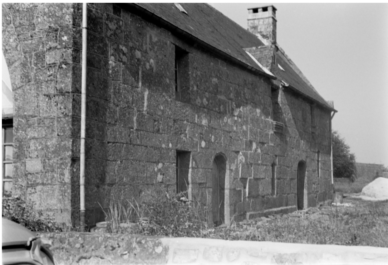
Vue générale de la façade sud prise du sud ouest
