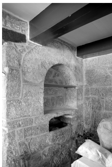
Rez-de-chaussée, aile ouest, mur nord : détail de l'évier Phot. François Dagorn IVR53_19692200575V
