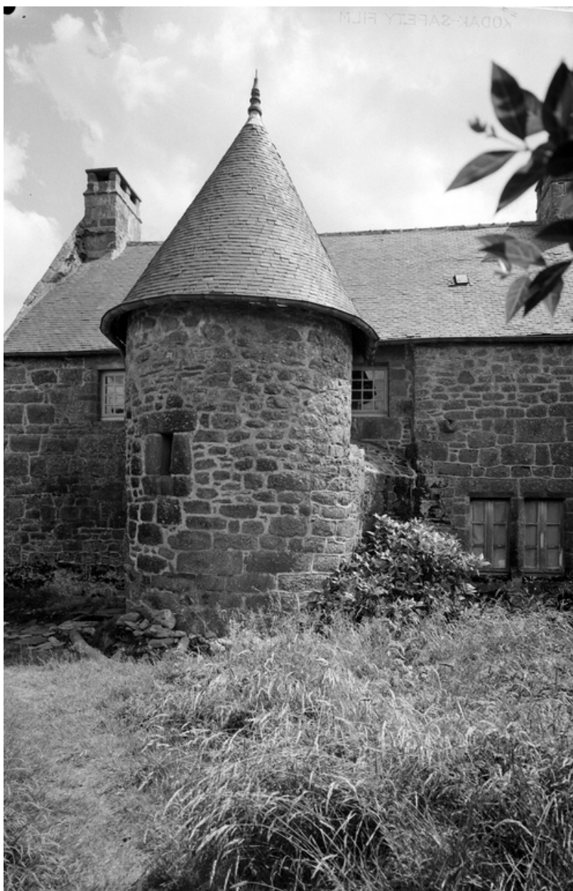
Façade nord : détail de la tourelle
