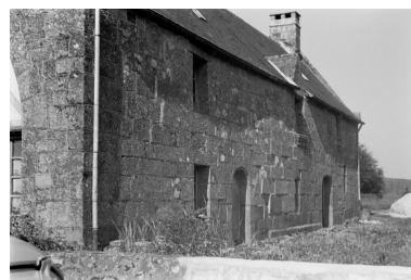
Vue générale de la façade sud prise du sud ouest Phot. Brulon IVR53_19662200536Z
