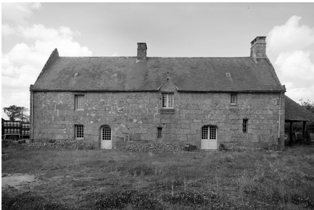
Vue générale de la façade sud
