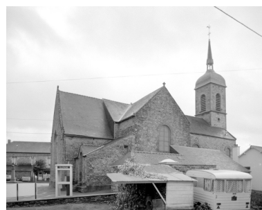
Elévation Nord : vue générale Phot. A. Boden IVR53_19943500049X
