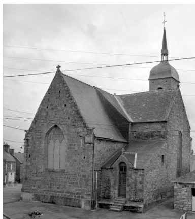
Elévation Nord-Est : vue générale Phot. Guy Artur, Phot. Norbert Lambart
