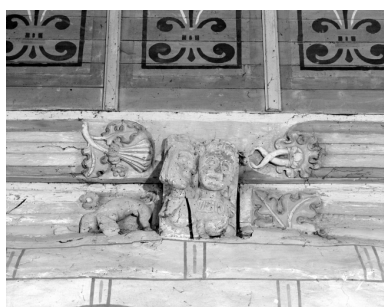
Sablière : détail d'un personnage sculpté Phot. A. Boden IVR53_19943500045X
