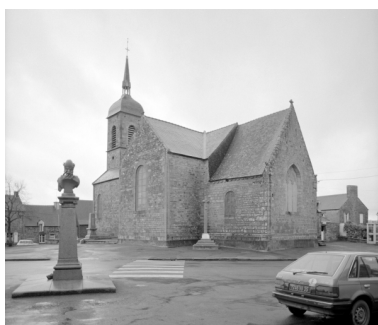
Elévation Sud-Est : vue générale Phot. Guy Artur, Phot. Norbert Lambart IVR53_19943500048X
