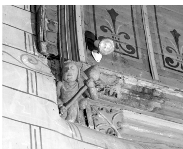
Sablière : détail d'un personnage sculpté Phot. A. Boden IVR53_19943500044X
