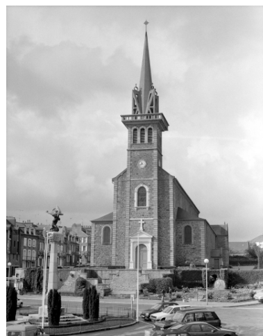
Elévation Est : vue générale. Phot. Guy Artur, Phot. Norbert Lambart IVR53_19943501860X
