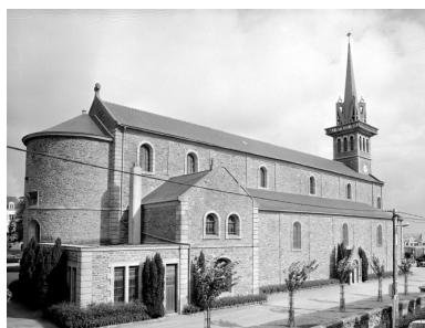
Elévation Sud-Ouest : vue générale. Phot. Guy Artur, Phot. Norbert Lambart IVR53_19943501862X
