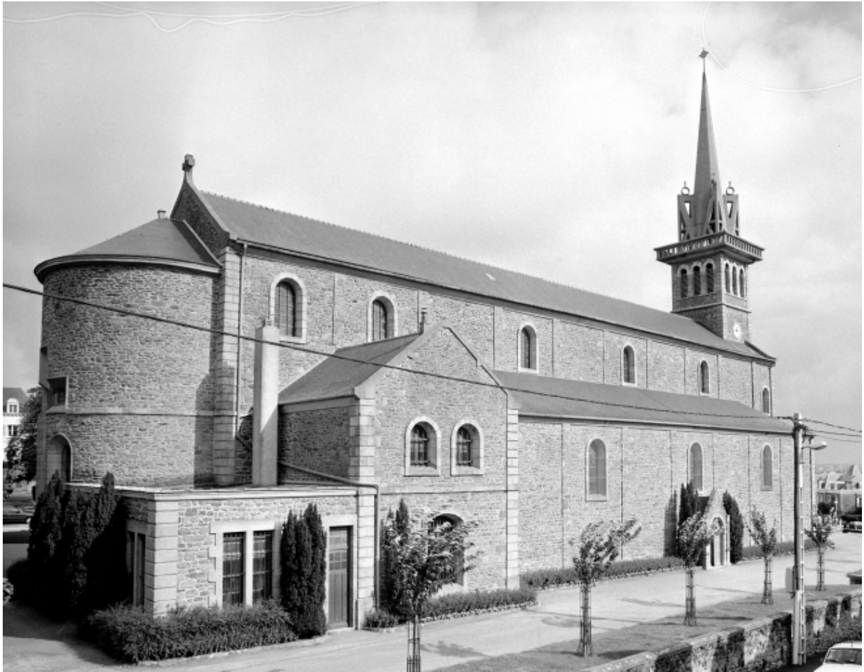
Elévation Sud-Ouest : vue générale.
