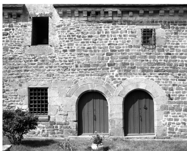
Logis, façade : détail partie centrale. Phot. Guy Artur, Phot. Norbert Lambart IVR53_19853501592X
