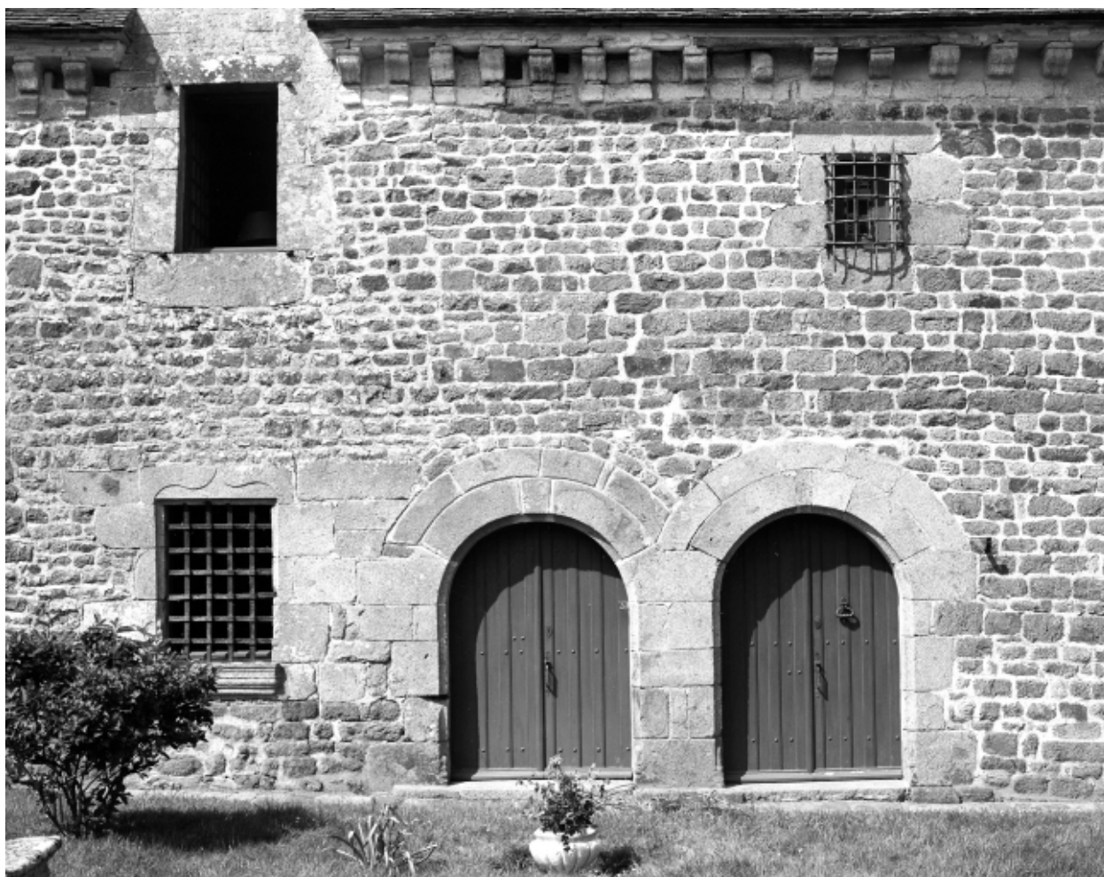
Logis, façade : détail partie centrale.
