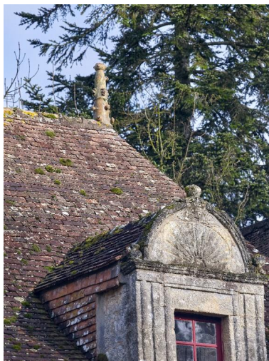
Toit en tuiles plates et épis de faîtage en terre cuite Phot. Bernard Bègne IVR53_20243501389NUCA
