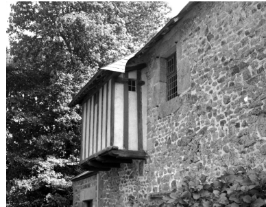
Logis, façade postérieure, latrines, vue générale. Phot. Guy Artur, Phot. Norbert Lambart IVR53_19853501594X
