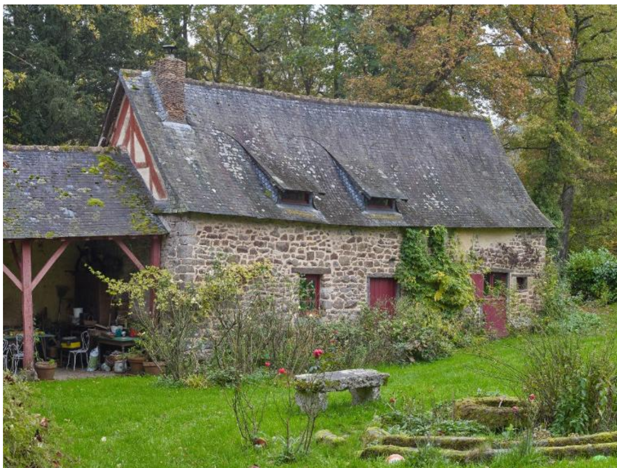
Dépendance perpendiculaire au logis principal. Vue générale nord-ouest
