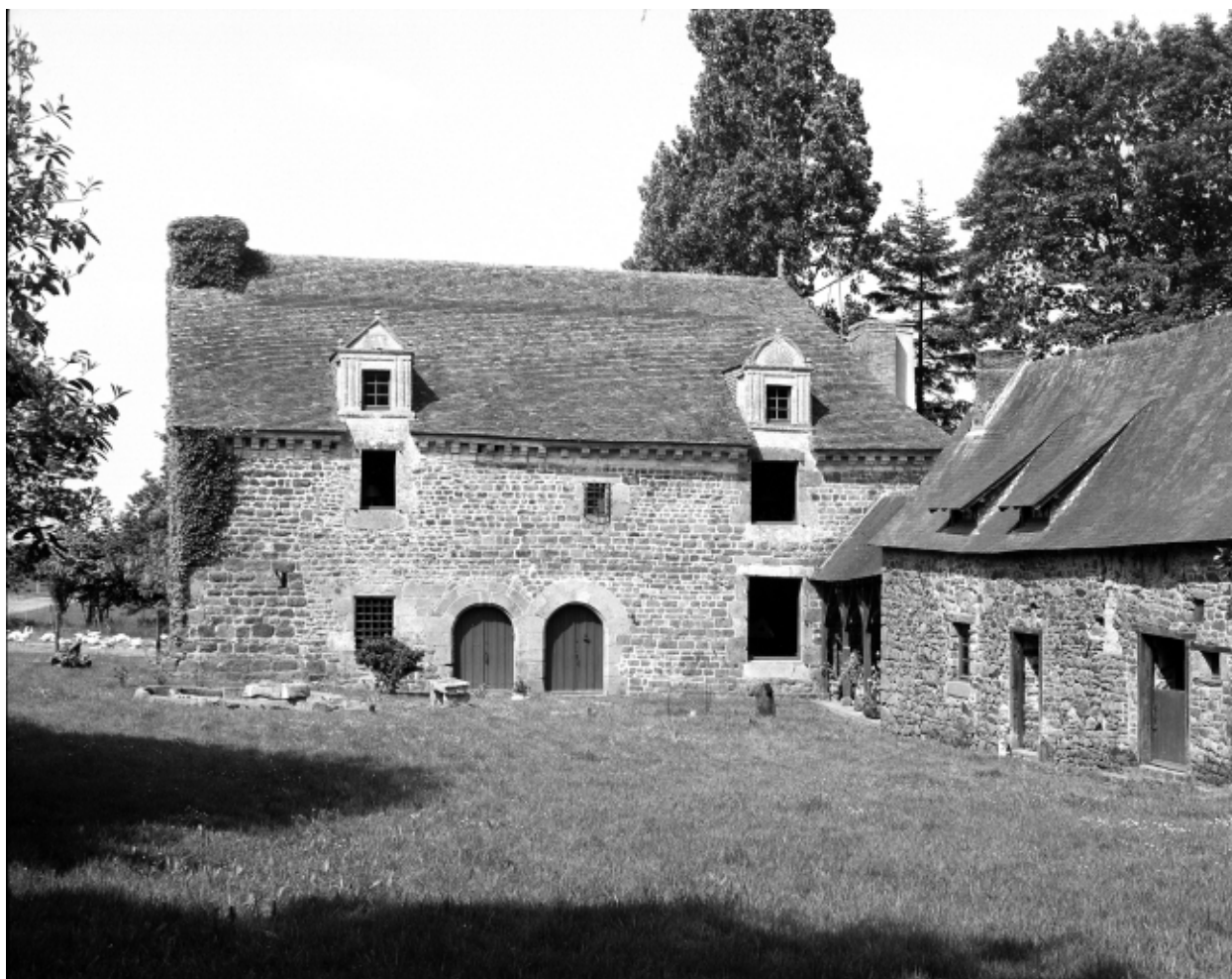
Vue générale sud, logis et communs.
