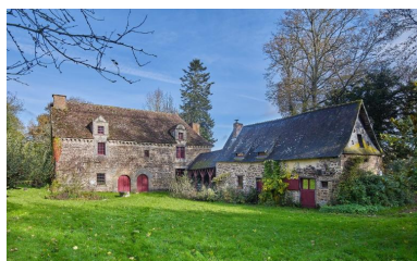
Vue générale sud-ouest Phot. Bernard Bègne IVR53_20243501379NUCA
