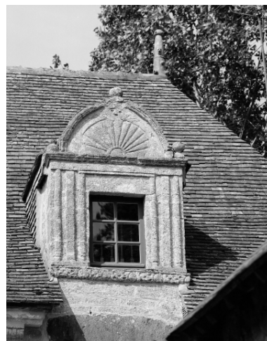
Logis, lucarne droite, vue générale. Phot. Guy Artur, Phot. Norbert Lambart IVR53_19853501589X
