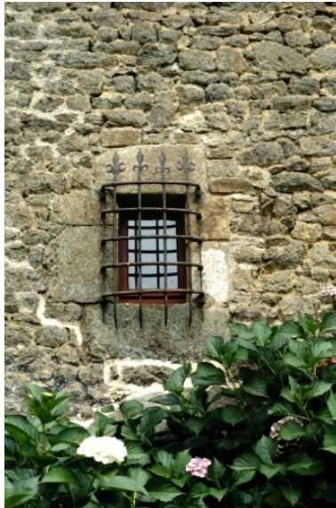
Logis, façade postérieure, baies à grilles. Phot. Guy Artur, Phot. Norbert Lambart IVR53_19853500449ZA
