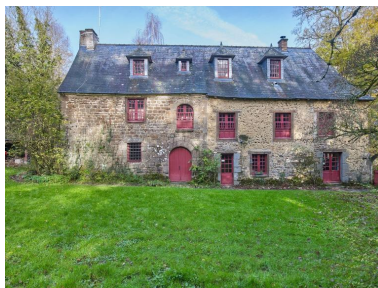
Vue générale sud Phot. Bernard Bègne IVR53_20243501396NUCA
