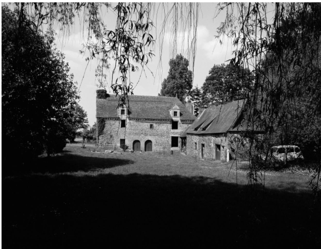
Vue de situation sud-ouest.
