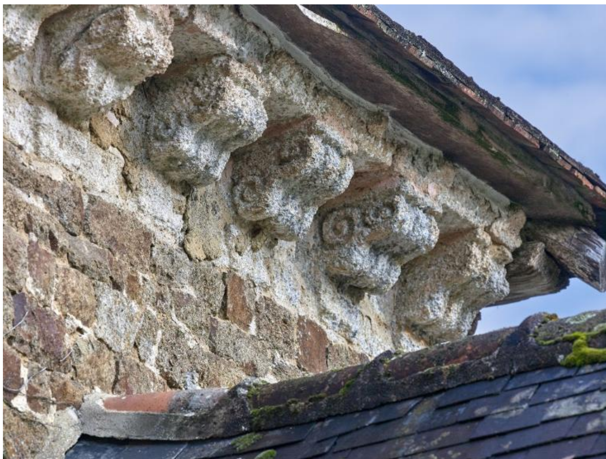
Façade sud. Corniche. Détail des modillons en pierre calcaire, à décor de cannelures et de volutes
