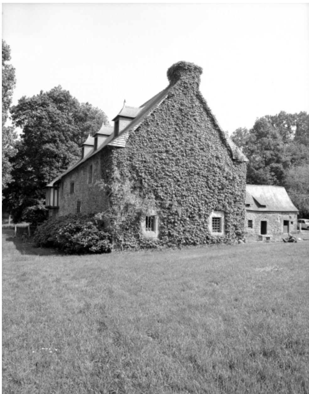
Logis : pignon ouest, vue générale.
