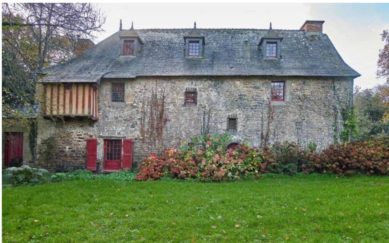
Vue générale nord
