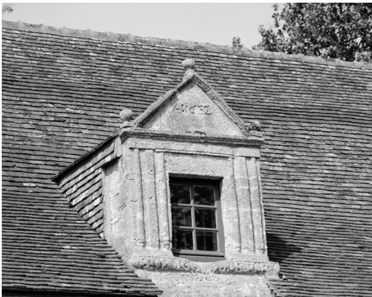
Logis, lucarne gauche datée 1652, vue générale.
