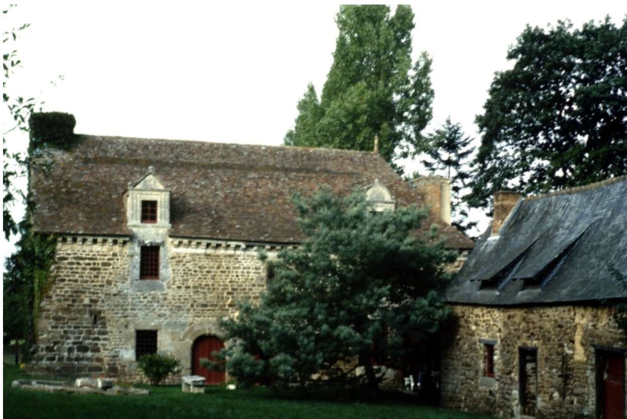
Vue de situation sud-ouest.
