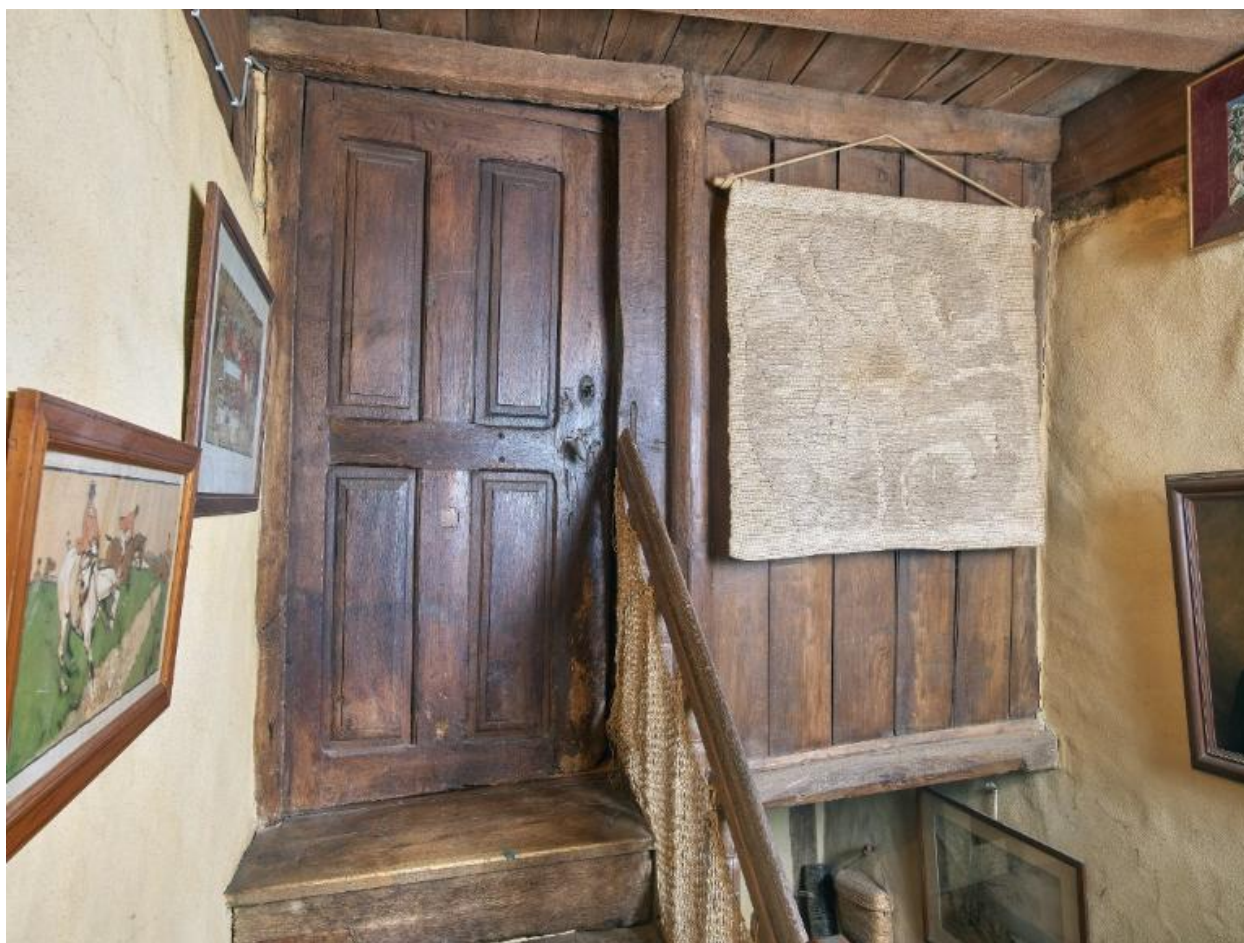
Logis principal. Combles. Porte d'accès au grenier
