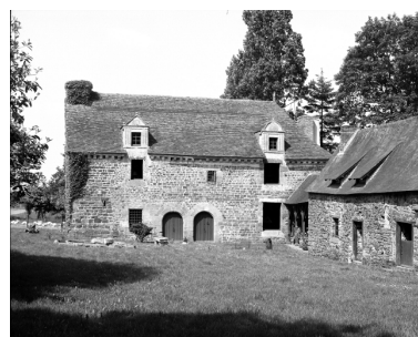
Vue générale sud, logis et communs. Phot. Guy Artur, Phot. Norbert Lambart IVR53_19853501590X
