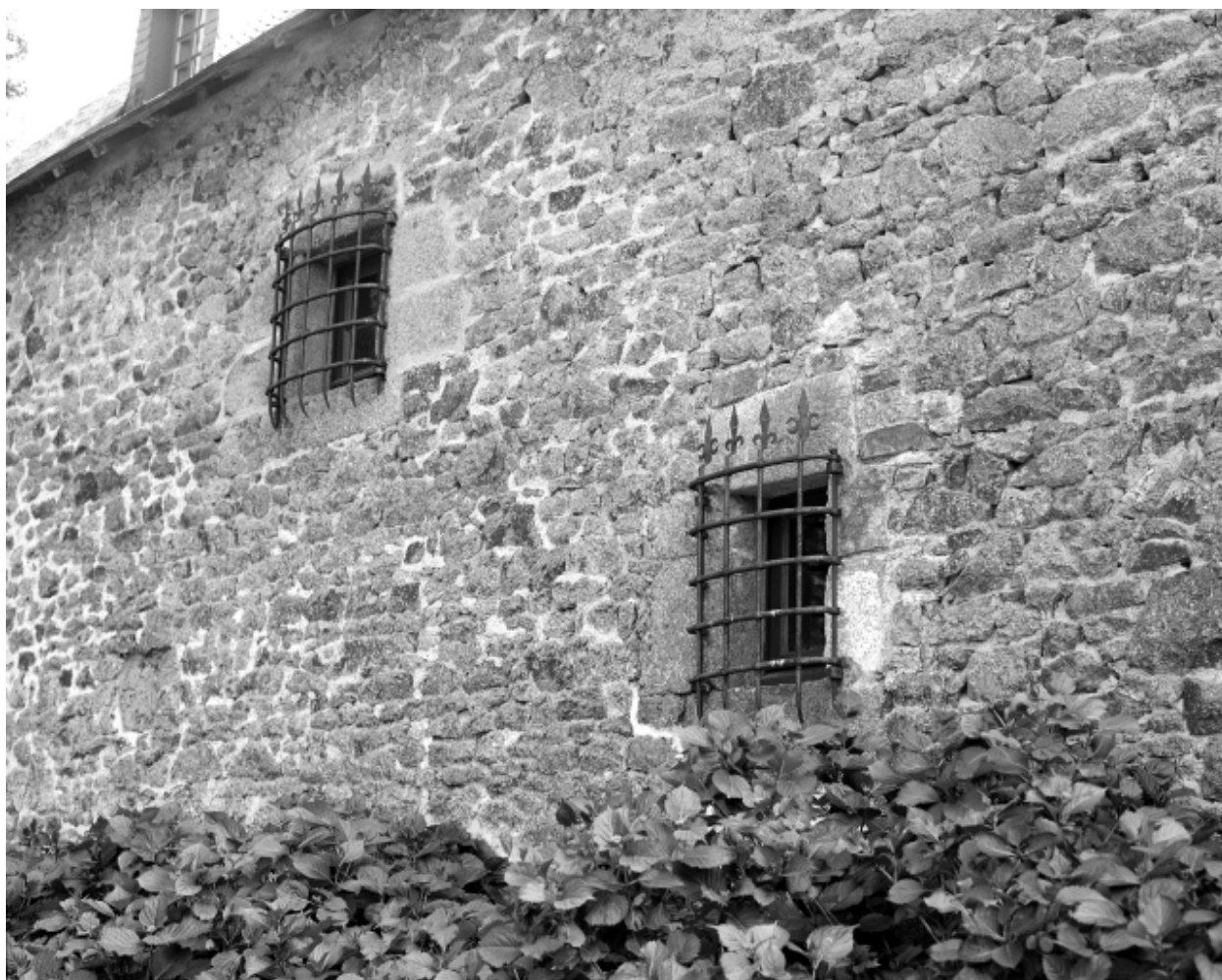
Logis, façade postérieure, baies à grilles, vue générale.
