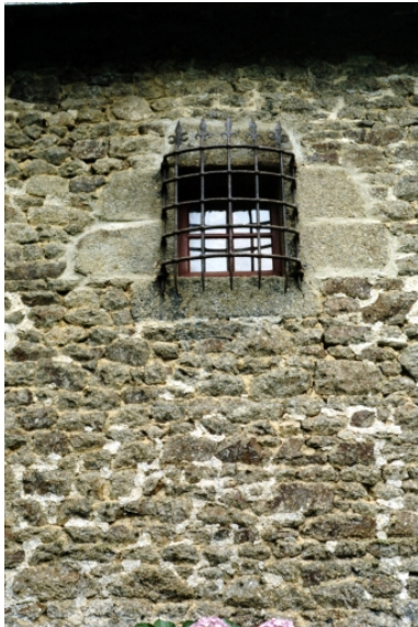
Logis, façade postérieure, baies à grilles. Phot. Guy Artur, Phot. Norbert Lambart IVR53_19853500448ZA
