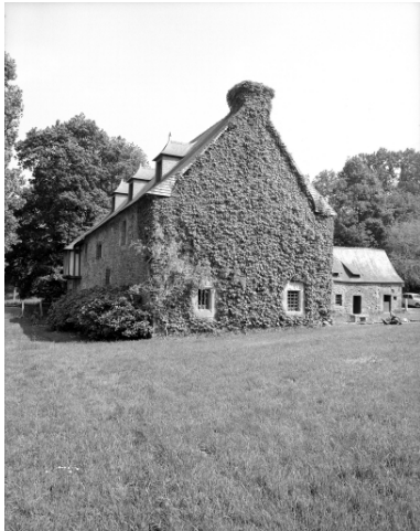
Logis : pignon ouest, vue générale. Phot. Guy Artur, Phot. Norbert Lambart IVR53_19853501593X
