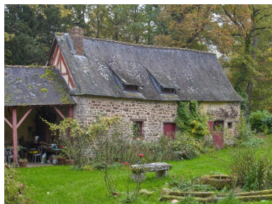
Dépendance perpendiculaire au logis principal. Vue générale nord-ouest Phot. Bernard Bègne IVR53_20243501345NUCA
