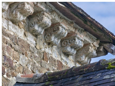
Façade sud. Corniche. Détail des modillons en pierre calcaire, à décor de cannelures et de volutes Phot. Bernard Bègne IVR53_20243501384NUCA
