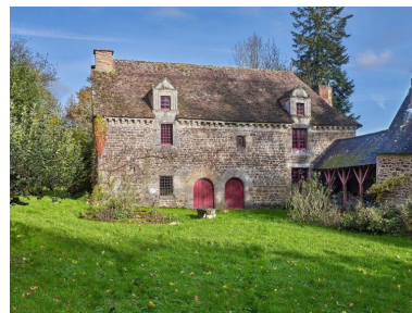
Vue générale sud Phot. Bernard Bègne IVR53_20243501380NUCA
