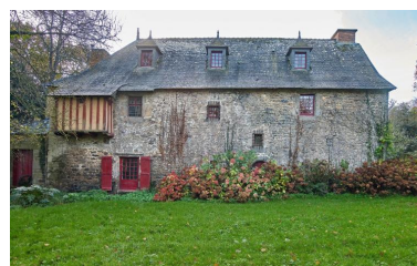
Vue générale nord Phot. Bernard Bègne IVR53_20243501392NUCA
