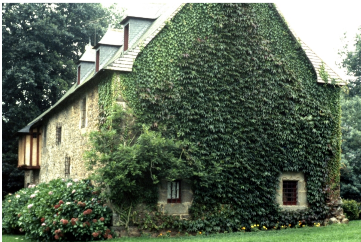
Logis : pignon ouest, vue générale.
