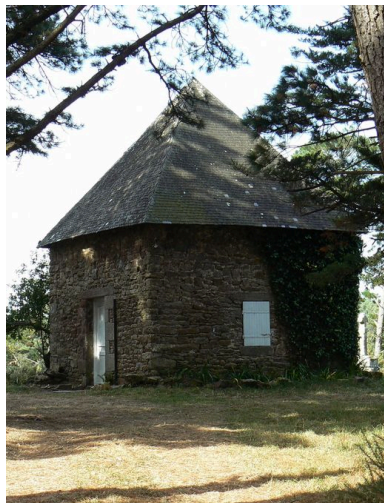
Guérite des douaniers de Barrarac'h Phot. Johan Vincent IVR53_20075605760NUCA
