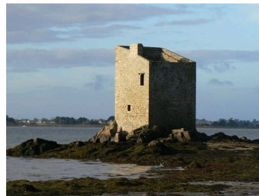
Tour de Ténéro Phot. Julien Amghar IVR53_20085606125NUCA
