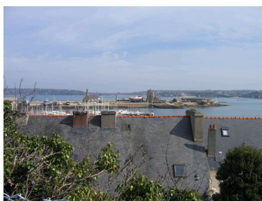
Zone d'activités du Sillon Phot. Françoise Péron IVR53_20062908420NUCA
