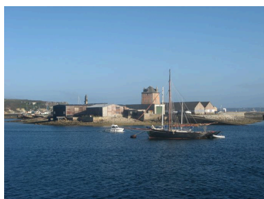
Zone d'activités du Sillon Phot. Guillaume Marie IVR53_20082908286NUCA
