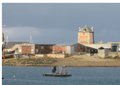
Atelier de chantier naval des CMC Phot. Françoise Péron IVR53_20062908294NUCA
