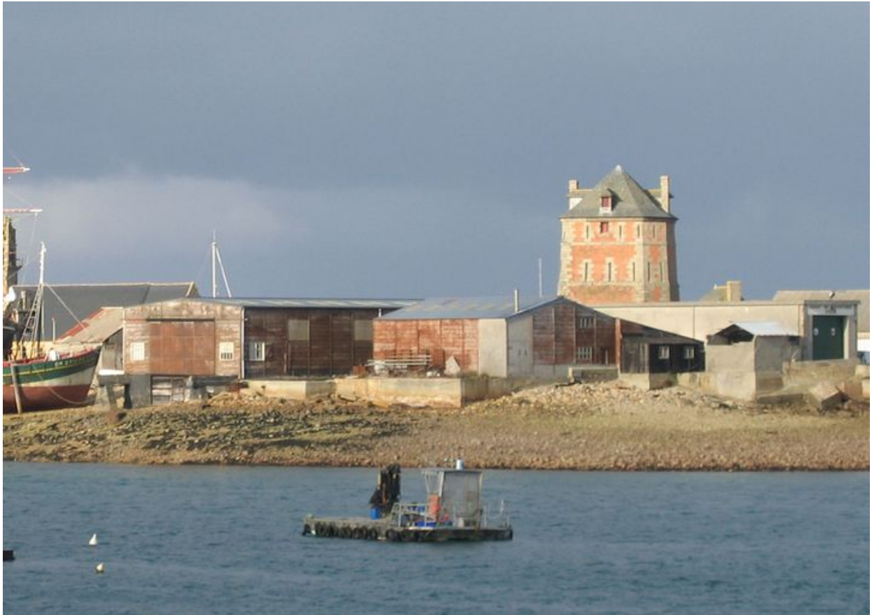
Atelier de chantier naval des CMC
