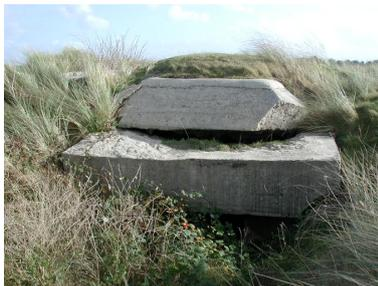
Vue du bunker-abri de type VF 2c pour 12 soldats (état en 2003). Il a subi une explosion interne
