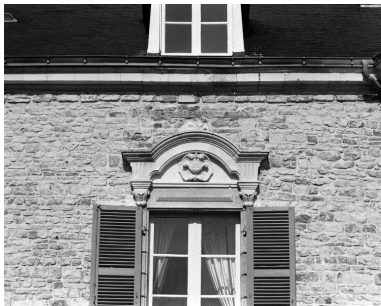
Elévation est, fenêtre : deuxième travée sud. Phot. Guy Artur, Phot. Norbert Lambart IVR53_19915600859X
