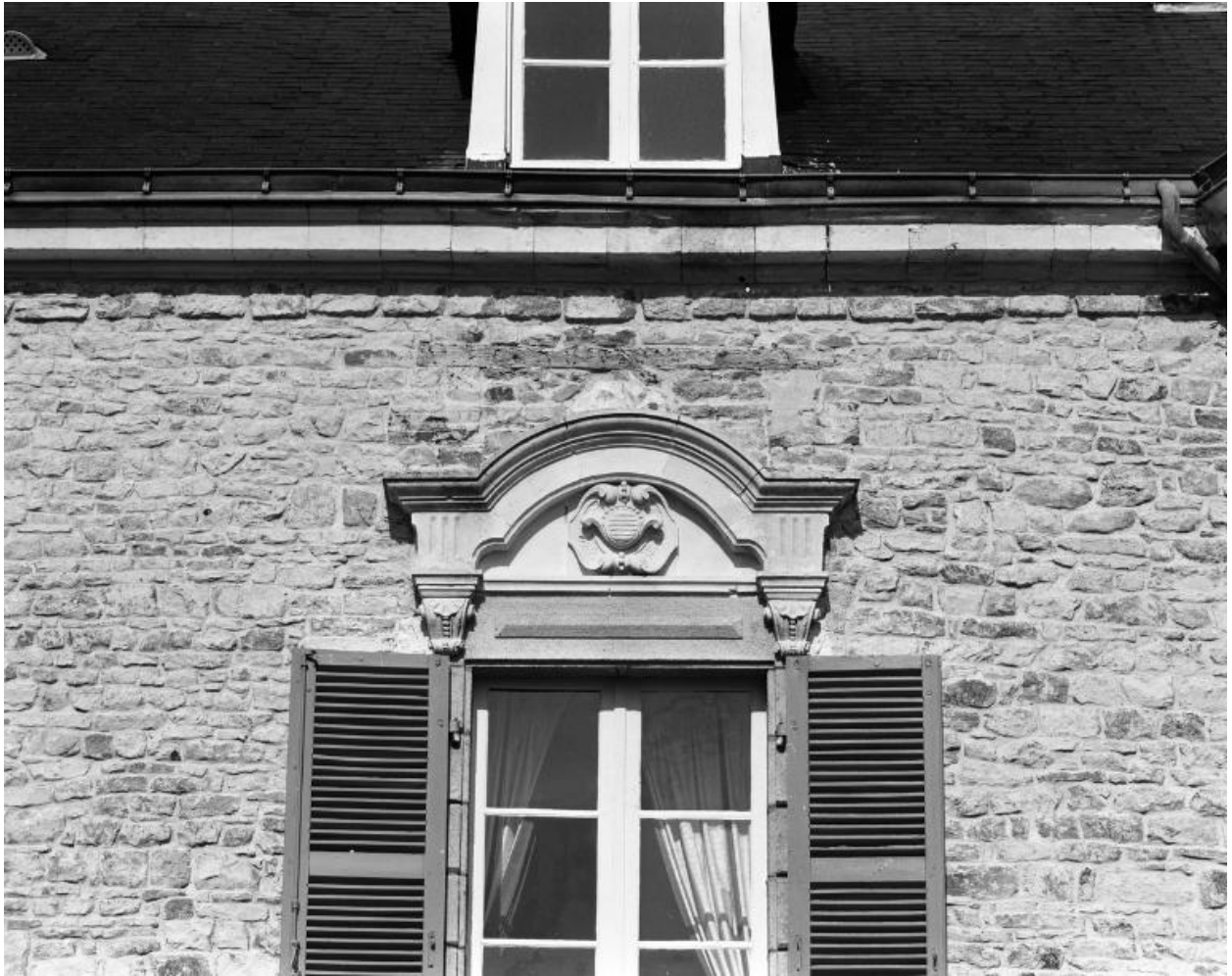
Elévation est, fenêtre : deuxième travée sud.
