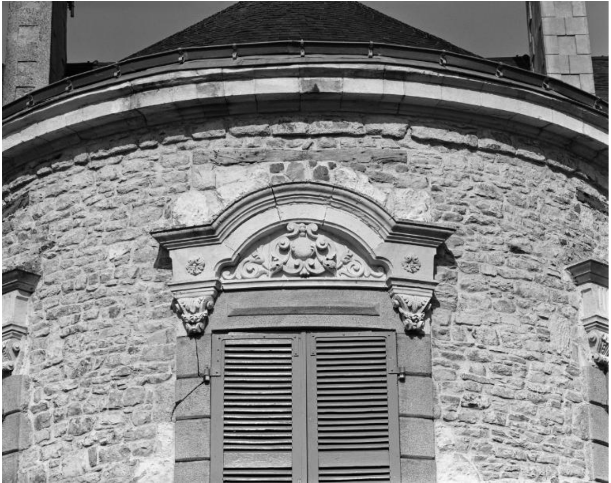
Elévation est, fenêtre centrale, linteau.
