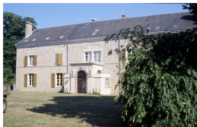
Elévation ouest, partie nord et chapelle Phot. Guy Artur, Phot. Norbert Lambart IVR53_19915600997ZA
