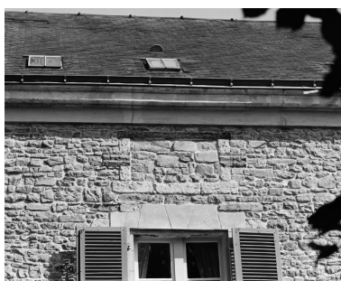
Elévation ouest, première travée nord, détail : fenêtre bouchée. Phot. Guy Artur, Phot. Norbert Lambart IVR53_19915600894X
