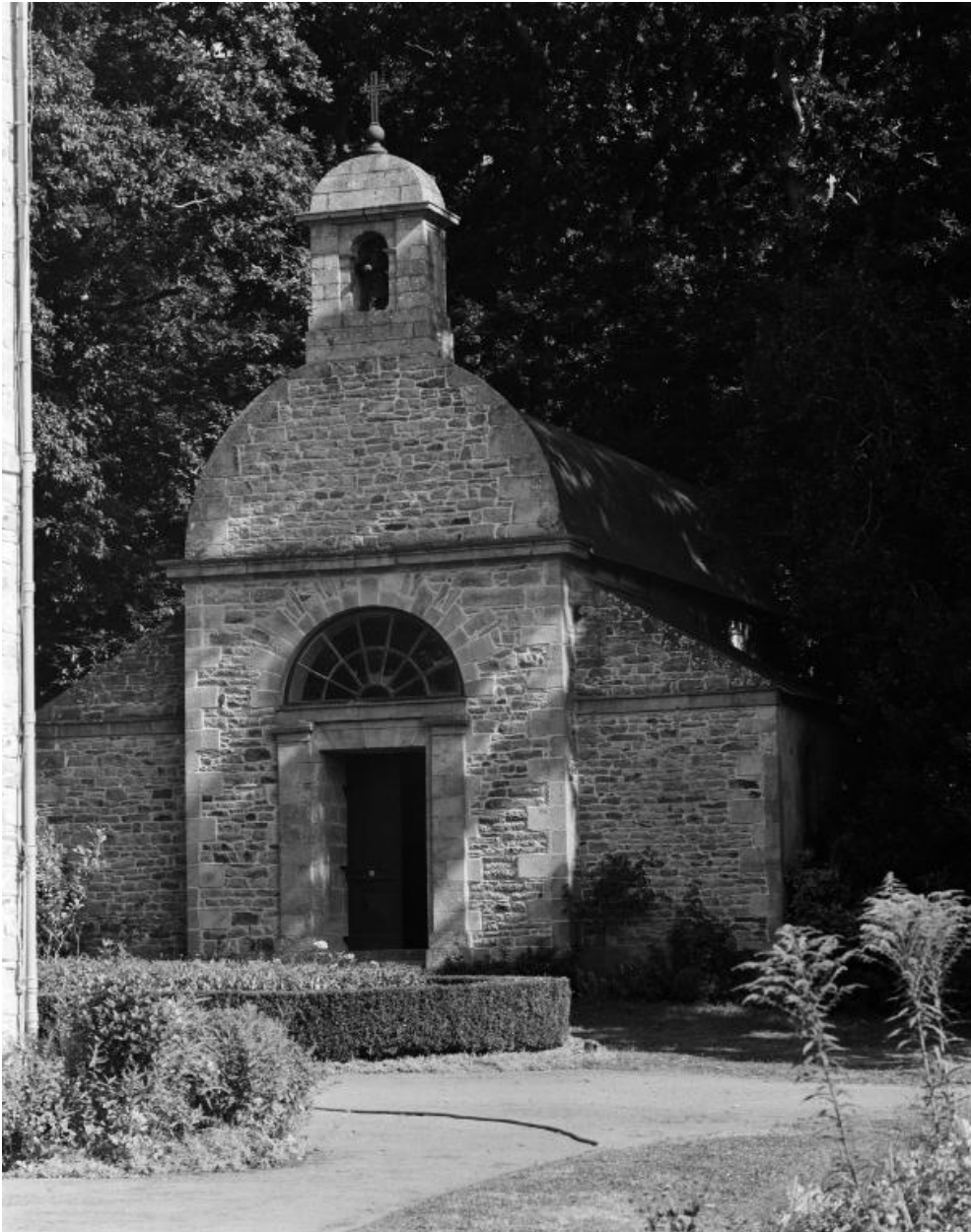
Chapelle : élévation sud.
