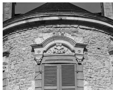
Elévation est, fenêtre centrale, linteau. Phot. Guy Artur, Phot. Norbert Lambart IVR53_19915600855X
