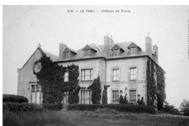
Vue de la façade postérieure Phot. Elise Lauranceau IVR53_20042905480NUCB
