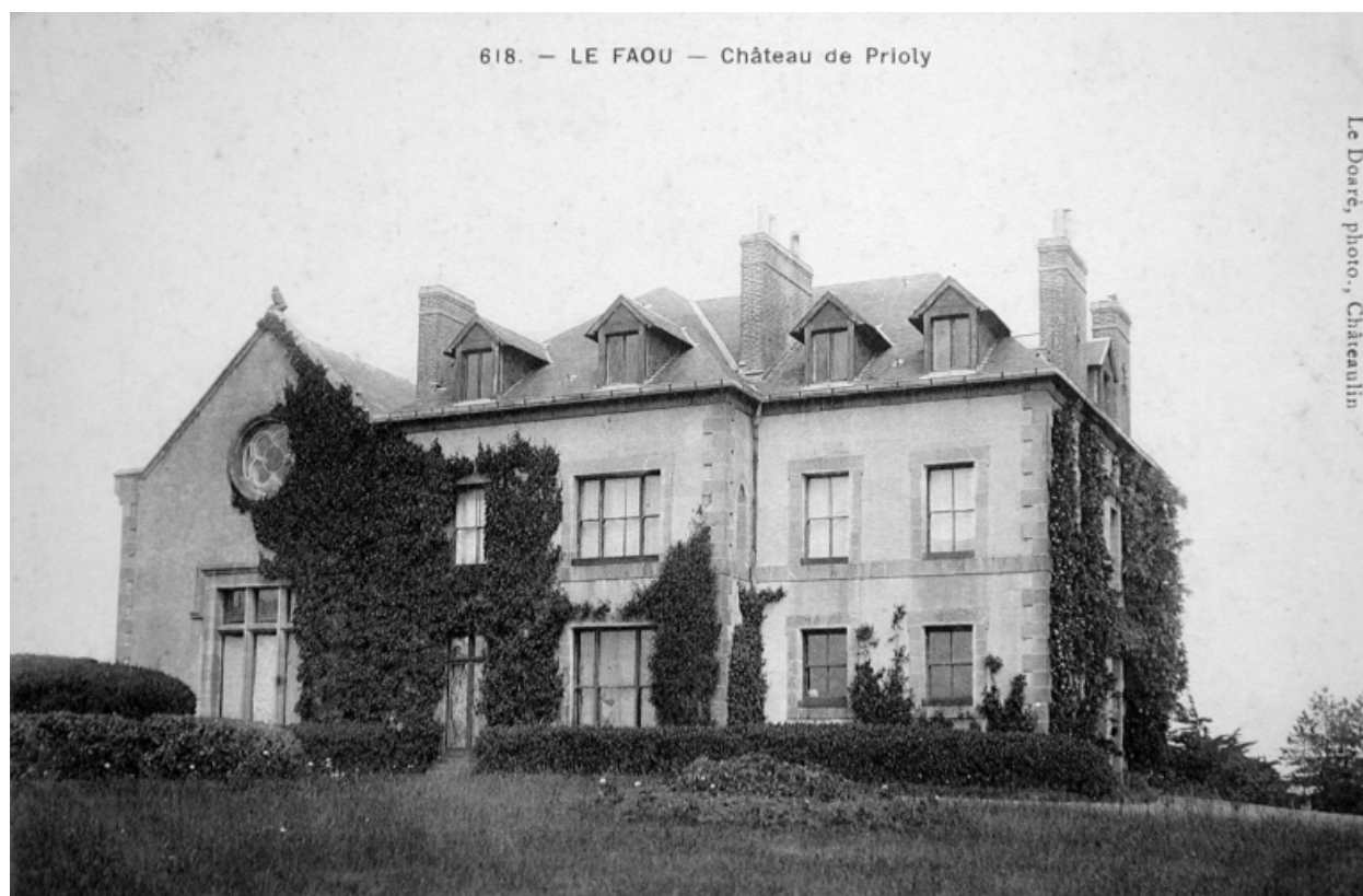
Vue de la façade postérieure
