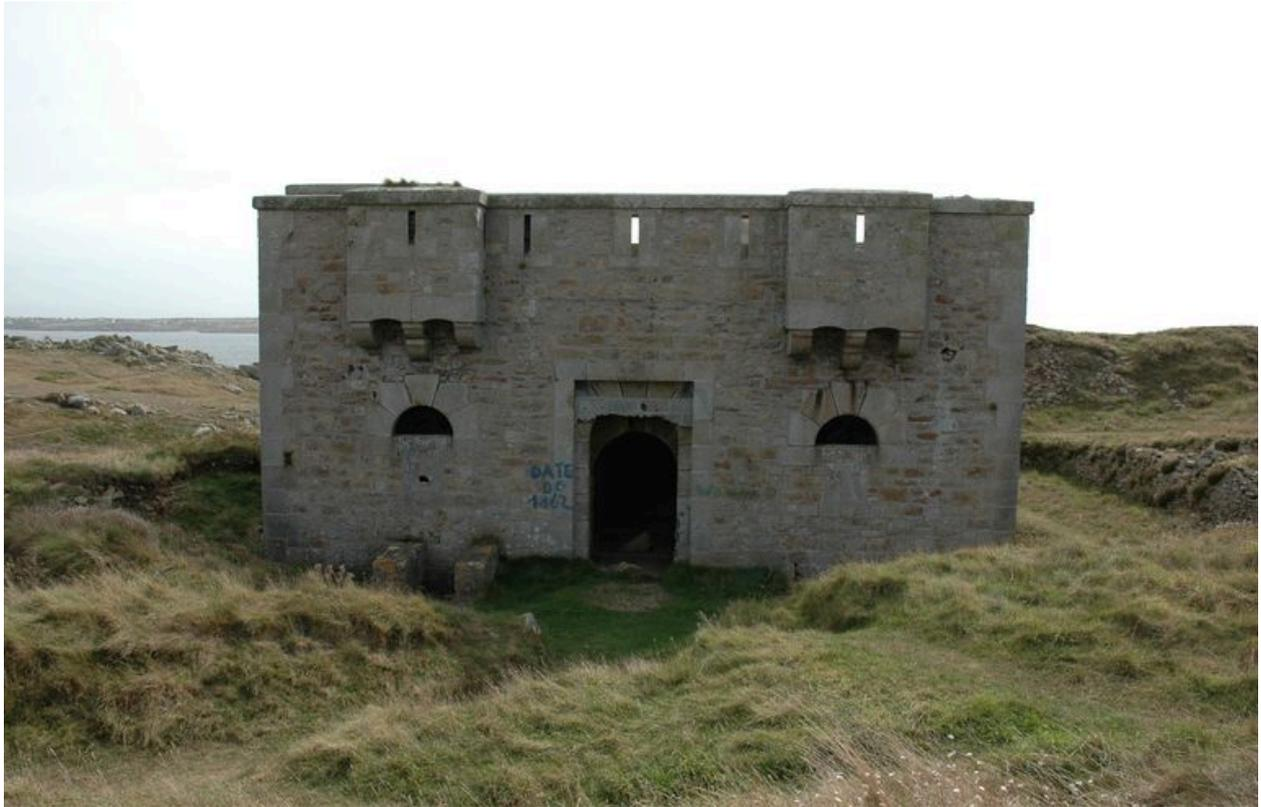
Ouessant : vue générale du corps de garde crénelé n° 3, façade septentrionale. L'entrée du réduit est flanquée de deux bretèches
