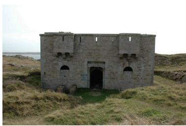
Ouessant : vue générale du corps de garde crénelé n° 3, façade septentrionale. L'entrée du réduit est flanquée de deux bretèches
