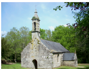
Plouyé, chapelle Saint-Mathurin : vue générale sud-ouest Phot. Gwénaél Fauchille IVR53_20082905842NUCA
