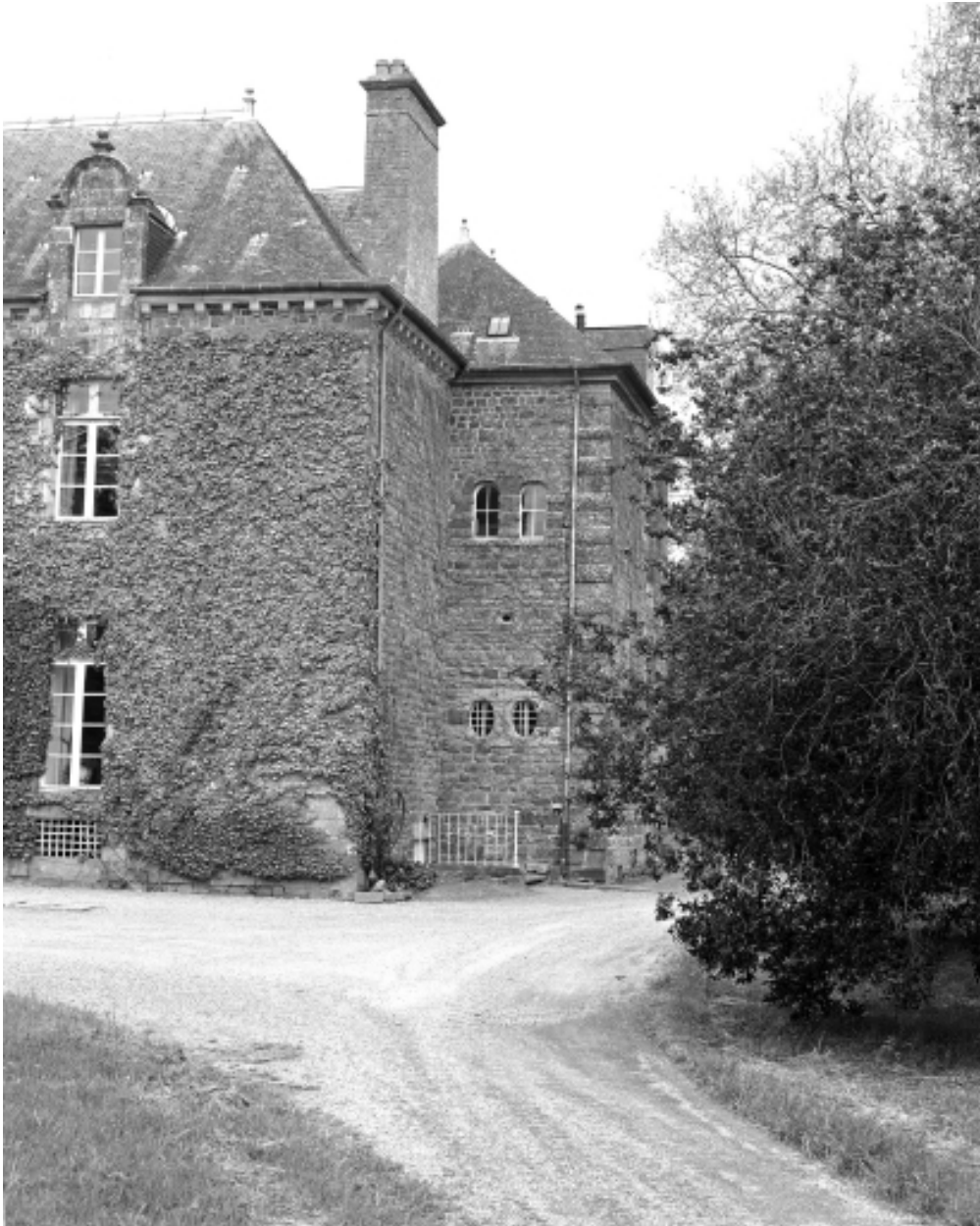
Pavillon est : élévation sud, vue générale.
