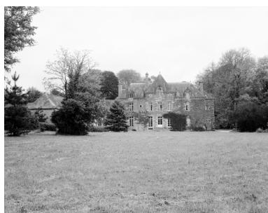
Élévation sud : vue frontale. Phot. Guy Artur, Phot. Norbert Lambart IVR53_19853501492X
