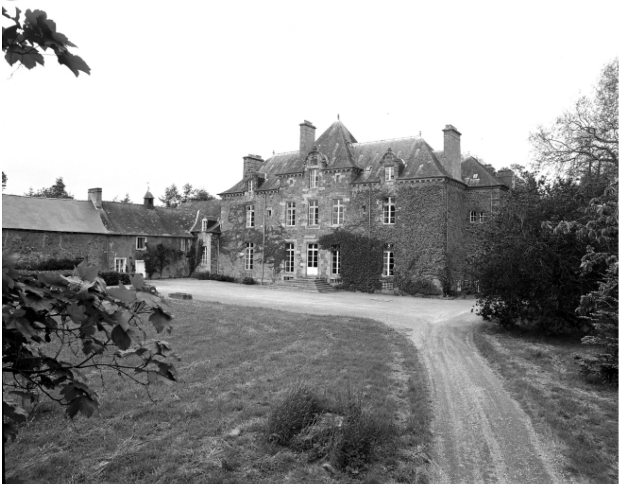
Elévation sud : vue biaise générale.
