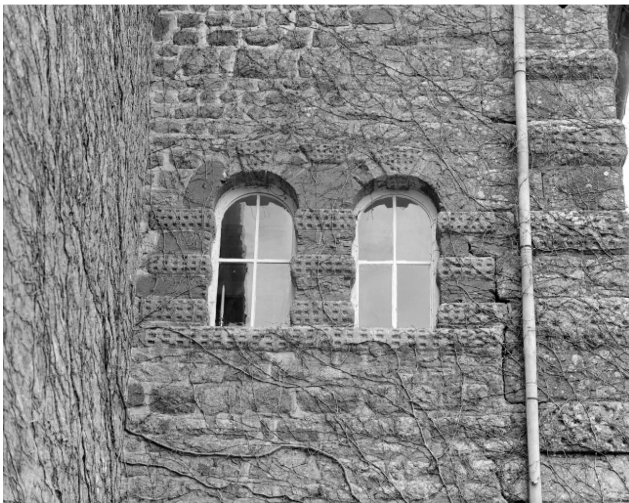
Pavillon est : baies jumelées, vue de détail.
