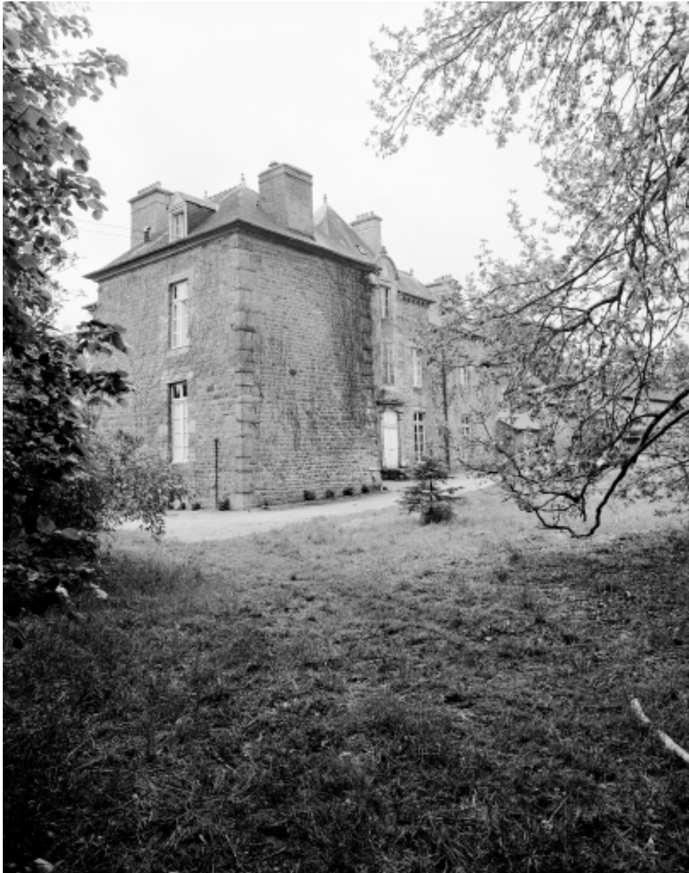
Pavillon est : vue générale du nord-est.
