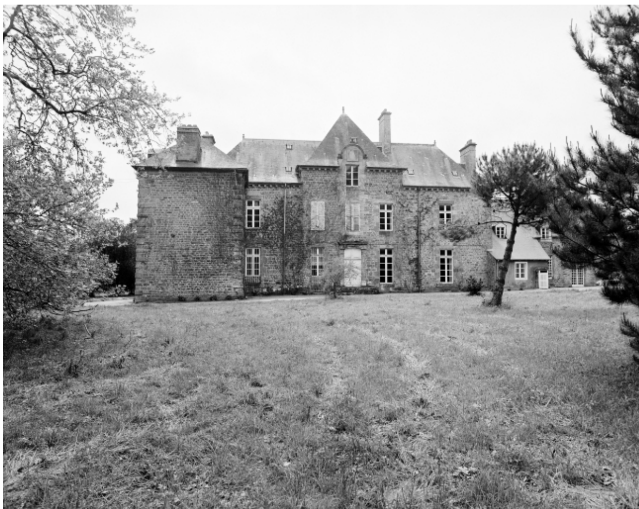
Elévation nord : vue générale.
