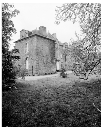
Pavillon est : vue générale du nord-est.
