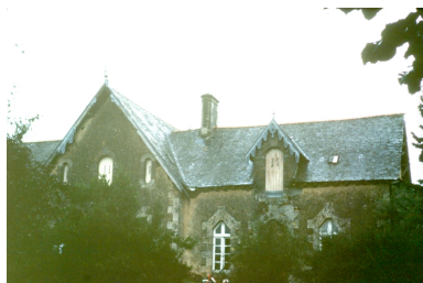
Métairie : logis, vue générale Phot. Denise Dufief, Repro. Norbert Lambart IVR53_19843501604ZA
