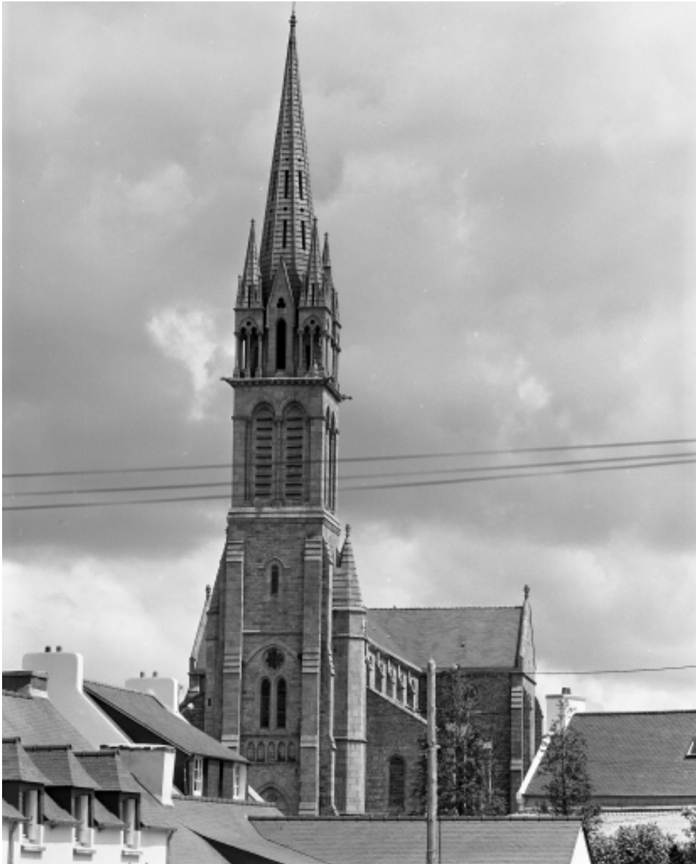
Plouéan, église paroissiale Saint-Pierre : vue générale ouest, état en 1986
