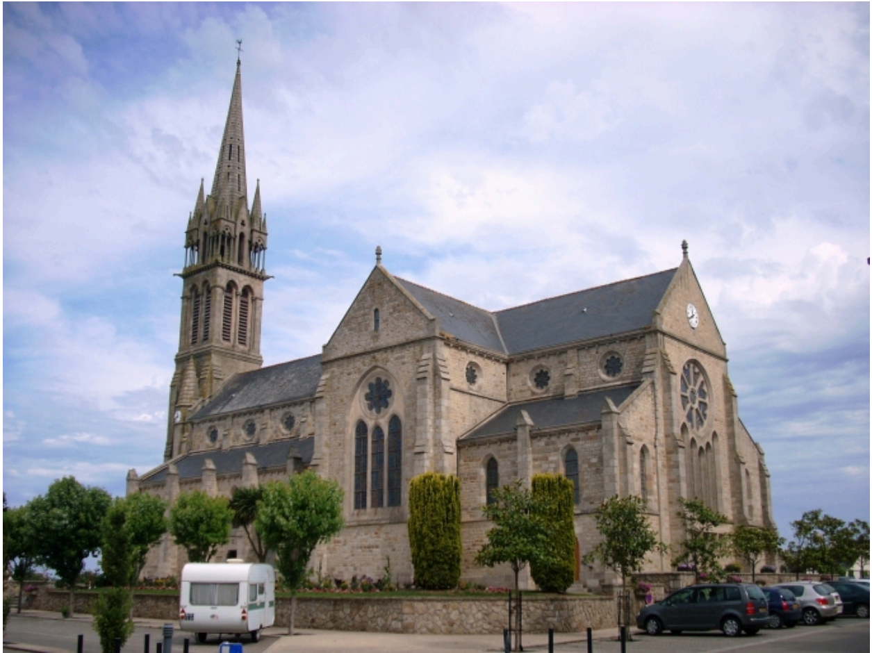
Plouénan, église paroissiale Saint-Pierre : vue générale sud-est
