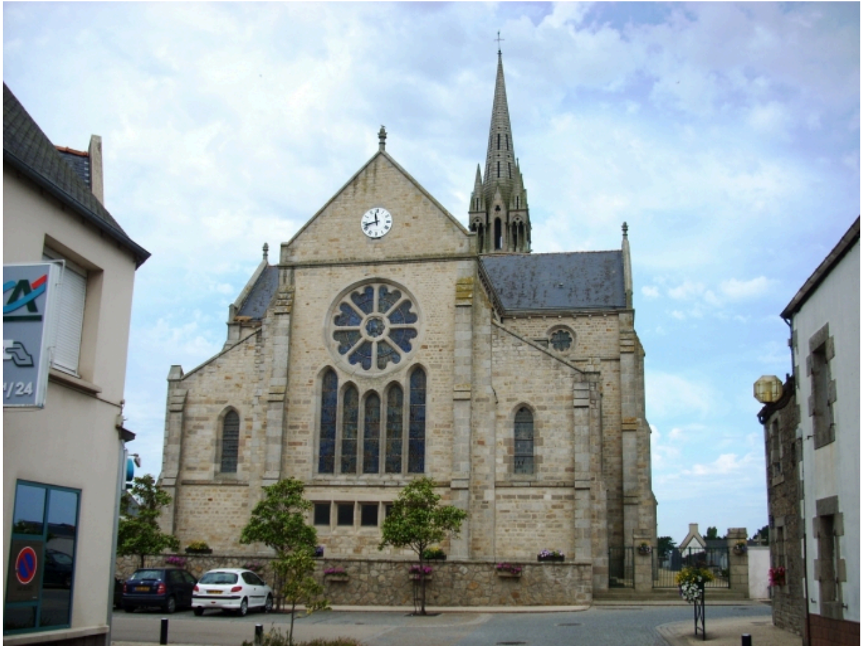
Plouéan, église paroissiale Saint-Pierre : vue générale est
