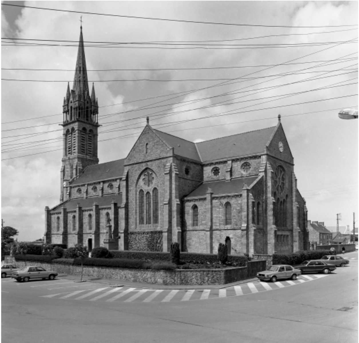
Plouénan, église paroissiale Saint-Pierre : vue générale sud-est, état en 1986
