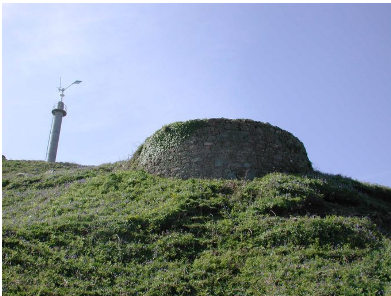
Vue générale de la batterie nord-est de l'île aux Moines
