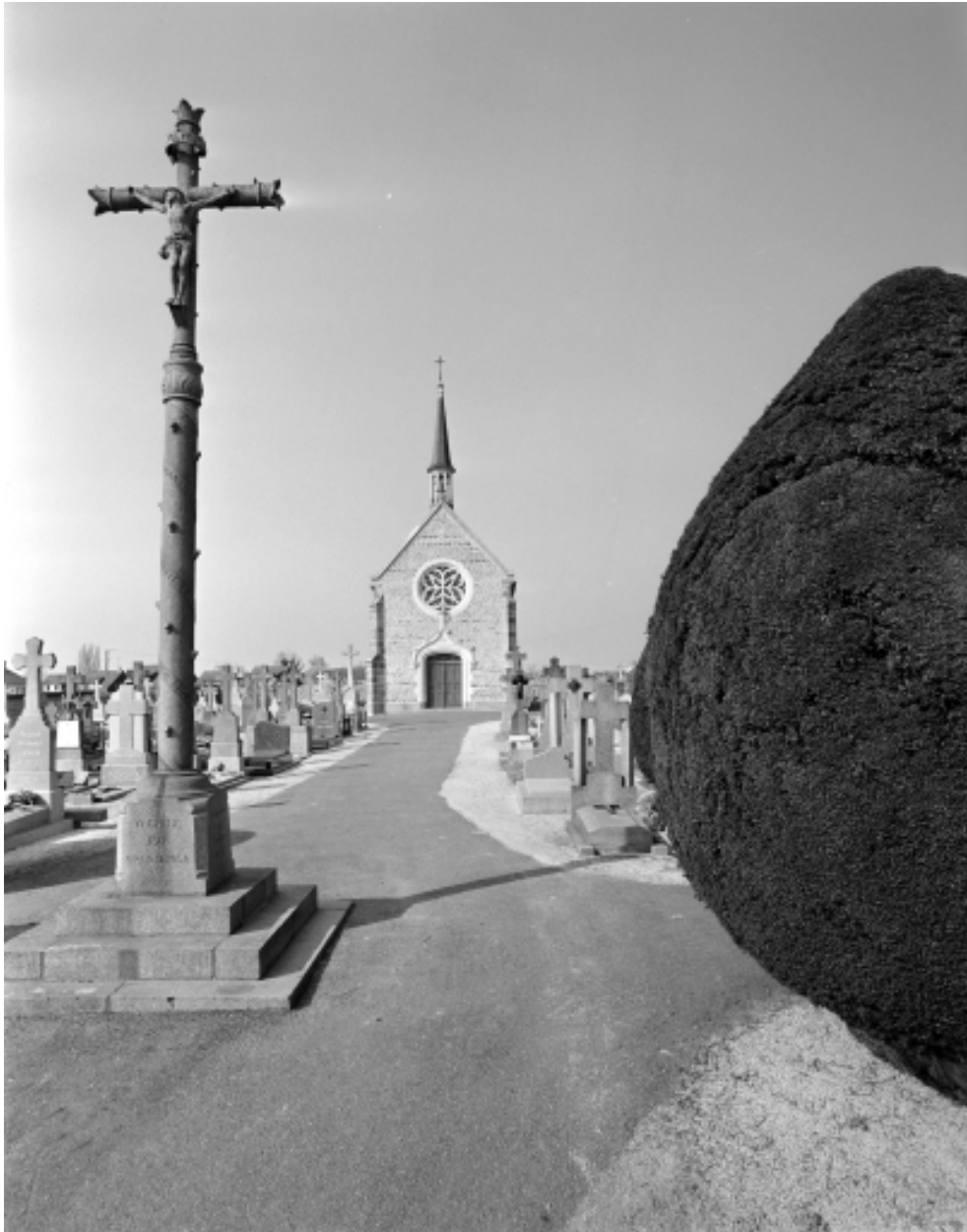
Elévation ouest : vue de situation
