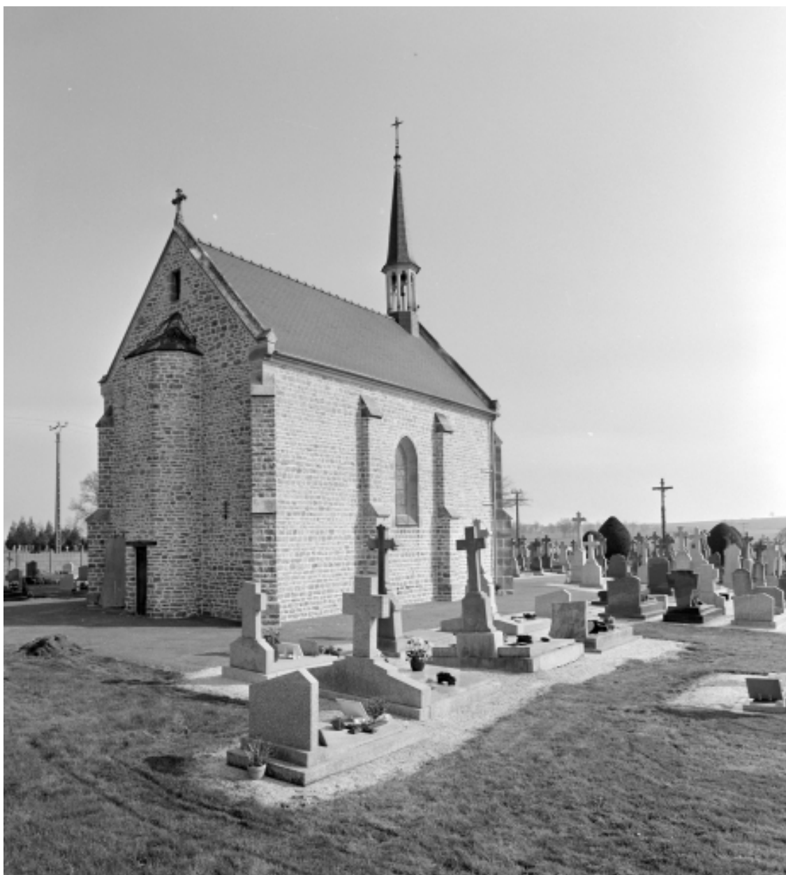
Elévation est : vue générale
