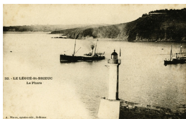
Vue du phare, au passage de deux vapeurs, en 1900 (carte postale, AD 22) Phot. Armand Waron, Autr. Armand Waron IVR53_20082213071NUCB
