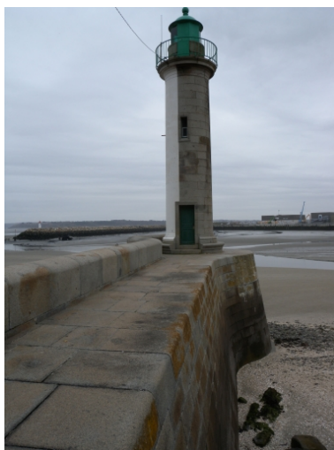
Vue de la façade Est de la jetée : remarquer le parapet et le pavage en granite Phot. Guy Prigent IVR53_20082213426NUCA
