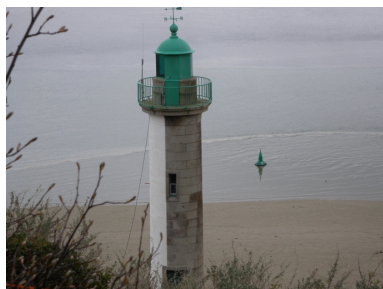
Vue de détail de la tourelle : remarquer la lanterne en cuivre et la balustrade en fer forgé Phot. Guy Prigent IVR53_20082213429NUCA
