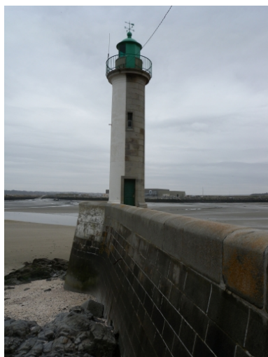
Vue de la façade Ouest de la jetée : remarquer le mur en pierre de taille Phot. Guy Prigent IVR53_20082213427NUCA
