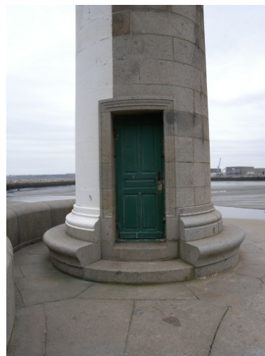
Vue de détail de la façade Sud de la tourelle : remarquer la porte d'entrée avec les moulures en granite, les chanfreins et l'évasement du pied de la tourelle Phot. Guy Prigent IVR53_20082213428NUCA
