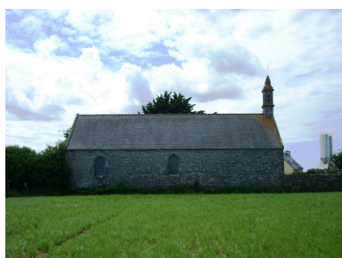
Ploudalmézeau, chapelle Saint-Roch : élévation nord Phot. Gwénaél Fauchille IVR53_20082906178NUCA
