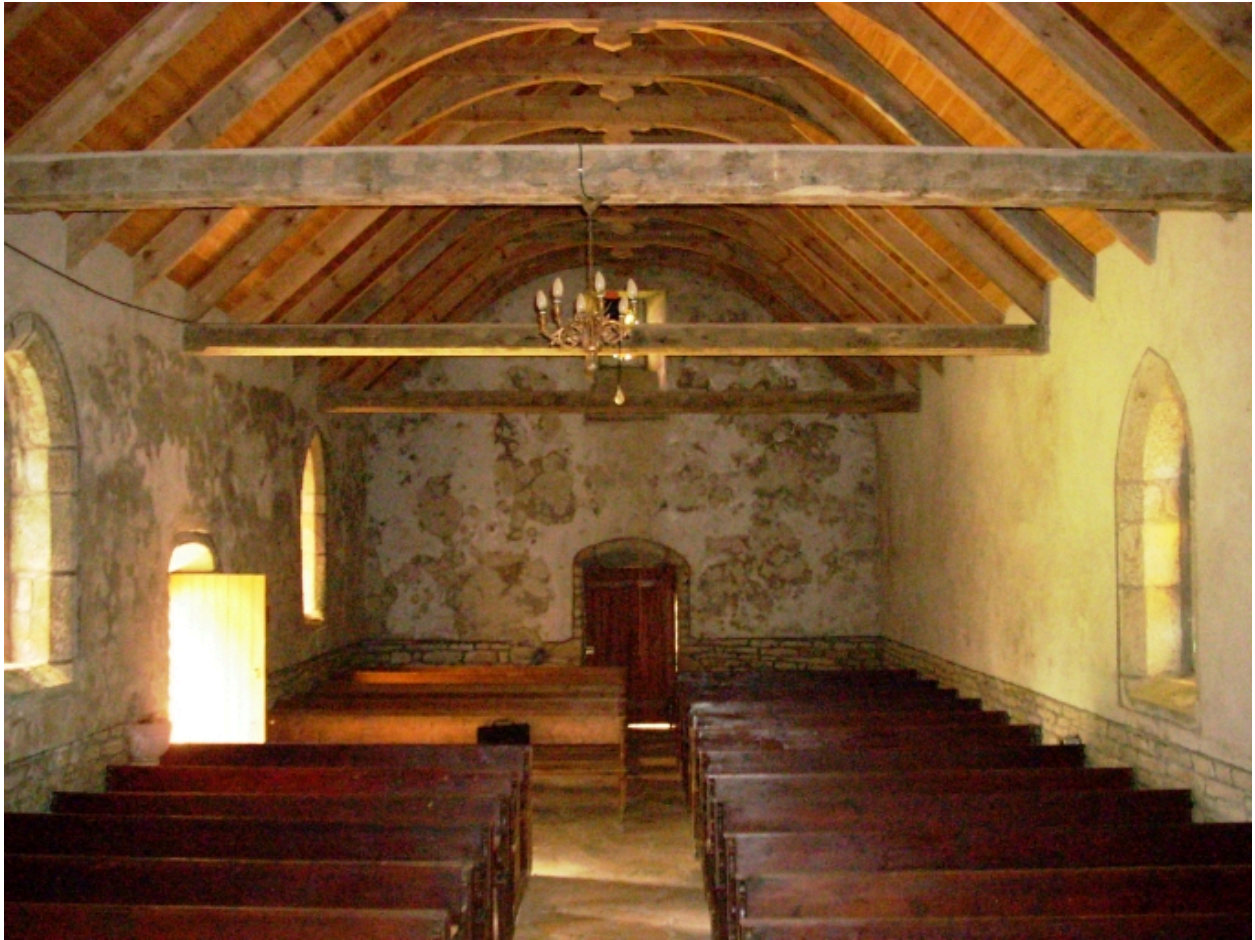
Ploudalmézeau, chapelle Saint-Roch : vue axiale ouest
