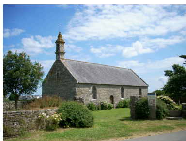
Ploudalmézeau, chapelle Saint-Roch : vue générale sud-ouest Phot. Gwénaél Fauchille IVR53_20082906175NUCA
