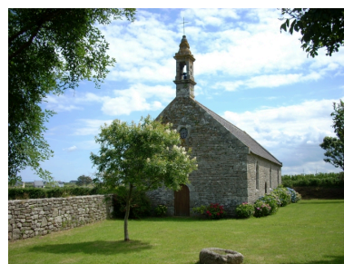
Ploudalmézeau, chapelle Saint-Roch : vue générale sud-ouest Phot. Gwénaél Fauchille IVR53_20082906177NUCA
