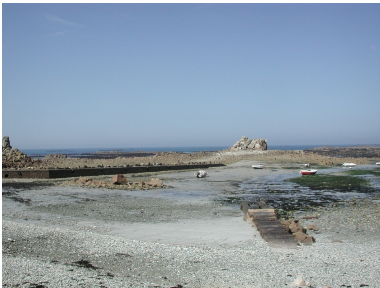
Vue générale de la nouvelle cale et des vestiges des anciens aménagements portuaires (môles de pierre)
