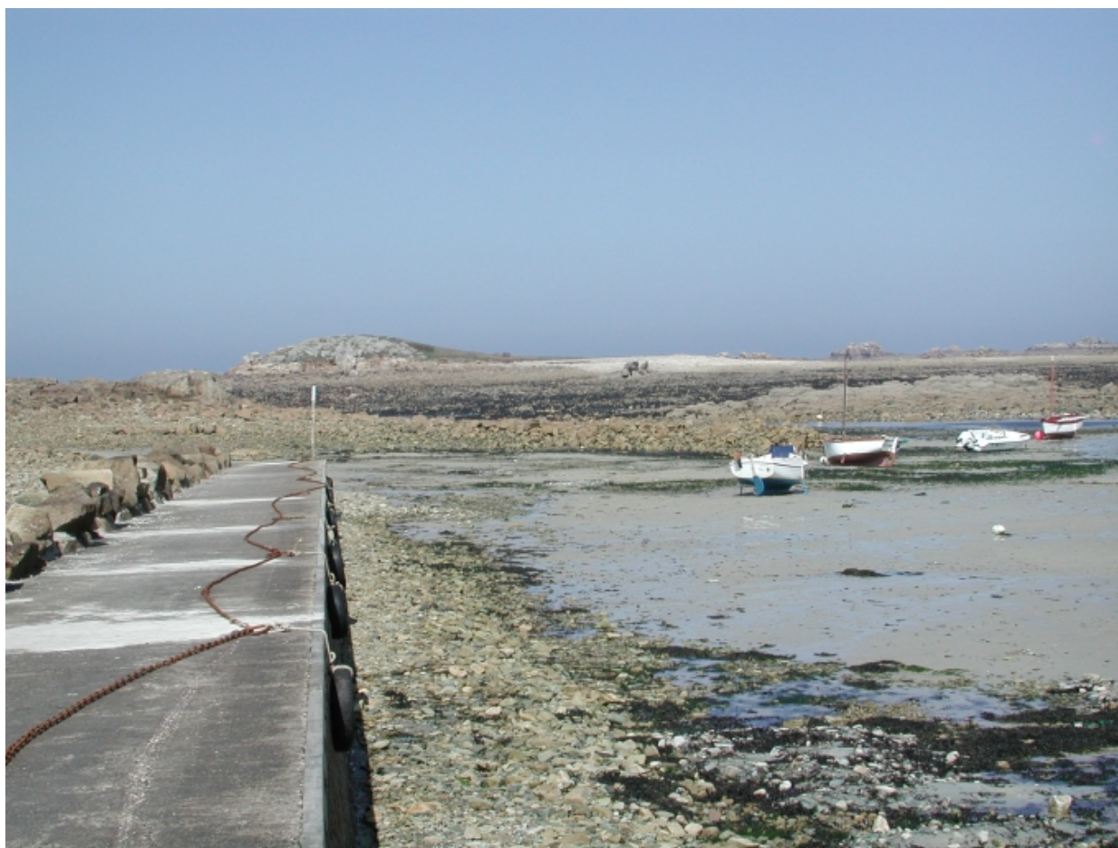
Vue de la cale de marée haute : remarquer la faiblesse de la pente
