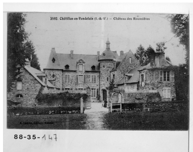
Vue de la façade principale Phot. Guy Artur, Phot. Norbert Lambart, Autr. Alexandre Lamiré IVR53_19883500147X
