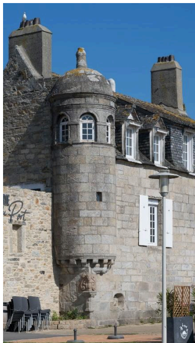
Echauguette, embrasure : fonction défensive de cette maison de négociant Phot. Charlotte Barraud IVR53_20252901047NUCA
