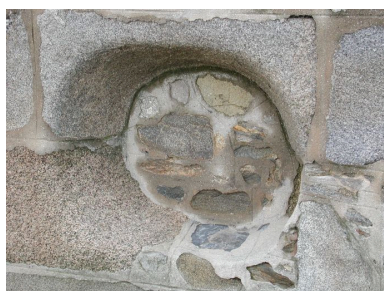
Vue de détail de l'élévation est : embrasure de plan circulaire (état en 2002) Phot. Guillaume Lécueillier IVR53_20022901972NUCA
