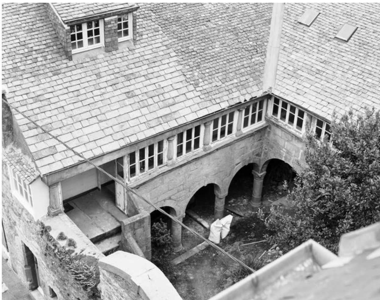
Vue générale prise de la chambre n° 21 de l'Hôtel du Centre : cour et galerie d'arcades en arc plein cintre (état en 1985)
