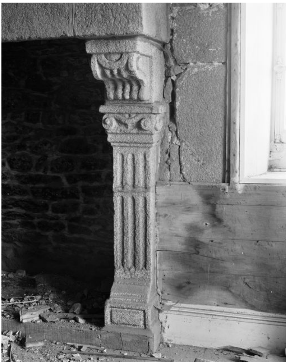
Vue de détail de l'un des piédroits de la cheminée située au premier étage (état en 1985)
