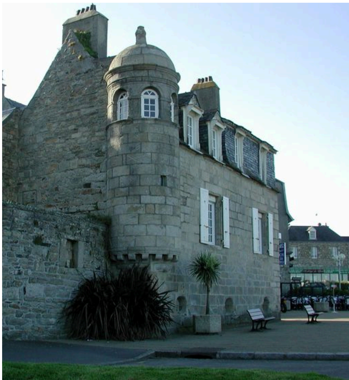
Vue générale depuis le sud-est (état en 2002)
