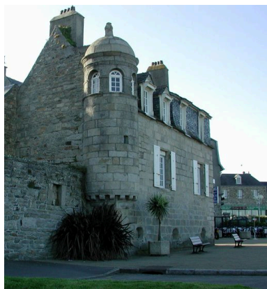
Vue générale depuis le sud-est (état en 2002) Phot. Guillaume Lécueillier IVR53_20022902201NUCA
