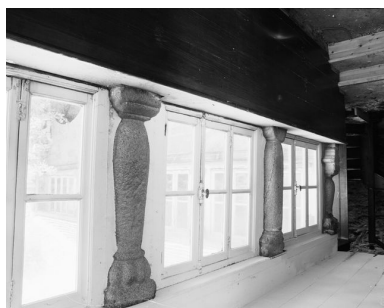
Vue générale prise de la porte d'entrée en enfilade : galerie et colonettes (état en 1985) Phot. Guy Artur, Phot. Norbert Lambart IVR53_19852901059X
