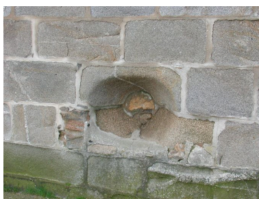
Vue de détail de l'élévation est : embrasure de plan circulaire (état en 2002) Phot. Guillaume Lécueillier IVR53_20022901971NUCA
