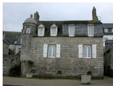
Vue générale : élévation est sur le port de Roscoff (état en 2002) Phot. Guillaume Lécueillier IVR53_20022901969NUCA
