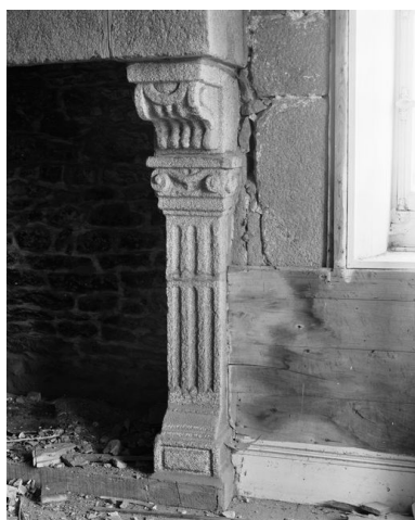
Vue de détail de l'un des piédroits de la cheminée située au premier étage (état en 1985) Phot. Guy Artur, Phot. Norbert Lambart IVR53_19852901058X
