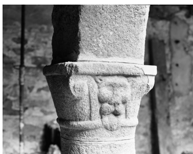
Vue de la cour et de la galerie d'arcades en arc plein cintre : angle sud-est, détail du chapiteau de l'une des colonnes (état en 1985) Phot. Guy Artur, Phot. Norbert Lambart IVR53_19852901064X
