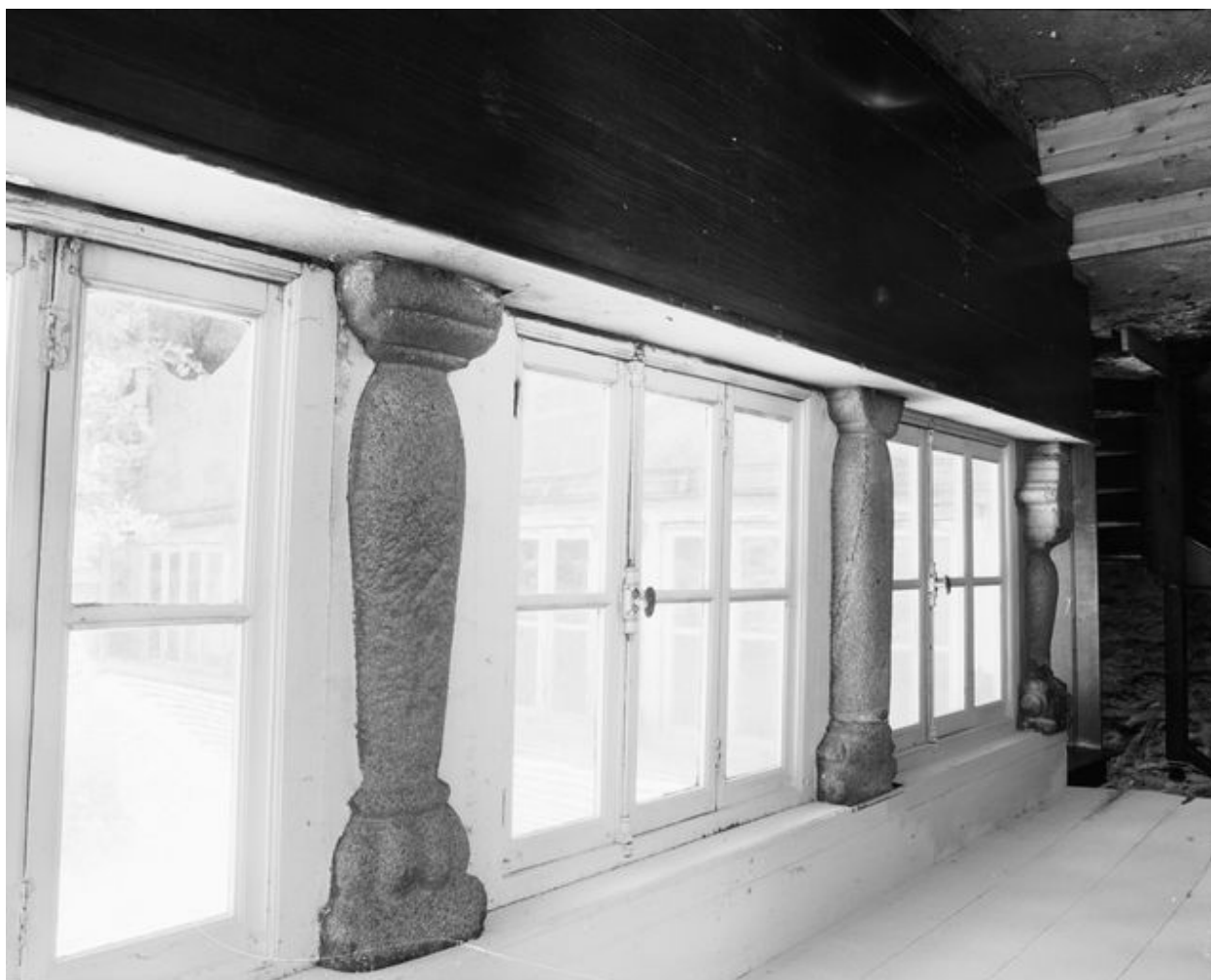
Vue générale prise de la porte d'entrée en enfilade : galerie et colonettes (état en 1985)
