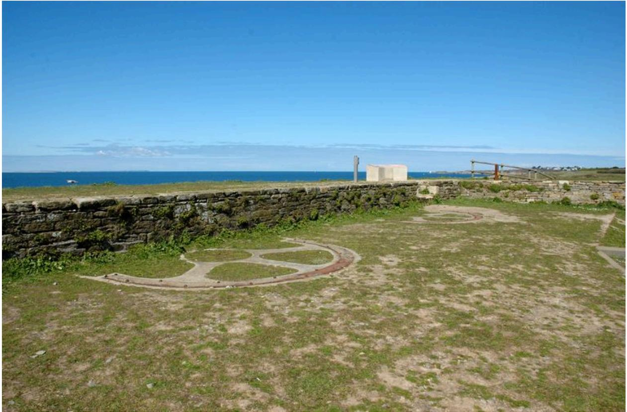
Vue de la batterie d'artillerie de côte et de sa plate-forme : emplacement des sellettes d'affût en demi-cercle reposant sur du béton pour les deux canons de 90 mm du poste de défense contre les sous-marins
