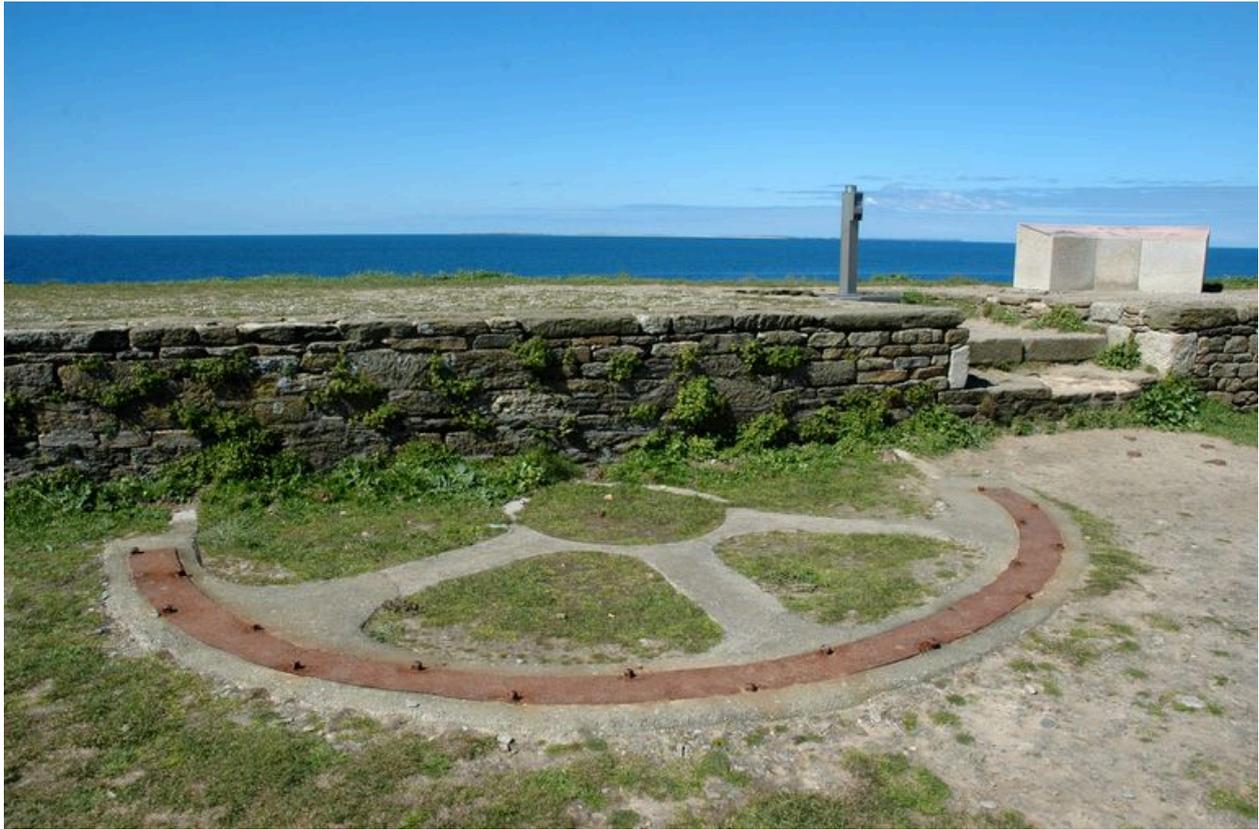
Vue de la batterie d'artillerie de côte et de sa plate-forme : emplacement de l'une des deux sellettes d'affût en demi-cercle reposant sur du béton pour un canon de 90 mm du poste de défense contre les sous-marins
