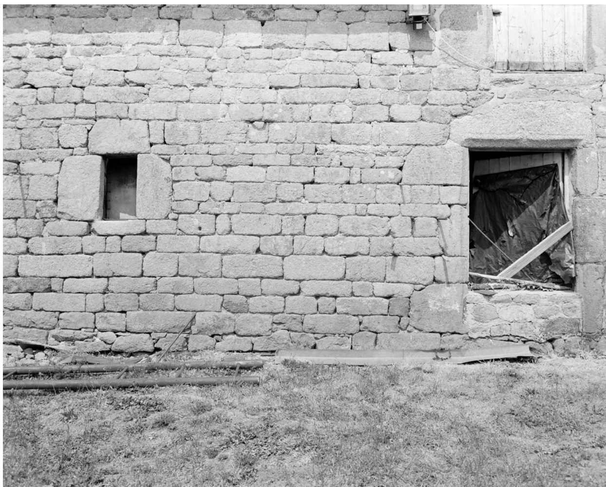
Loquion : ferme, détail d'appareillage.
