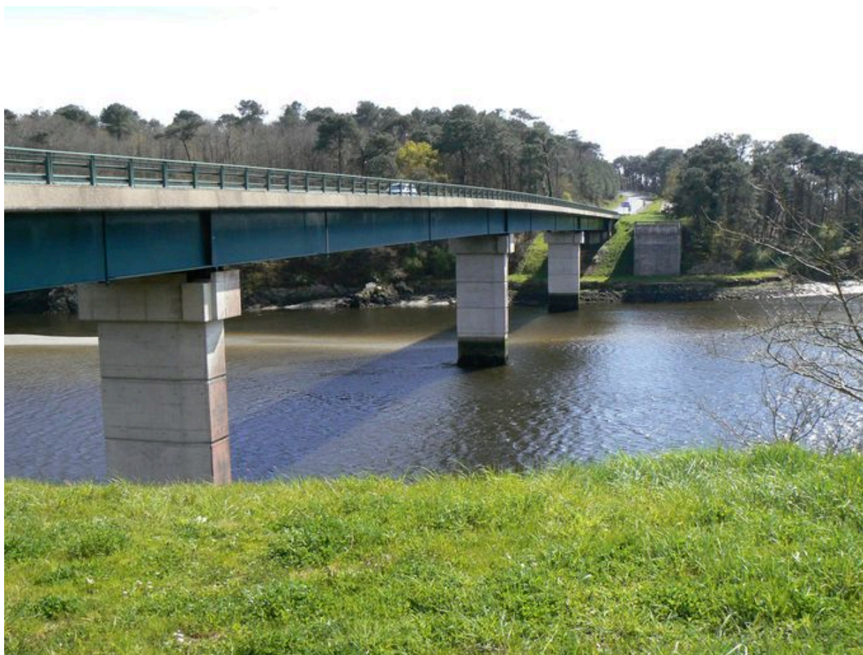
Nouveau pont de Saint-Maurice construit sur la Laïta en 1994
