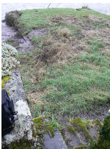
Vestiges de l'escalier permettant d'atteindre la cale accessible à marée basse Phot. Julien Amghar IVR53_20082908667NUCA
