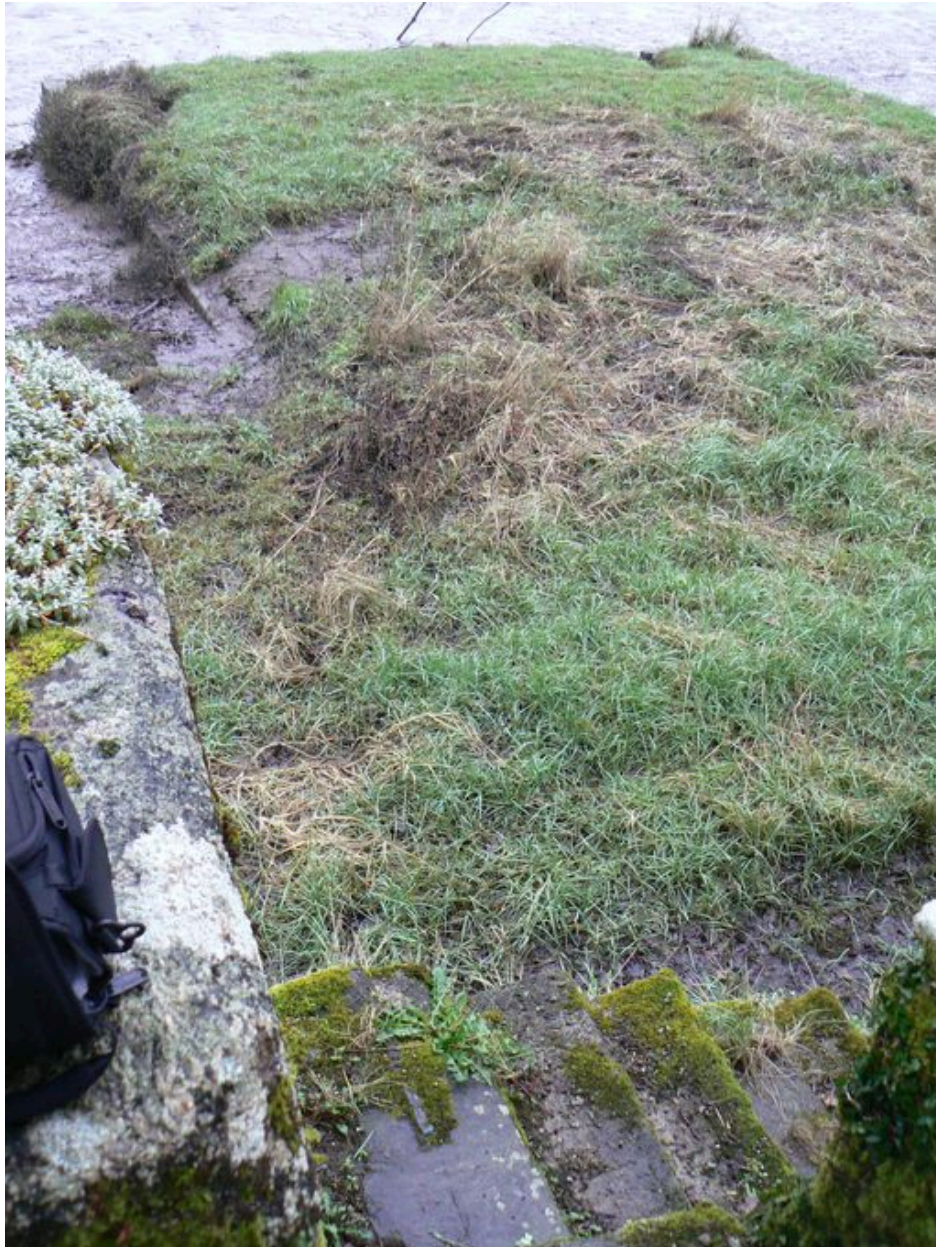
Vestiges de l'escalier permettant d'atteindre la cale accessible à marée basse
