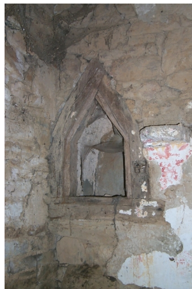
Intérieur, mur nord du chœur, niche-crédence en bois Phot. Xavier Gilbert IVR53_20013509876NUCA
