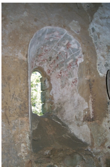
Intérieur, mur nord, baie romane avec des traces d'enduit peint en faux appareillage Phot. Xavier Gilbert IVR53_20013509869NUCA
