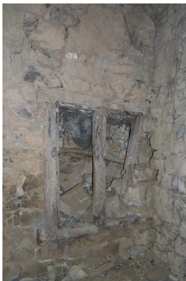
Intérieur, mur sud du chœur, armoire murale Phot. Xavier Gilbert IVR53_20013509875NUCA
