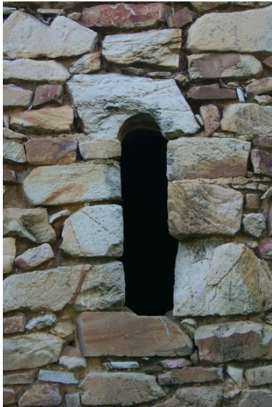
Nef, mur nord, détail baie Phot. Xavier Gilbert IVR53_20013509859NUCA
