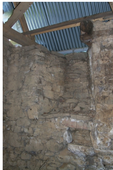
Intérieur, mur sud, baie éclairant le chœur Phot. Xavier Gilbert IVR53_20013509873NUCA
