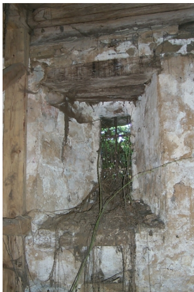
Intérieur, mur sud, baie Phot. Xavier Gilbert IVR53_20013509872NUCA
