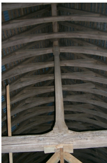
Intérieur, charpente, vue partielle Phot. Xavier Gilbert IVR53_20013509866NUCA
