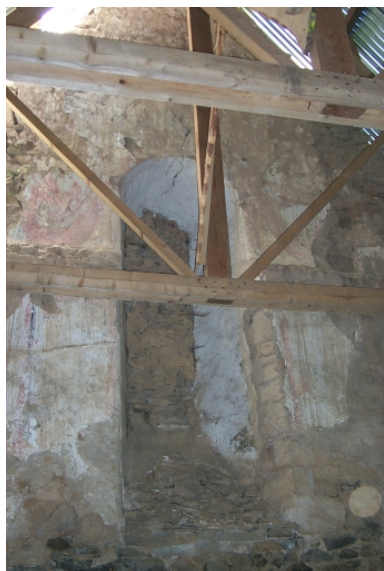
Intérieur, baie du chevet Phot. Xavier Gilbert IVR53_20013509874NUCA
