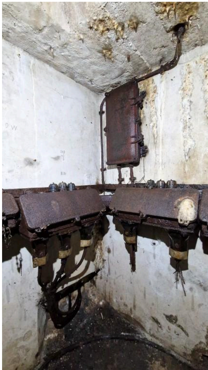
Vue intérieure : ensemble de plusieurs boîtiers de connexion. Sur le mur peint en blanc : des instructions tracées au crayon gris pour connecter les câbles
