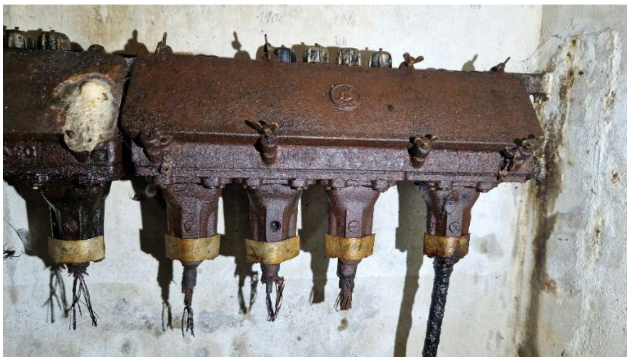
Vue intérieure : ensemble de plusieurs boîtiers de connexion (boîtier implanté à droite). Sur le mur peint en blanc : des instructions tracées au crayon gris pour connecter les câbles
