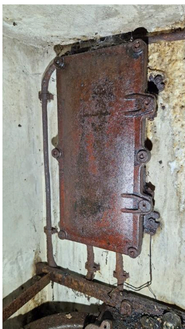
Vue intérieure : ensemble de plusieurs boîtiers de connexion Phot. Guillaume Lécueillier IVR53_20255632934NUCA
