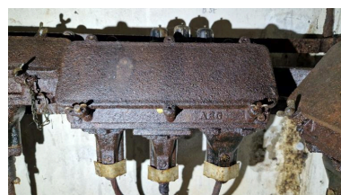
Vue intérieure : ensemble de plusieurs boîtiers de connexion (boîtier implanté contre le mur de gauche). Sur le mur peint en blanc : des instructions tracées au crayon gris pour connecter les câbles Phot. Guillaume Lécueillier IVR53_20255632935NUCA
