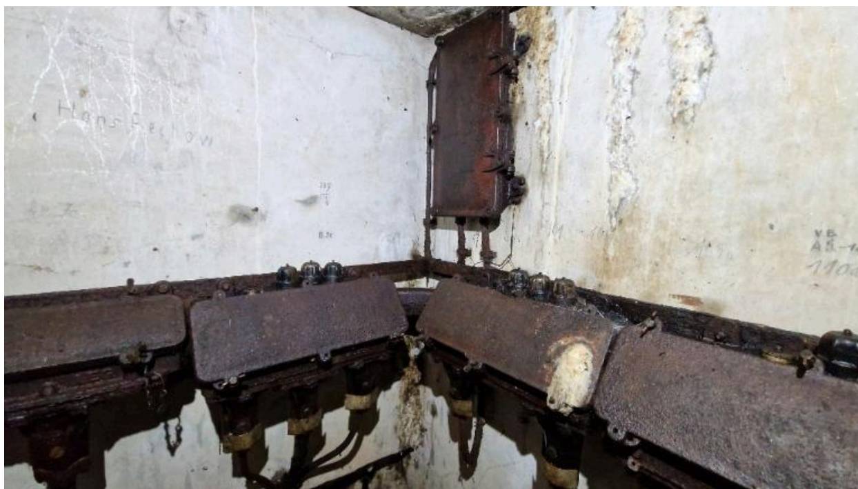
Vue intérieure : ensemble de plusieurs boîtiers de connexion. Sur le mur peint en blanc : des instructions tracées au crayon gris pour connecter les câbles et un nom (Hans Fechow)
