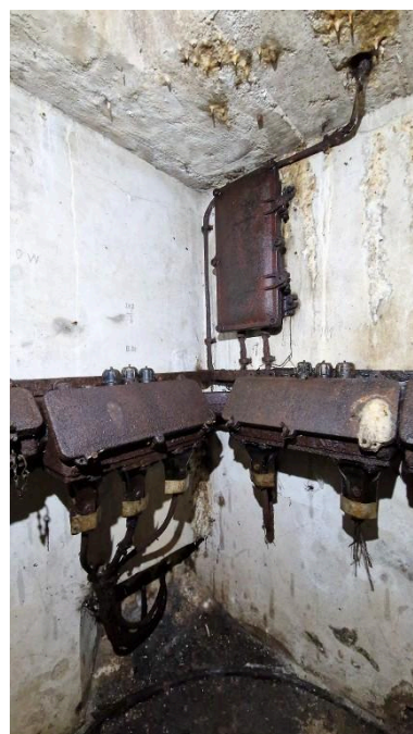
Vue intérieure : ensemble de plusieurs boîtiers de connexion. Sur le mur peint en blanc : des instructions tracées au crayon gris pour connecter les câbles Phot. Guillaume Lécueillier IVR53_20255632933NUCA
