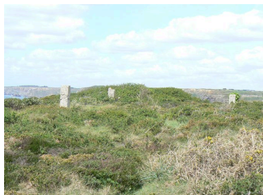
Vue générale des vestiges de la batterie de côte et du corps de garde de la Mort aux Anglais Phot. Lénaïg L'Aot IVR53_20072908575NUCA
