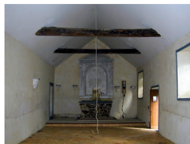
Intérieur : vue générale vers le chœur Phot. Malo Pichot IVR53_20023514208NUCA
