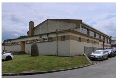
Vue générale prise du nord-ouest Phot. Alina Tarskikh IVR53_20192205123NUCA
