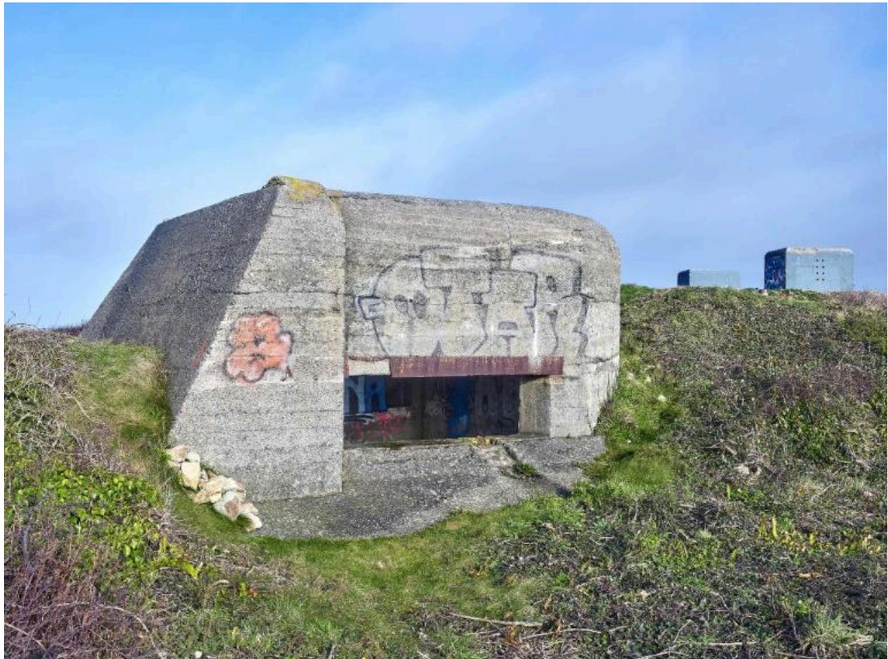
Vue générale : élévation sud côté embrasure. A gauche, petit mur de flanquement protégeant l'embrasure des coups venant de l'ouest. En arrière-plan, le bunker pour radar Mammot
