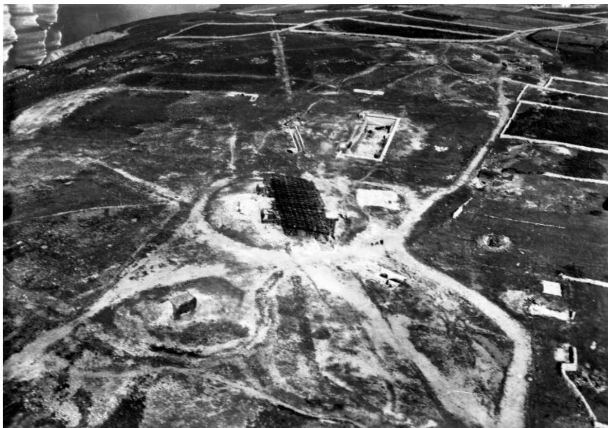
Vue aérienne oblique depuis l'ouest-sud-ouest, vers 1946 (photographie extraite du rapport Pinczon du Sel). L'antenne du radar Mammut, en cours de démantèlement, est couchée sur le sol vers le sud-est ; on distingue les deux conduits d'antenne
