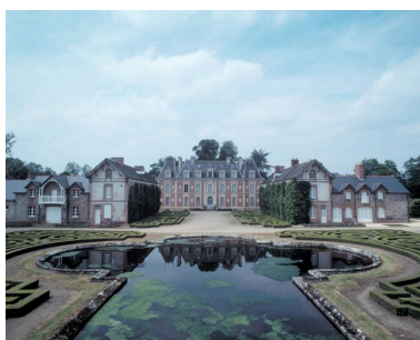
Château et dépendances : vue générale prise du sud-est Phot. Norbert Lambart IVR53_19945600690XA
