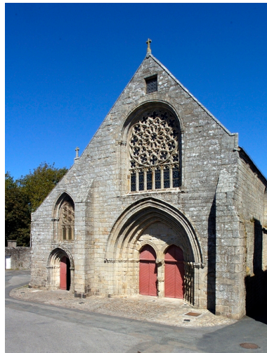
Pont L'Abbé. Eglise Notre Dame des Carmes. Vue de la façade ouest. Phot. Norbert Lambart IVR53_20072900206NUCA
