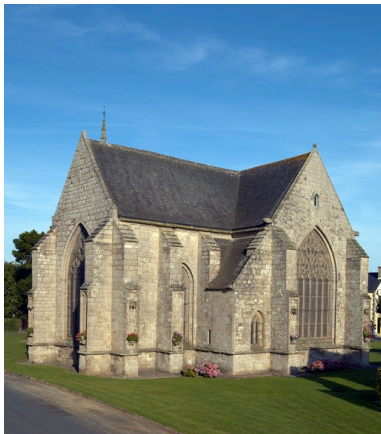
Lantic. Chapelle Notre-Dame de la Cour. Vue du chevet et du bras sud Phot. Norbert Lambart IVR53_20072200182NUCA
