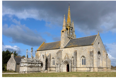
Saint-Jean-Trolimon. Chapelle Notre-Dame de Tronoën. Vue générale depuis le sud-est Phot. Alain Dagorn IVR53_20072900211NUCA
