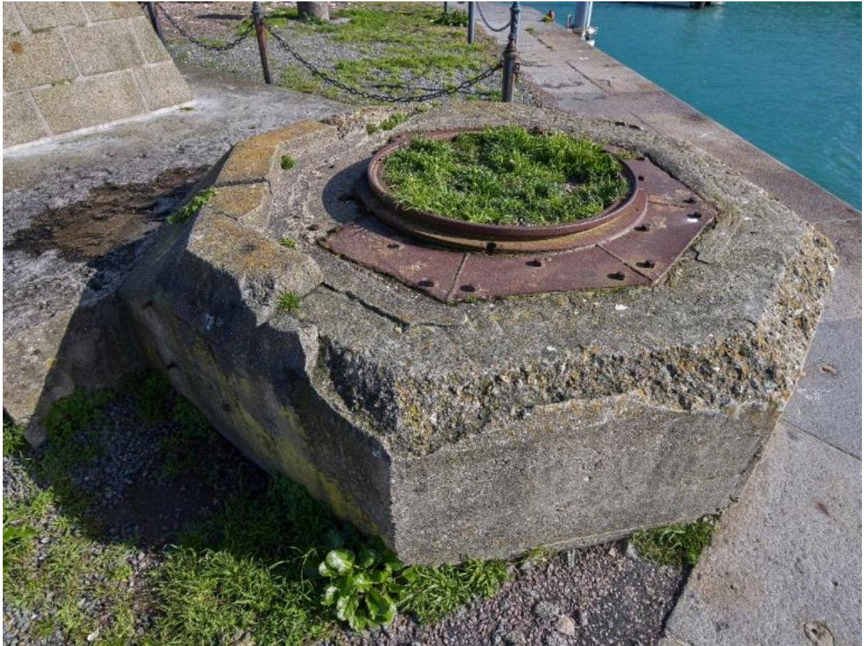
Vue de détail : chemin de roulement de la tourelle de char de combat
