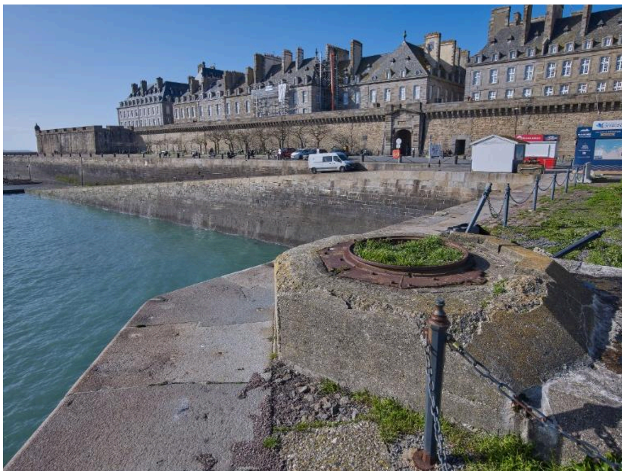
Vue de situation. Implanté à l'angle du quai, le bunker domine la cale de la Bourse. En arrière-plan, A droite, les remparts et immeubles de Saint-Malo
