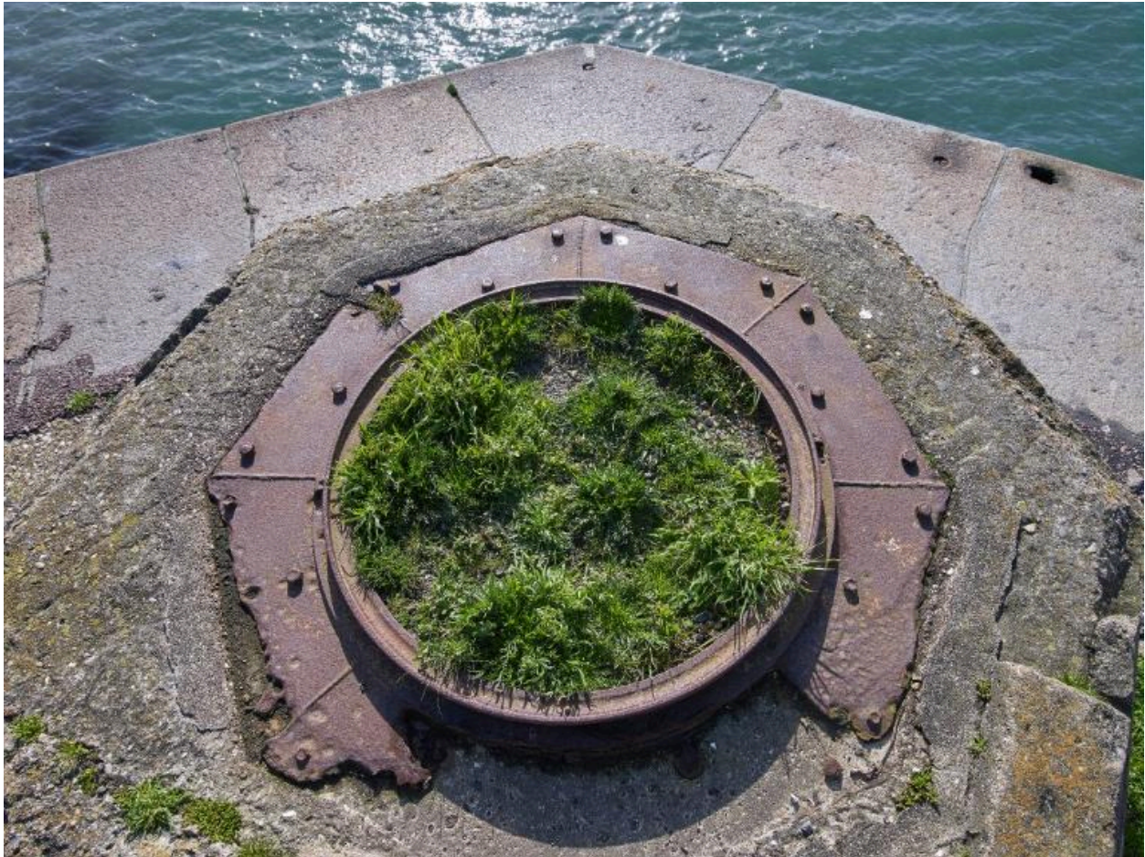
Vue de détail : chemin de roulement de la tourelle de char de combat
