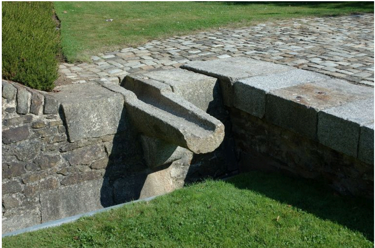
Vue des vestiges des fortifications d'agglomération de Brest dans le square Mathon : gargouille de la chaussée de la porte de Saint-Louis percée en 1821 dans la demi-lune de Landerneau datant de la fin du 17 e siècle
