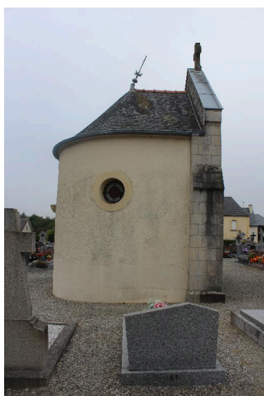
Côté est : vue générale Phot. Déborah De Sousa Figueiredo IVR53_20163505758NUCA
