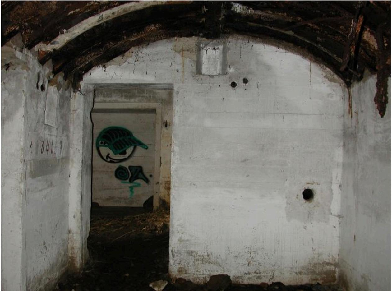
Vue intérieure du poste de commandement (état en 2002). Il s'agit d'un bunker de type VF2c, "tôle métro"
