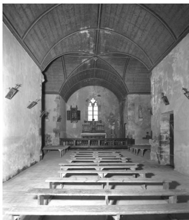
Vue générale intérieure d'ouest en est Phot. François Dagorn IVR53_19672900219V
