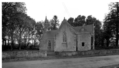
Vue générale sud Phot. François Dagorn IVR53_19672900220V
