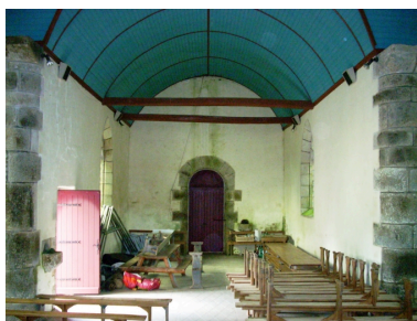
Vue axiale ouest. Phot. Gwénaél Fauchille IVR53_20082905827NUCA
