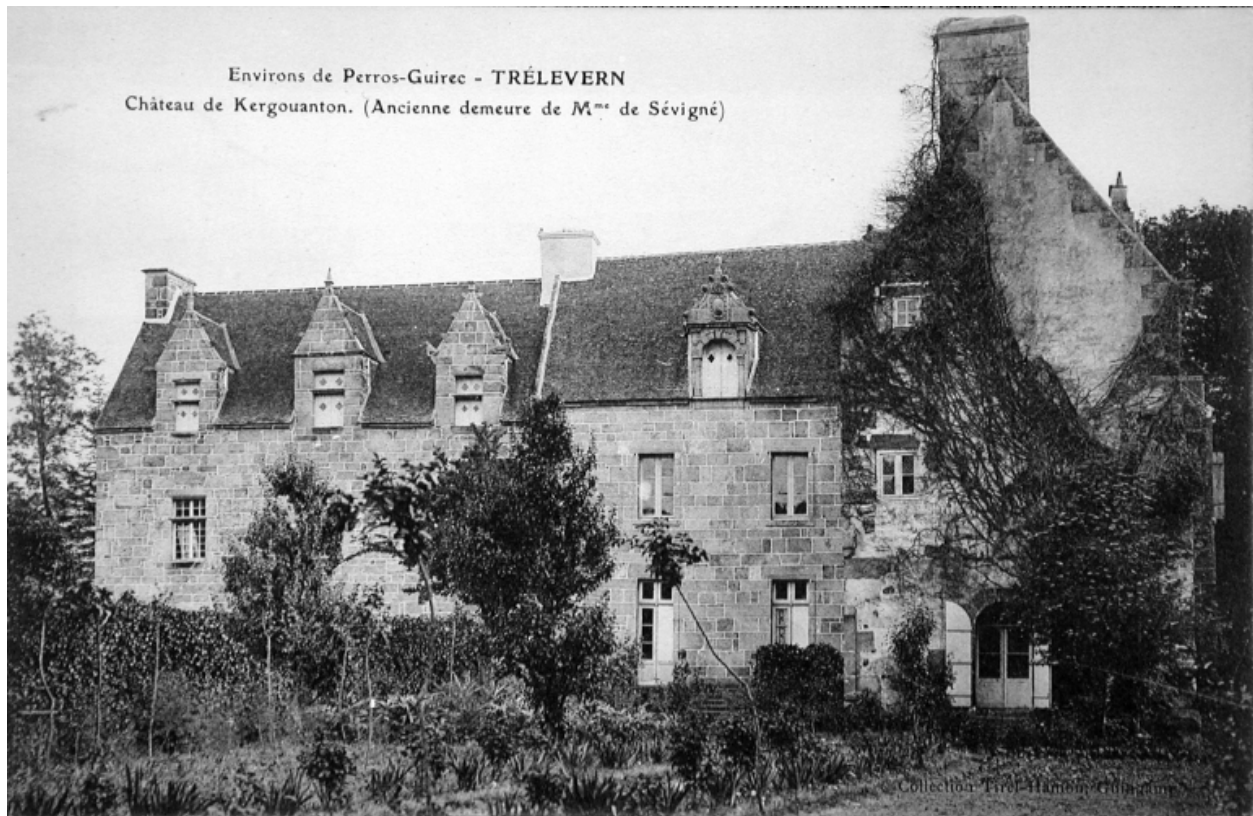
Vue générale avant restauration
