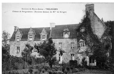
Vue générale avant restauration Phot. Elise Lauranceau IVR53_20042209071NUCB
