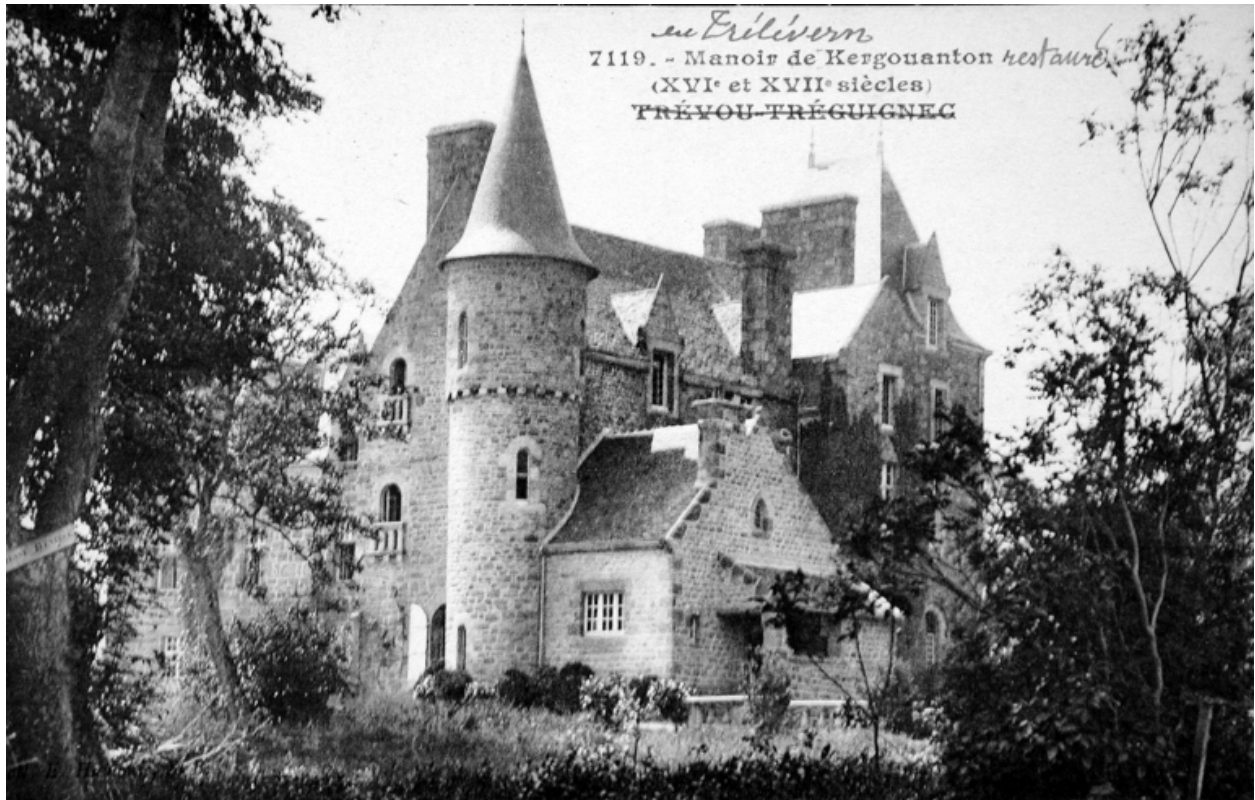
Vue générale après restauration
