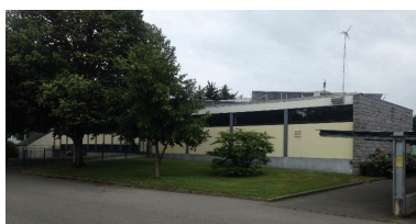
Vue générale prise du nord Phot. Simon Vely IVR53_20165605341NUCA
