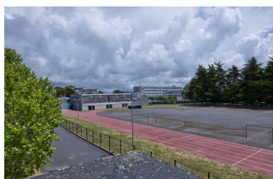
Vue d'ensemble du gymnase et du plateau d'évolution, prise de l'ouest. A l'arrière plan, le LP Marie-Le-Franc. Phot. Bernard Bègne IVR53_20205600517NUCA
