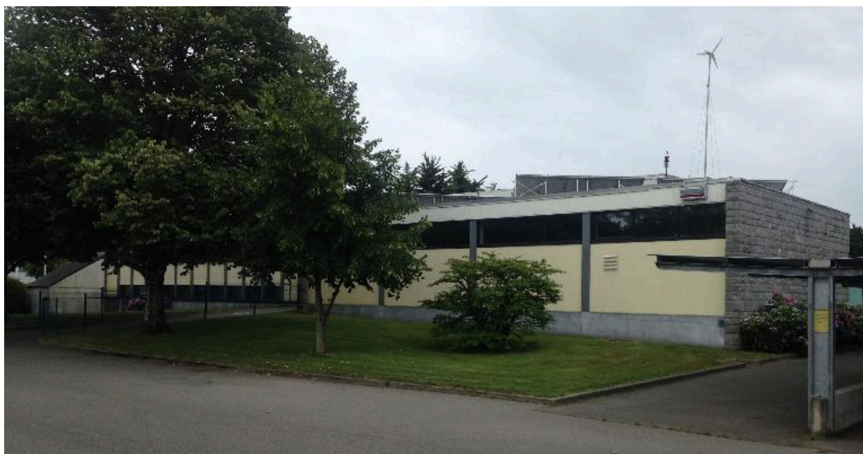
Vue générale prise du nord
