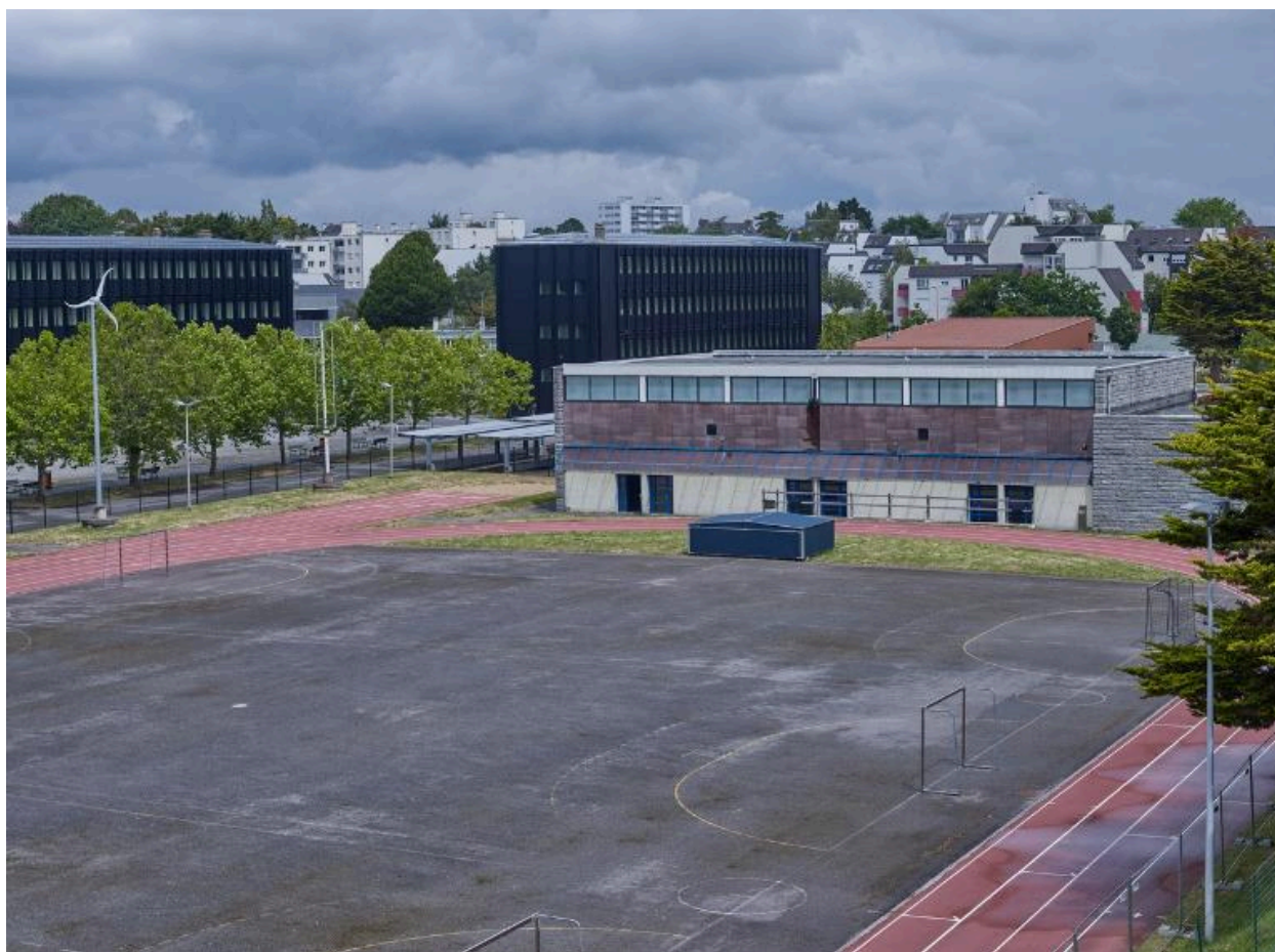
Façade sud-ouest. A l'arrière plan, les externats B et C du lycée.
