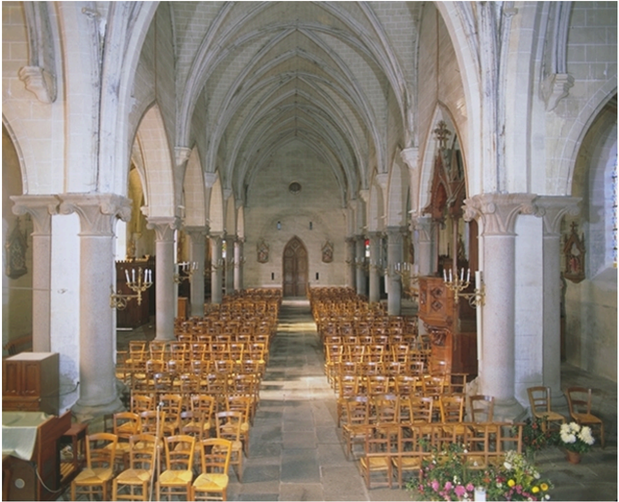
Vue générale vers la nef
