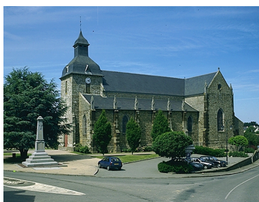
Vue générale sud-ouest Phot. Guy Artur, Phot. Norbert Lambart IVR53_19993500542XA
