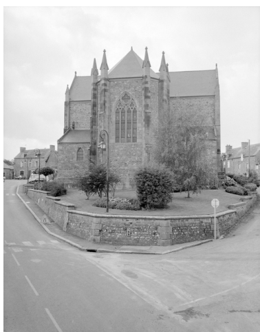
Vue générale est Phot. Guy Artur, Phot. Norbert Lambart IVR53_19943501806X
