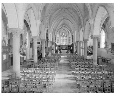
Vue générale vers le chœur Phot. Service régional de l'Inventaire de Bretagne IVR53_19973501734X
