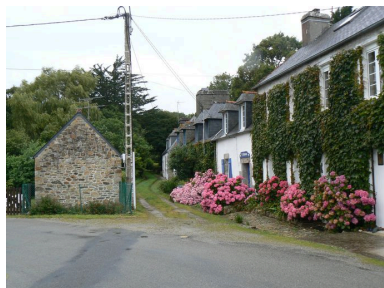
Edifice logistique de la Marine devenu auberge de jeunesse Phot. Lénaïg L'Aot IVR53_20072908939NUCA
