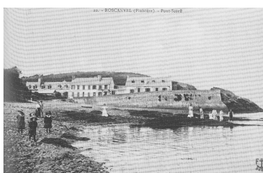
Carte postale : Pont-Scorff Repro. Florence Desprez IVR53_20082908505NUC
