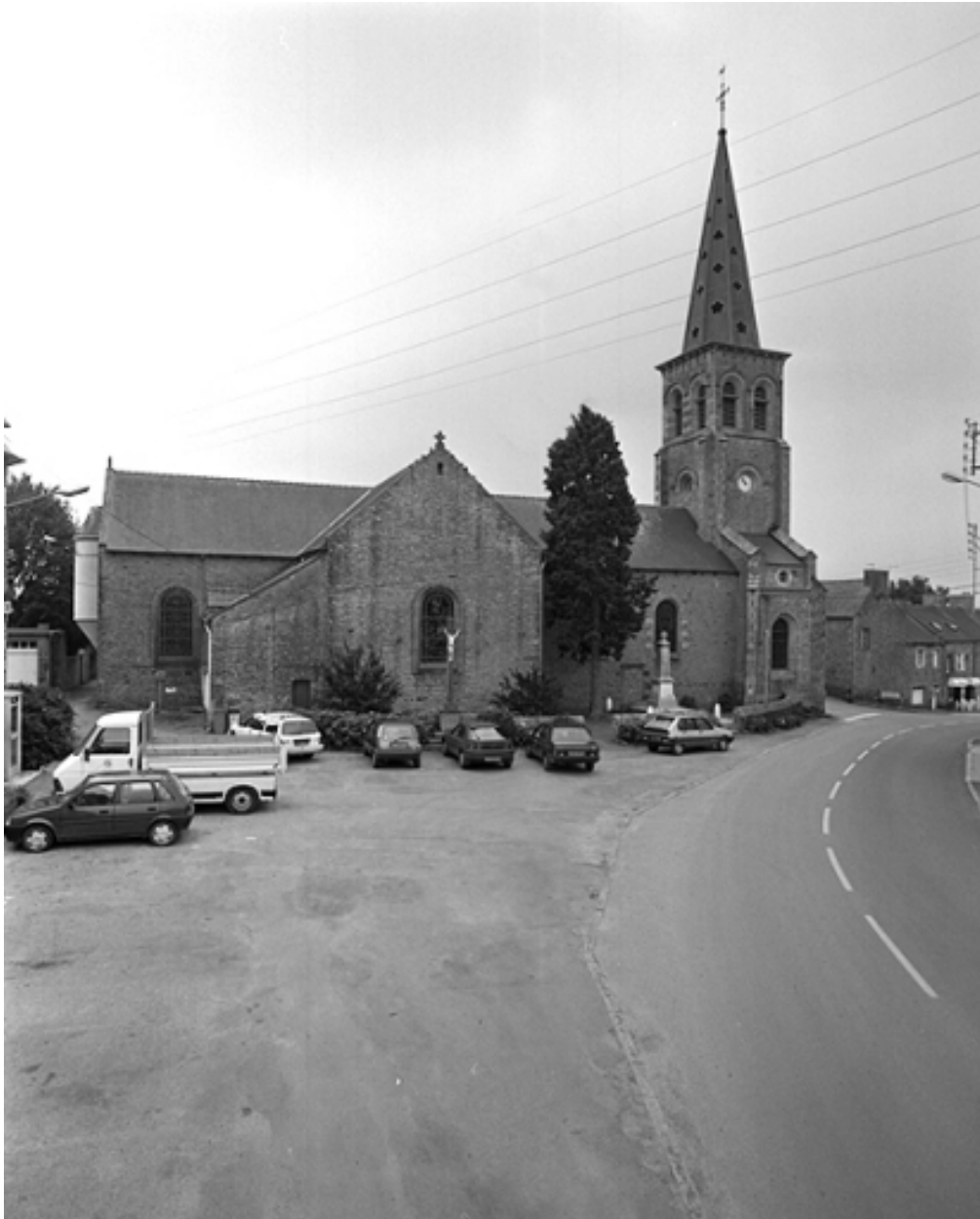
Vue générale nord
