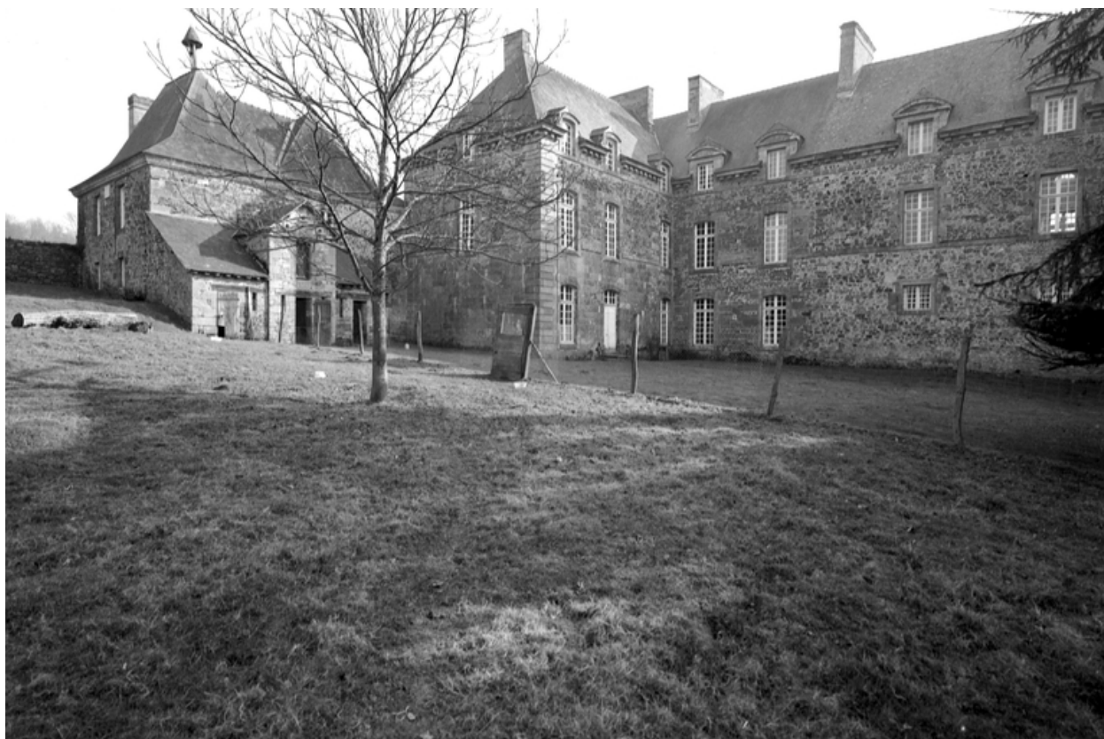
Château, façade nord, détail, enquête de 1969
