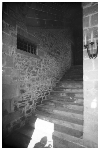
Escalier rampe sur rampe, départ de la 1ère volée, enquête de 1969 Phot. Guy Artur IVR53_19692200043V
