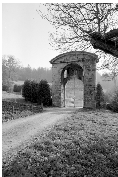
Portail sud, vue arrière, enquête de 1969 Phot. Guy Artur IVR53_19692200033V
