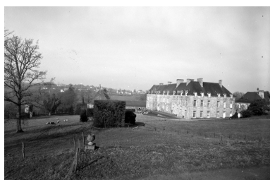
Château, vue générale sud-est, enquête de 1969 Phot. Guy Artur IVR53_19692200015V
