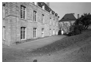
Château et maison du chapelain, enquête de 1969 Phot. Guy Artur IVR53_19692200024V
