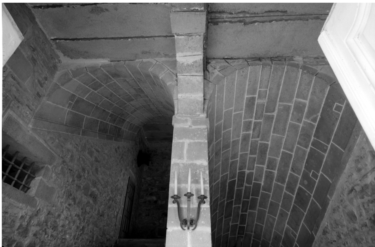
Escalier intérieur rampe sur rampe, détail des voûtes, enquête de 1969
