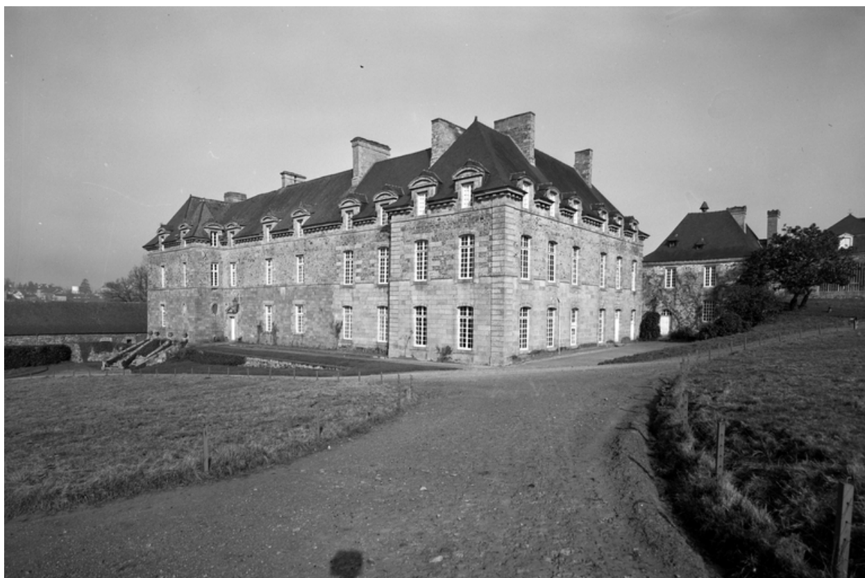
Château et maison du chapelain, vue générale sud-est, enquête de 1969
