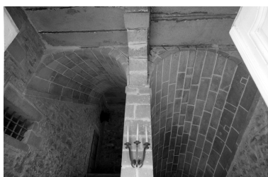
Escalier intérieur rampe sur rampe, détail des voûtes, enquête de 1969 Phot. Guy Artur IVR53_19692200040V
