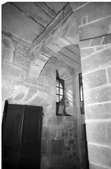
Escalier rampe sur rampe, détail de l'arc soutenant le palier du premier étage Phot. Guy Artur IVR53_19692200042V
