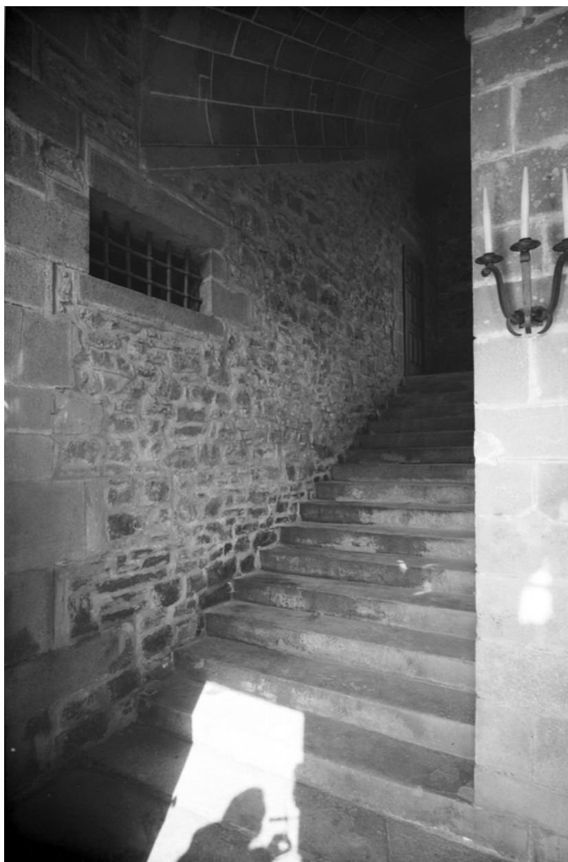
Escalier rampe sur rampe, départ de la 1ère volée, enquête de 1969
