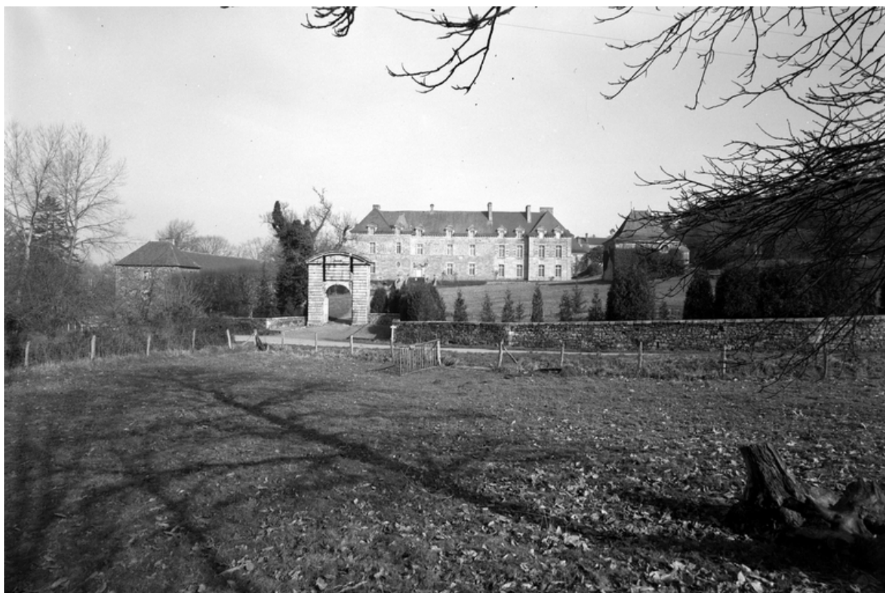
Château, vue générale sud, enquête de 1969
