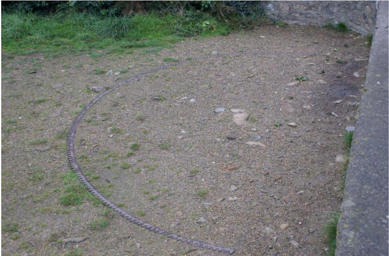
Détail d'un emplacement de batterie d'un canon de 90 mm modèle 1881 sur affût de côte modèle 1879 (photographie : Alain Bohée). La demi-couronne métallique dentelée permettait le pointage en azimut de l'affût
