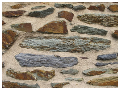
Mur-pignon sud : le matériau de schiste multicolore (état en 2012) Phot. Marie-Dominique Menant IVR53_20125608166NUCA
