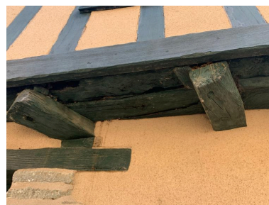
Elévation ouest, détail de l'encorbellement et des solives Phot. ANTAK, Architectes du Patrimoine IVR53_20235605916NUCA
