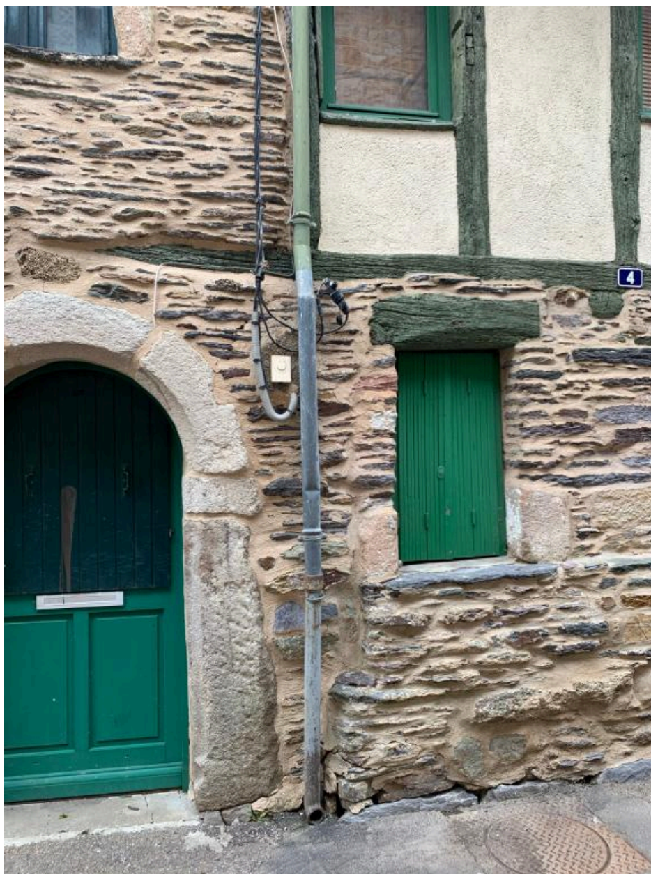
Elévation est, porte et fenêtre
