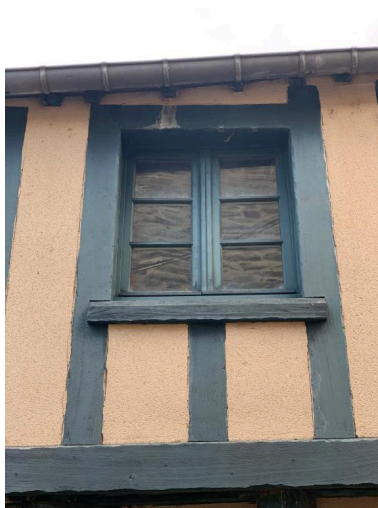
Elévation ouest, partie sud, fenêtre au rez-de-chaussée Phot. ANTAK, Architectes du Patrimoine IVR53_20235605921NUCA
