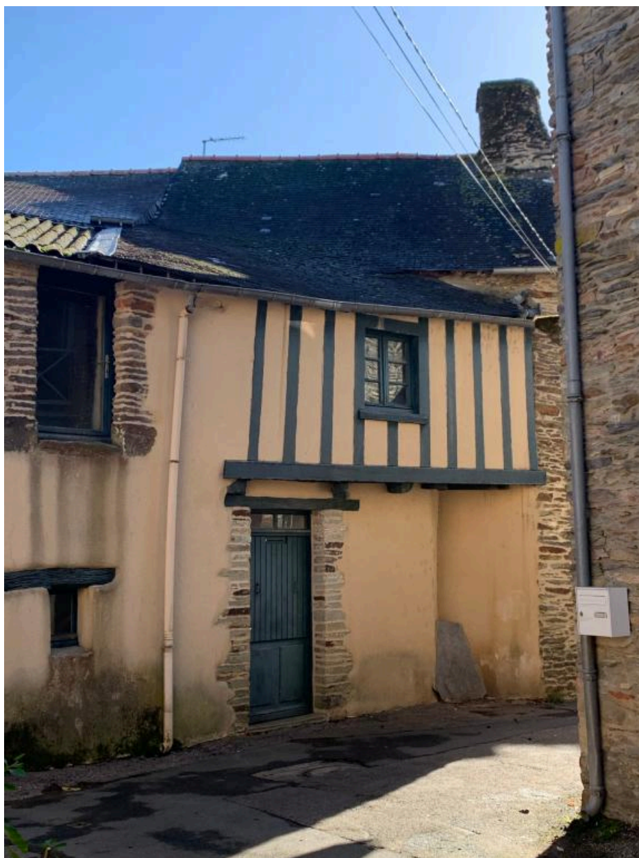
Elévation ouest, partie sud
