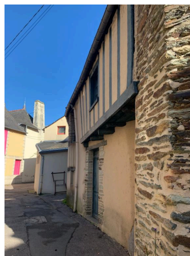
Elévation ouest, partie sud Phot. ANTAk, Architectes du Patrimoine
