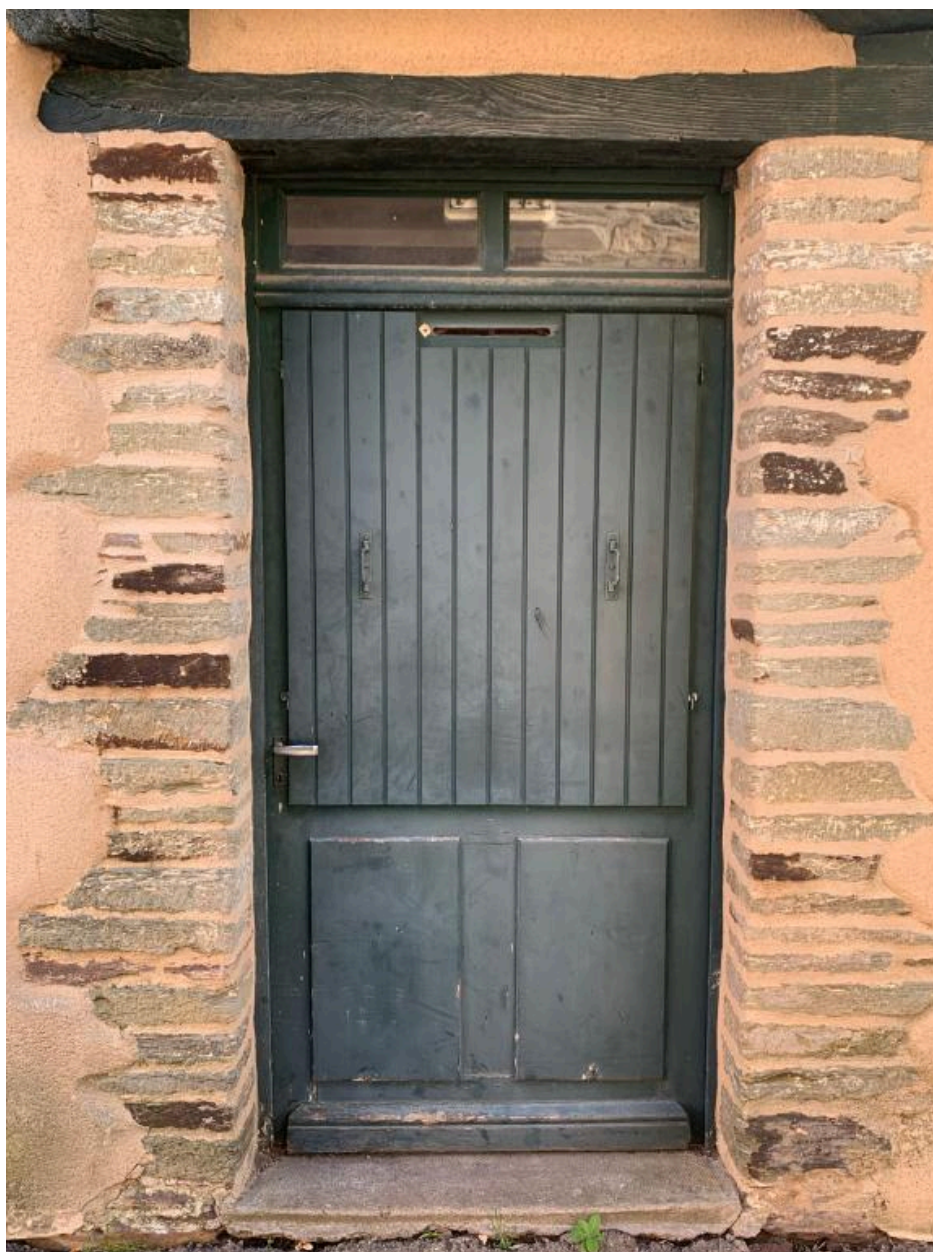
Elévation ouest, partie nord, porte au rez-de-chaussée
