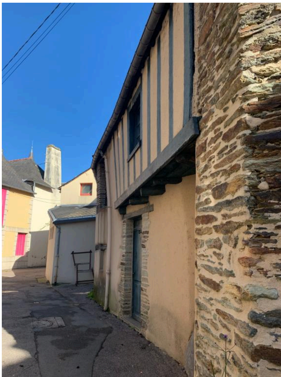
Elévation ouest, partie sud
