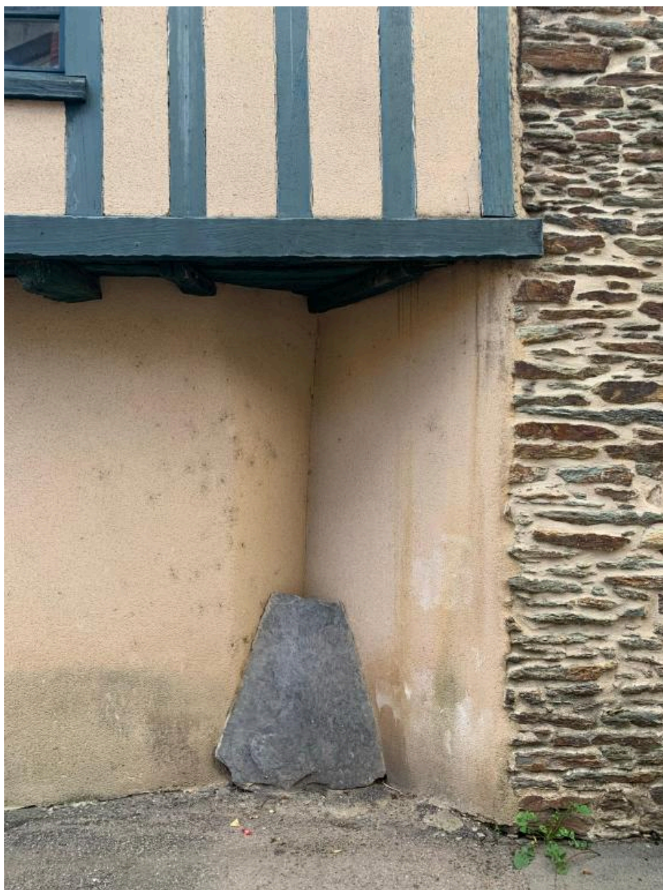
Elévation ouest, détail de l'encorbellement
