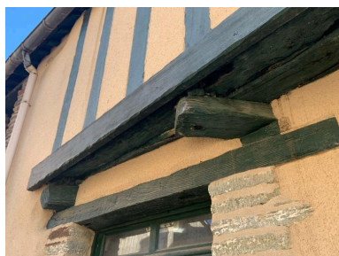
Elévation ouest, détail de l'encorbellement et des solives Phot. ANTAK, Architectes du Patrimoine IVR53_20235605915NUCA
