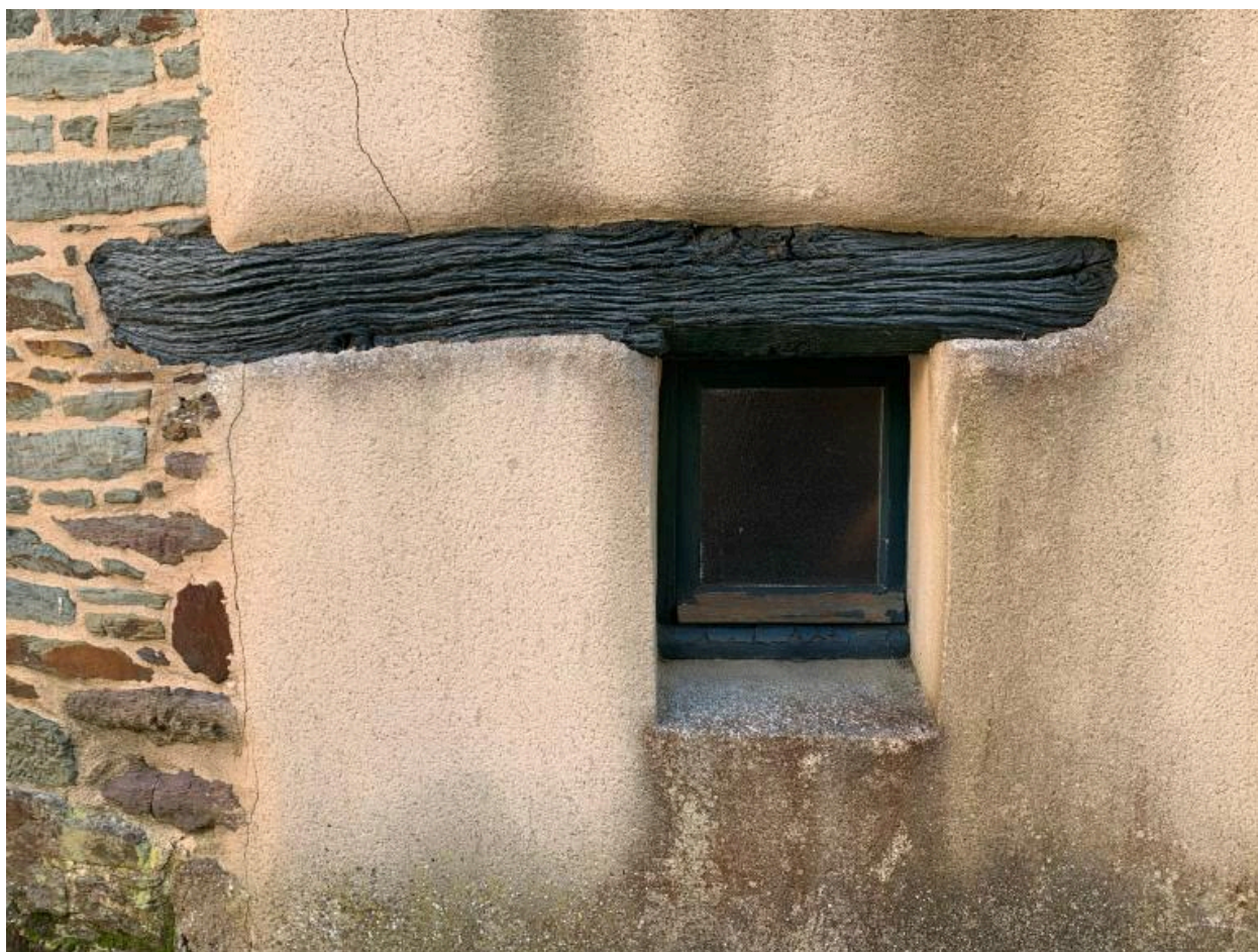
Elévation ouest, partie nord, fenêtre au rez-de-chaussée
