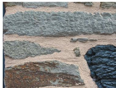
Mur-pignon sud : le matériau de schiste multicolore (état en 2012) Phot. Marie-Dominique Menant IVR53_20125608176NUCA
