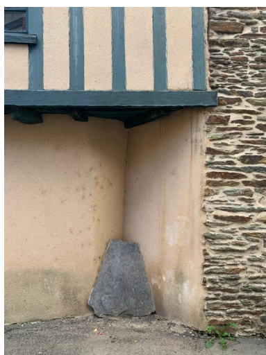
Elévation ouest, détail de l'encorbellement Phot. ANTAK, Architectes du Patrimoine IVR53_20235605920NUCA
