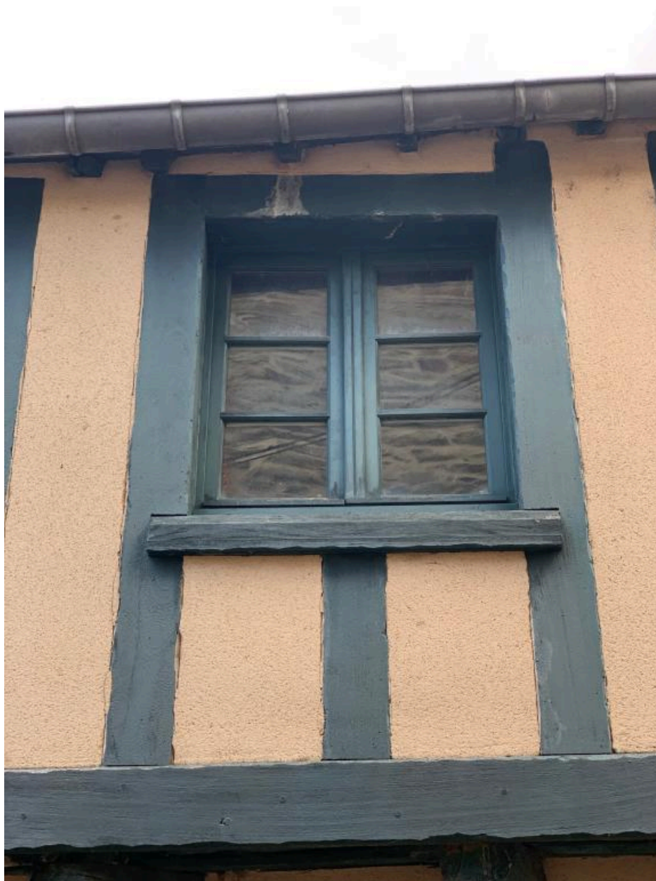
Elévation ouest, partie sud, fenêtre au rez-de-chaussée
