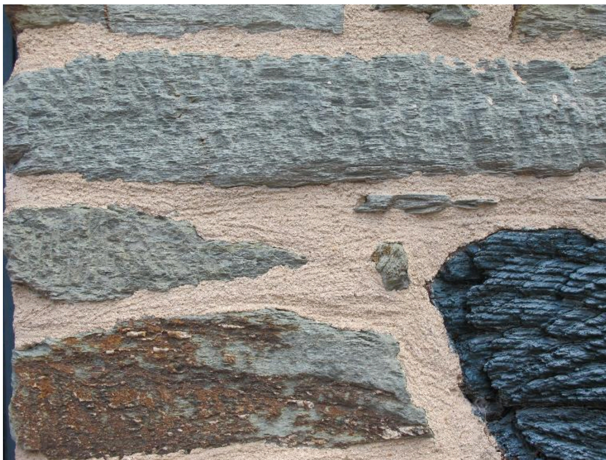
Mur-pignon sud : le matériau de schiste multicolore (état en 2012)
