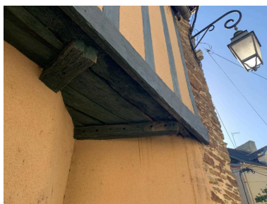
Elévation ouest, détail de l'encorbellement et des solives Phot. ANTAK, Architectes du Patrimoine IVR53_20235605917NUCA
