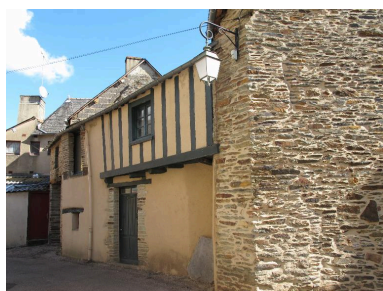
Elévation ouest sur la rue aux Anglais (état en 2012) Phot. Marie-Dominique Menant IVR53_20125608165NUCA
