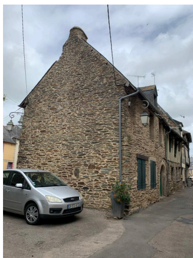
Pignon sud Phot. ANTAk, Architectes du Patrimoine IVR53_20235605907NUCA
