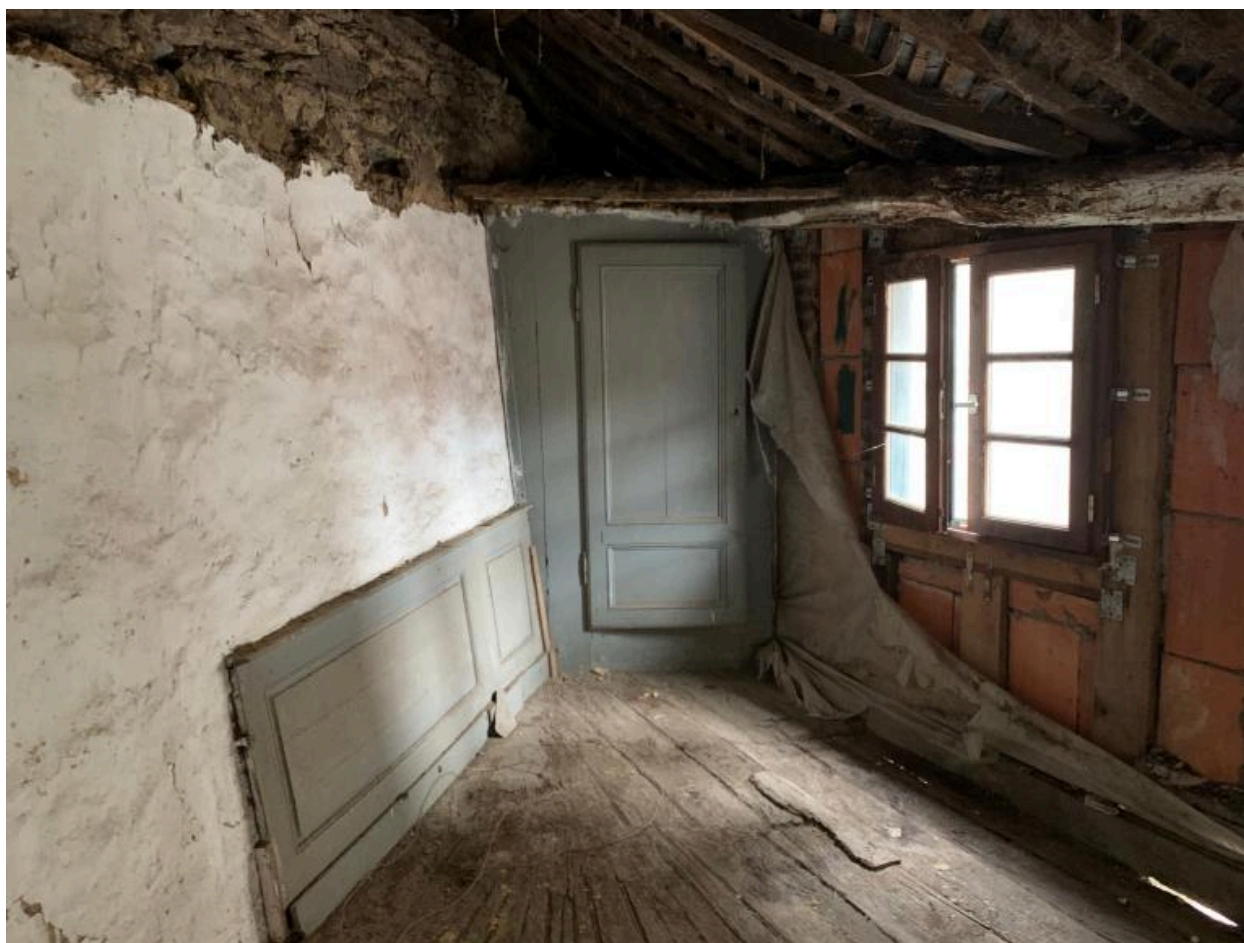
Intérieur, premier étage, pièce ouest
