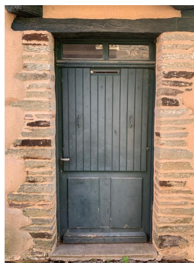
Elévation ouest, partie nord, porte au rez-de-chaussée Phot. ANTAK, Architectes du Patrimoine IVR53_20235605914NUCA
