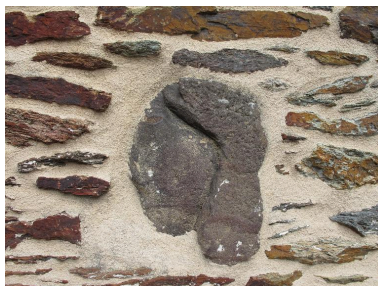
Mur-pignon sud : le matériau de schiste multicolore (état en 2012) Phot. Marie-Dominique Menant IVR53_20125608167NUCA
