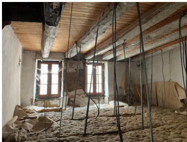
Intérieur, premier étage, pièce est Phot. ANTAK, Architectes du Patrimoine IVR53_20235605909NUCA
