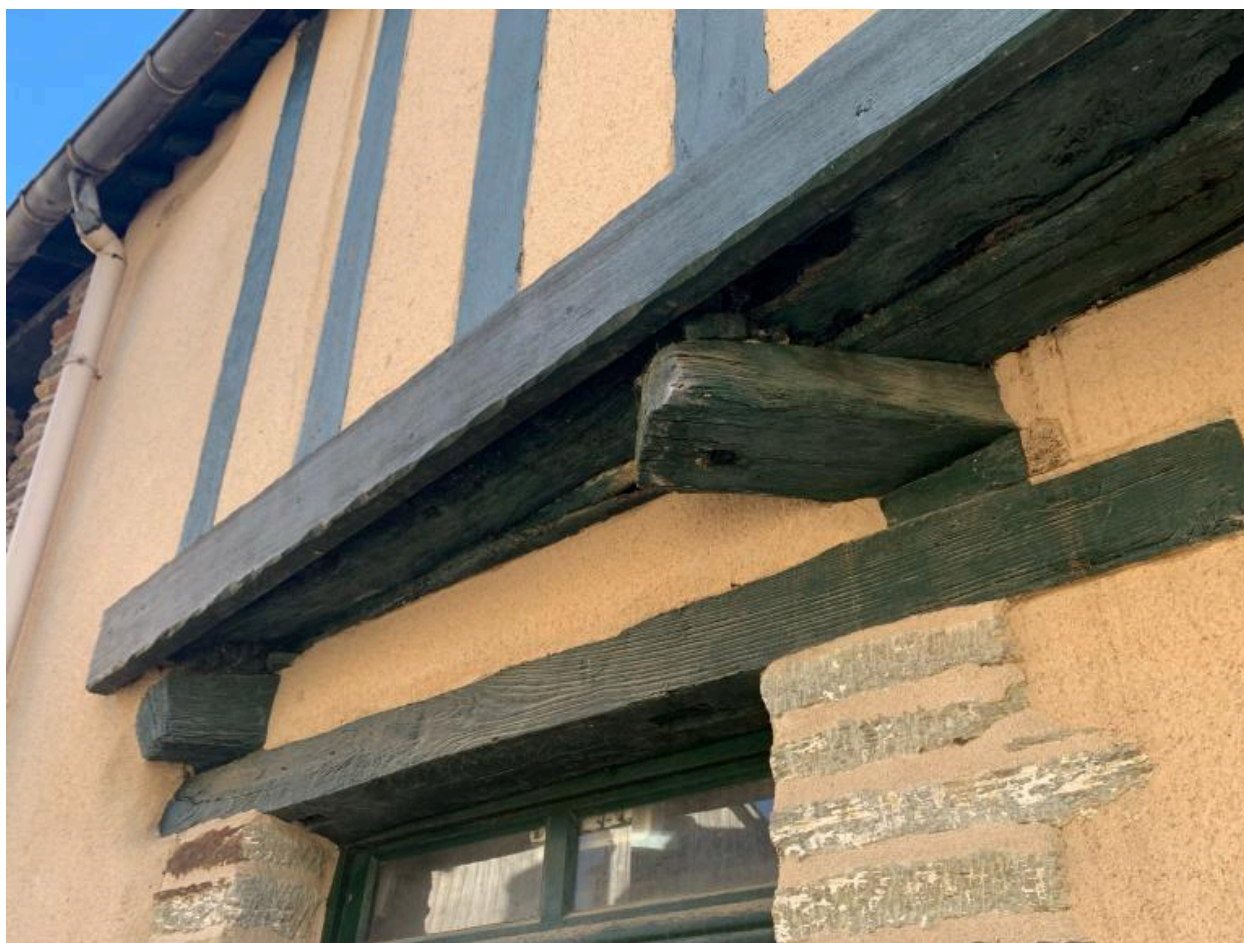
Elévation ouest, détail de l'encorbellement et des solives
