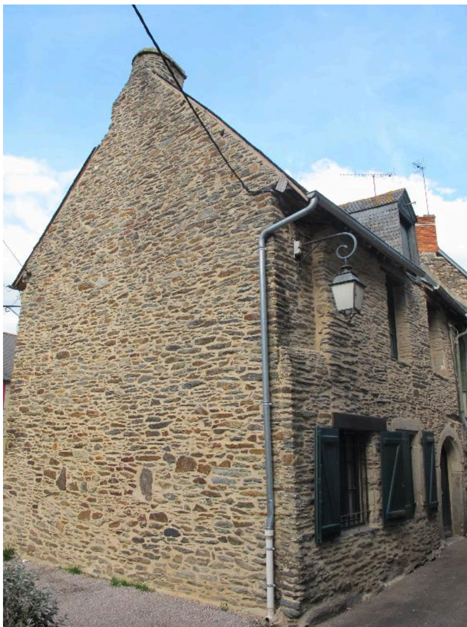
Elévation sud : le mur-pignon (état en 2012)
