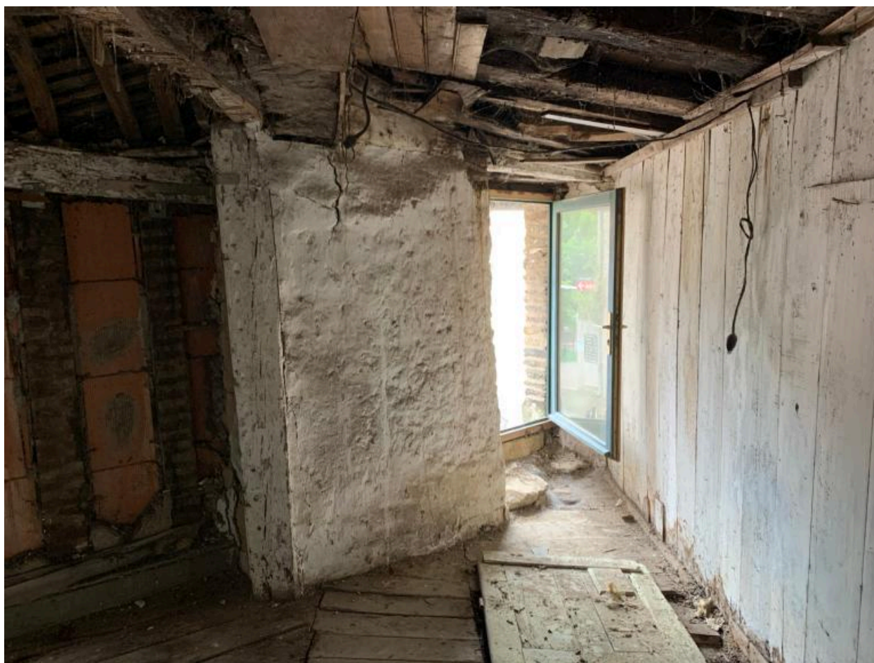
Intérieur, premier étage, pièce ouest
