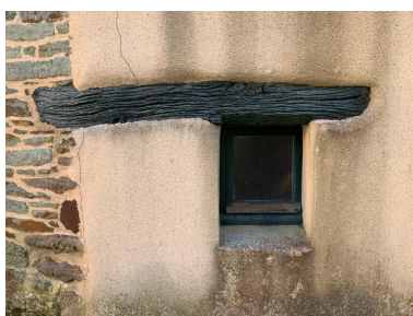
Elévation ouest, partie nord, fenêtre au rez-de-chaussée Phot. ANTAK, Architectes du Patrimoine IVR53_20235605913NUCA
