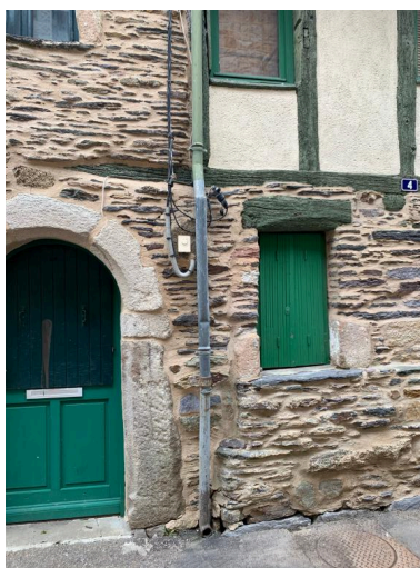
Elévation est, porte et fenêtre Phot. ANTAk, Architectes du Patrimoine IVR53_20235605905NUCA
