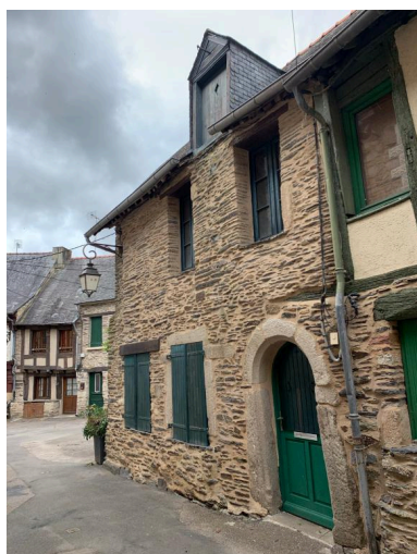
Elévation est, partie sud Phot. ANTAk, Architectes du Patrimoine IVR53_20235605900NUCA
