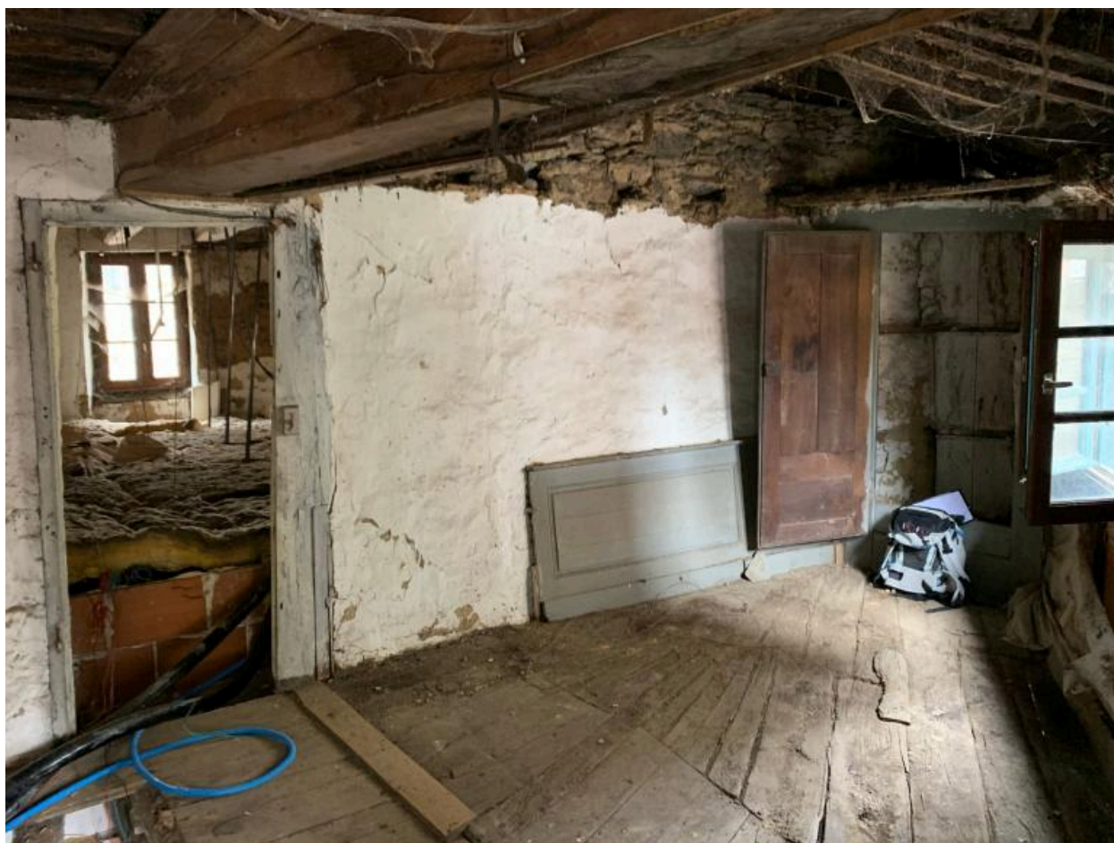
Intérieur, premier étage, pièce ouest
