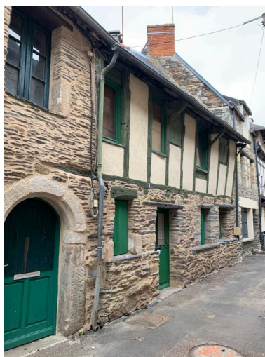
Elévation est, partie nord Phot. ANTAk, Architectes du Patrimoine IVR53_20235605903NUCA
