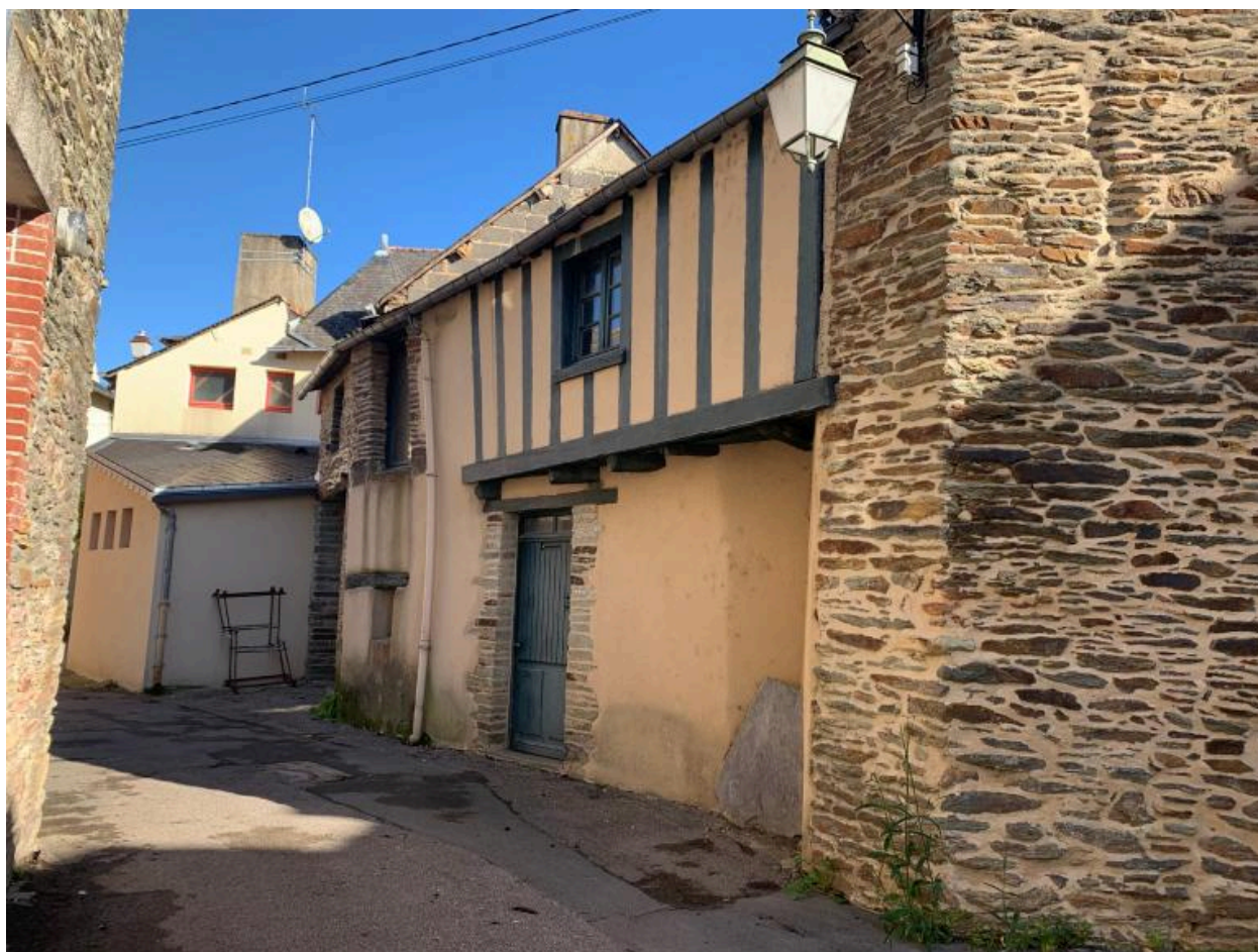
Elévation ouest, partie sud
