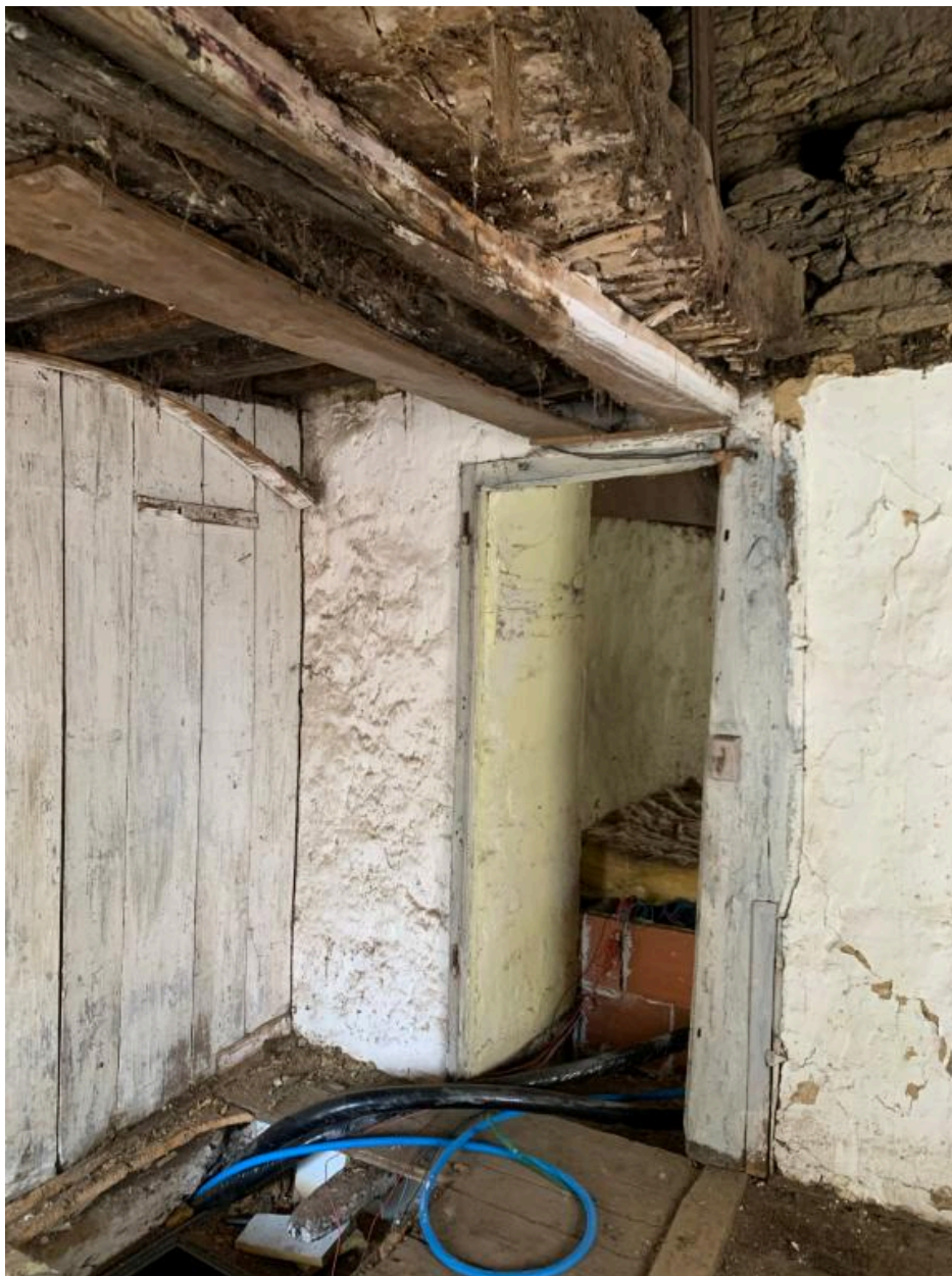
Intérieur, premier étage, pièce ouest
