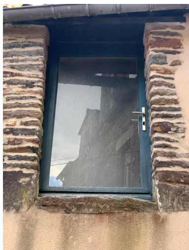
Elévation ouest, partie nord, fenêtre au premier étage Phot. ANTAK, Architectes du Patrimoine IVR53_20235605922NUCA
