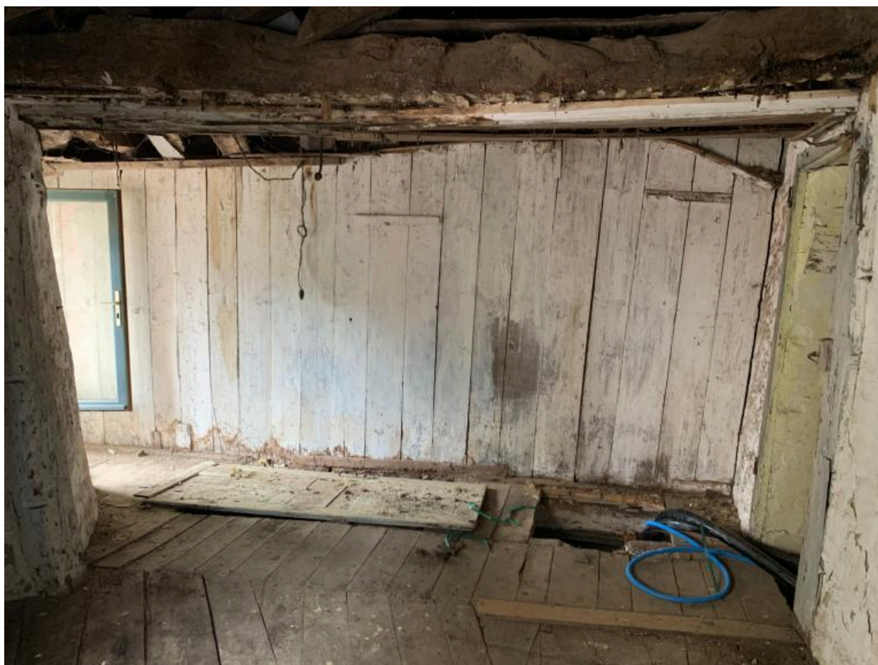
Intérieur, premier étage, pièce ouest
