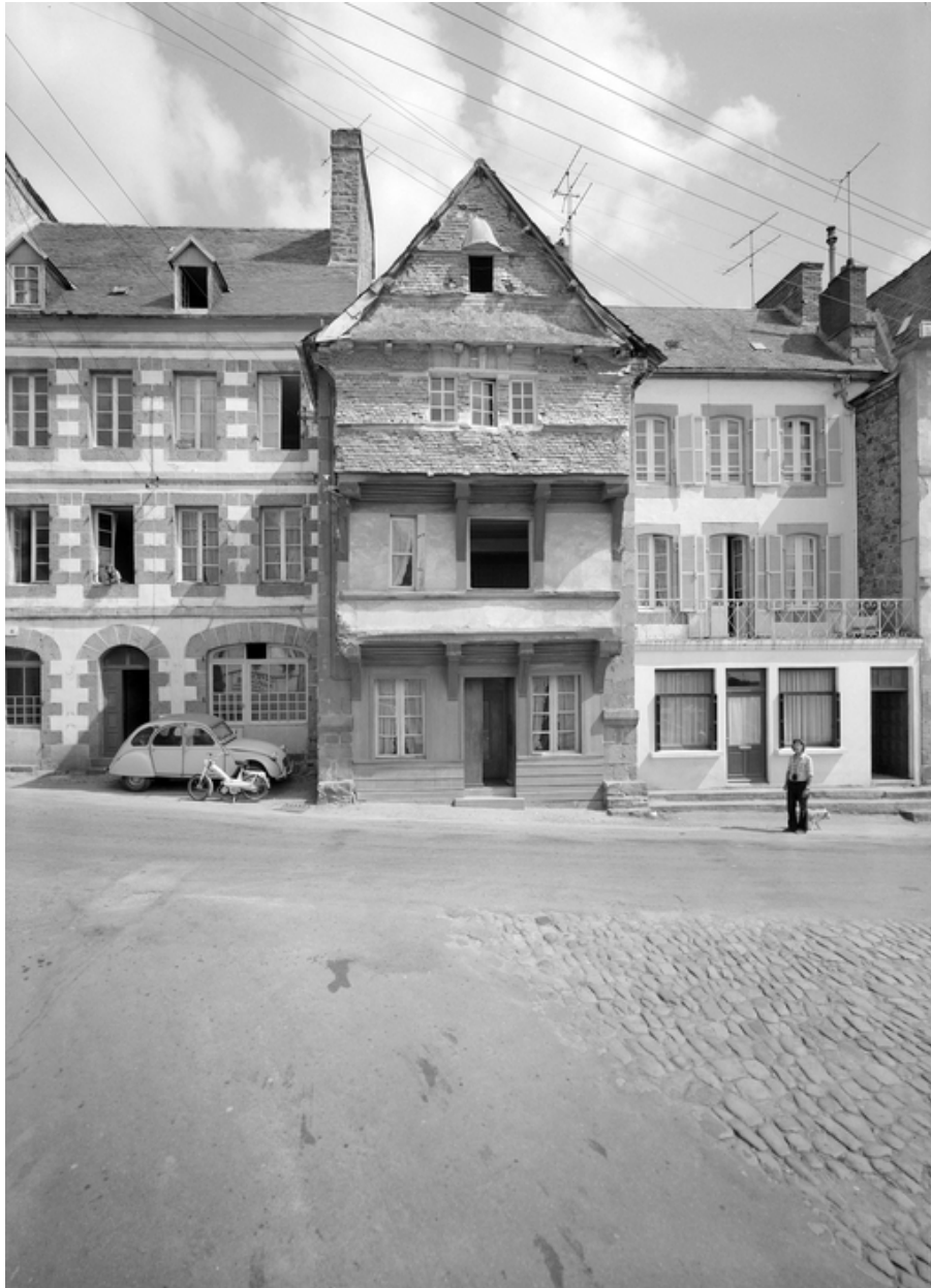
Maison dite la Tour Eiffel, 22 place Yves Le Trocquer : façade ouest
