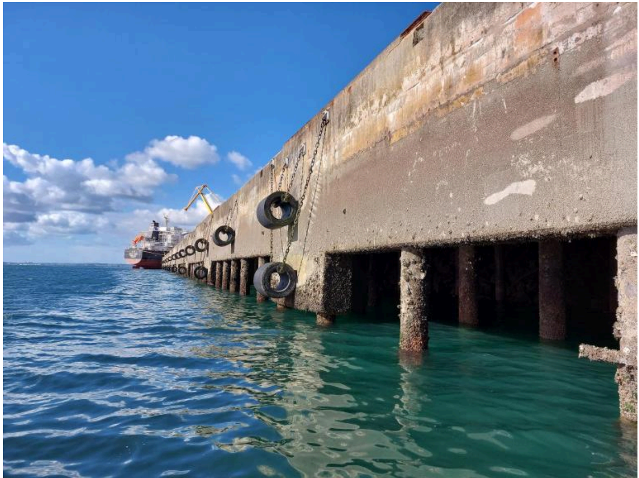
Quai sur pieux de la plate-forme multimodale
