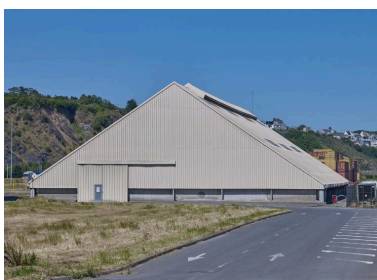
Magasin de stockage Phot. Bernard Bègne IVR53_20232900435NUCA
