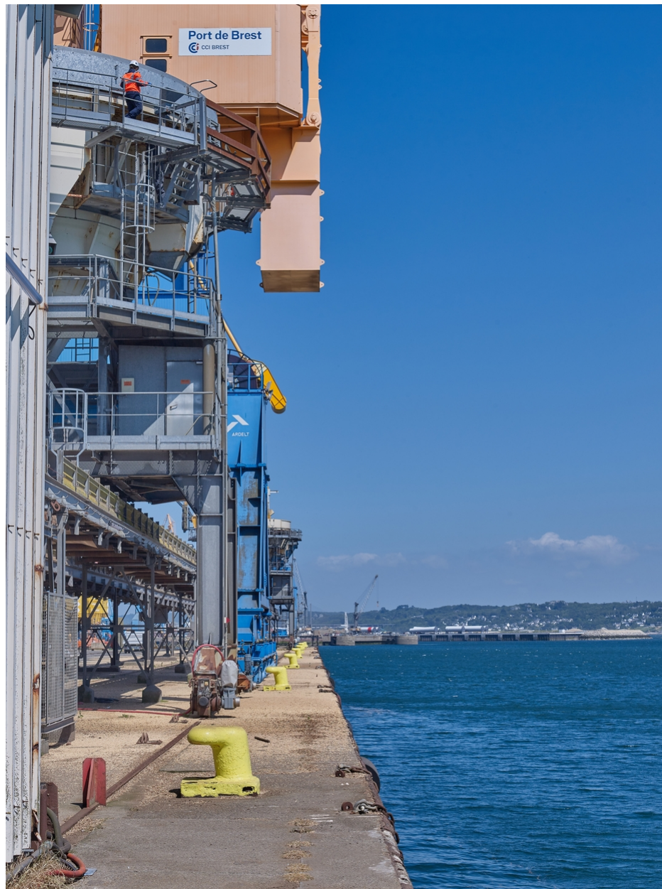
Grues et trémies sur rails
