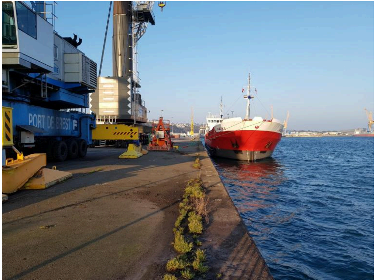
Plate-forme multimodale : grues
