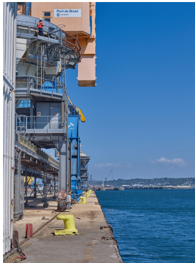
Grues et trémies sur rails Phot. Bernard Bègne IVR53_20232900441NUCA
