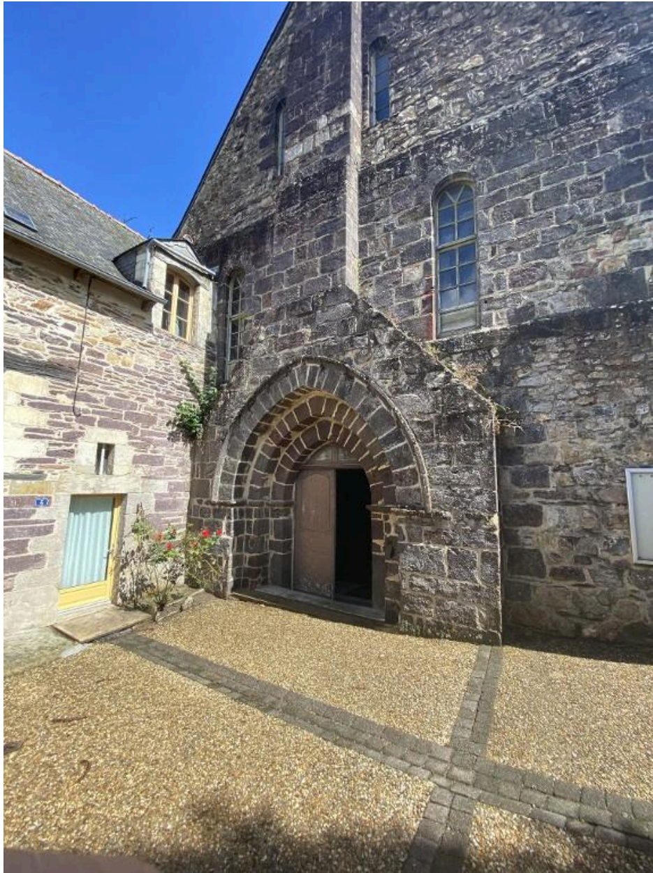
Portail occidental, vue générale
