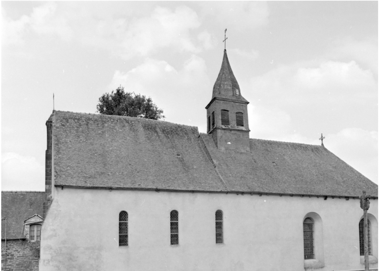
Vue générale sud
