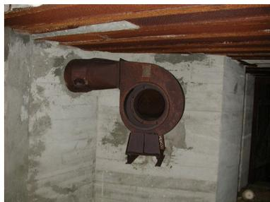
Vue du corps du ventilateur servant à l'extraction des fumées de tir du canon (état en 2002)
