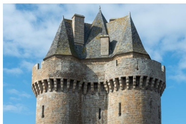
Vue de la tour Solidor depuis l'est-nord-est : deuxième étage, chemin de ronde crénelé équipé de mâchicoulis et étage de comble coiffé de hauts toits en ardoise Phot. Léna Leroy IVR53_20253500615NUCA
