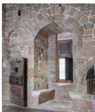
Vue intérieure de la tour Solidor : premier étage, pièce intermédiaire, arbalétrière-canonnière avec double coussiège orientée vers le sud
