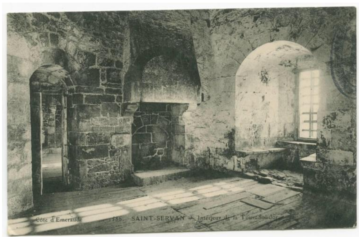
Vue intérieure de la tour Solidor : deuxième étage, tour ouest, cheminée et baie à double coussiège orientée vers le sud, carte postale (LL). A gauche, porte desservant la pièce intermédiaire
