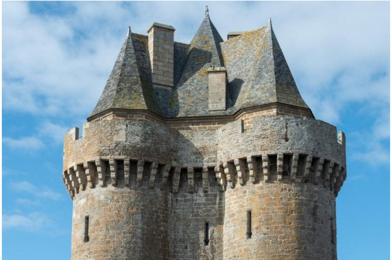
Vue de la tour Solidor depuis l'est-nord-est : deuxième étage, chemin de ronde crénelé équipé de mâchicoulis et étage de comble coiffé de hauts toits en ardoise
