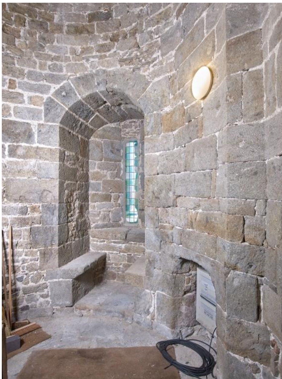
Vue intérieure de la tour Solidor : rez-de-chaussée, tour nord, arbalétrière-canonnière à double coussiège orientée vers l'est et cheminée (abritant le tableau électrique)
