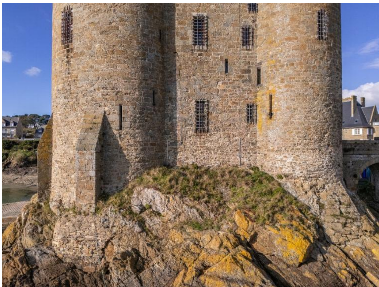
Vue aérienne oblique depuis le sud : élévation sud, détail du rez-de-chaussée et du premier étage. Un massif de maçonnerie supporte le contrefort sud de la tour ouest
