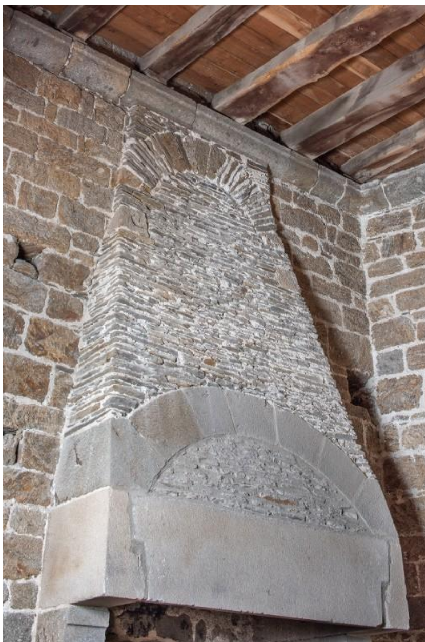
Vue intérieure de la tour Solidor : premier étage, pièce intermédiaire, hotte pyramidale de la cheminée adossée au mur de refend ouest
