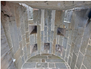
Vue intérieure de la tour Solidor : rez-de-chaussée, détail de la voûte du passage d'entrée avec ses cinq assommoirs accessibles depuis le premier étage Défendu par son propre assommoir, le poste de garde dispose d'un banc en pierre, d'une niche murale et d'une cheminée.
