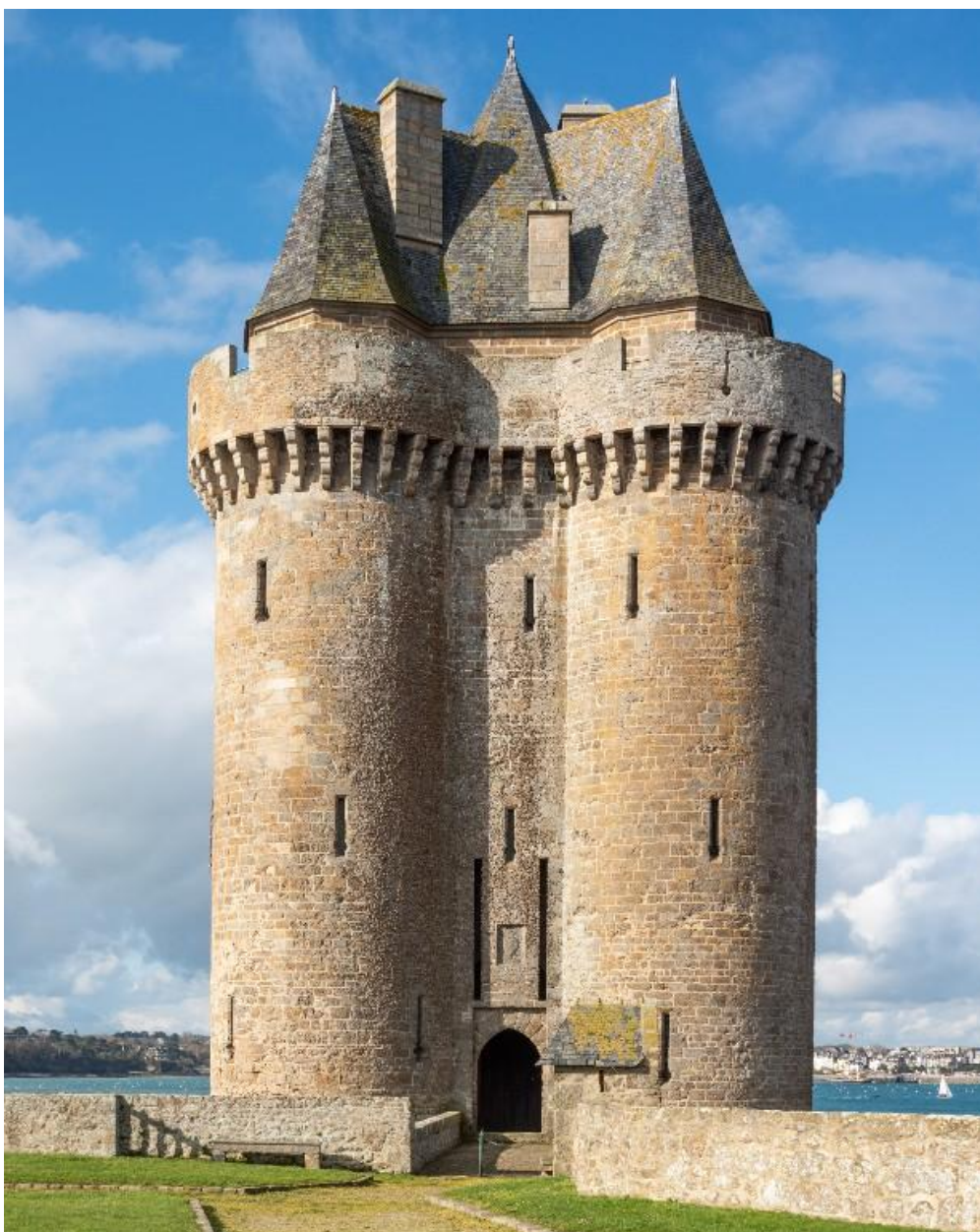
Vue de la tour Solidor depuis l'est-nord-est
