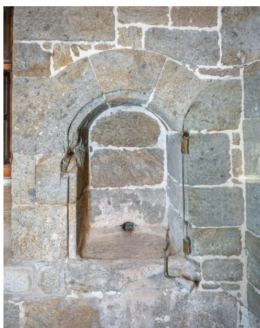
Vue intérieure de la tour Solidor : premier étage, pièce intermédiaire, placard mural (en arc plein cintre). Il est doté d'un égout Phot. Léna Leroy IVR53_20253500638NUCA
