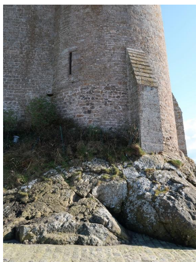
Vue du pied de la tour ouest depuis le nord : deux mises en oeuvre différentes sont visibles dans la maçonnerie. En haut, au centre, archère-canonnrière (dépourvue d'arc de décharge) du rez-de-chaussée ; à droite, contrefort nord en pierre de taille Phot. Guillaume Lécueillier IVR53_20263510546NUCA
