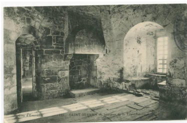
Vue intérieure de la tour Solidor : deuxième étage, tour ouest, cheminée et baie à double coussière orientée vers le sud, carte postale (LL). A gauche, porte desservant la pièce intermédiaire
