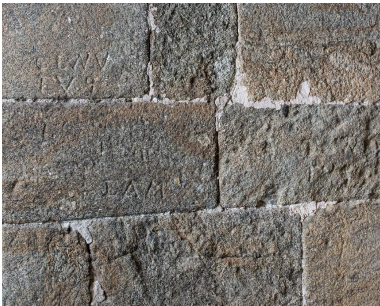
Vue intérieure de la tour Solidor : premier étage, pièce intermédiaire, détail des graffitis situés dans l'ébrasement de l'arbalétrière-canonnière orientée vers le nord
