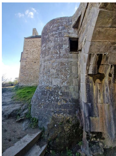
Vue de la tour sud du châtelet d'entrée de la basse-cour. La partie haute de la tour a été arasée. A droite, le pont dormant de la basse-cour Phot. Guillaume Lécueillier IVR53_20263510530NUCA
