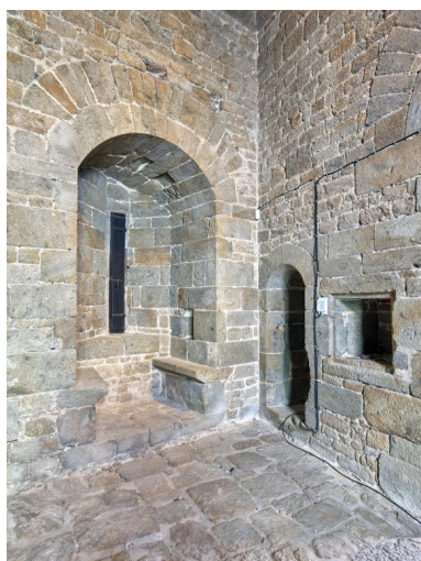
Vue intérieure de la tour Solidor : rez-de-chaussée, pièce intermédiaire, mur nord avec cheminée et arbalétrière-canonnrière à double coussiège orientée vers le nord Phot. Bernard Bègne IVR53_20253500587NUCA
