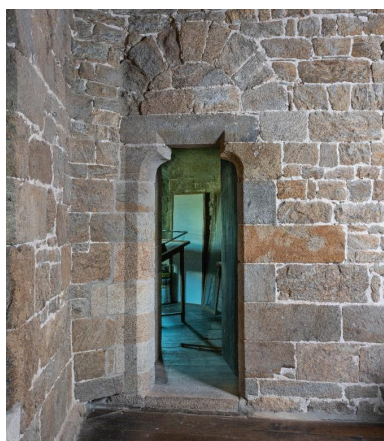
Vue intérieure de la tour Solidor : premier étage, pièce intermédiaire, détail du mur est. Cette porte (à linteau sur coussinet) dessert le corps de garde (tour nord et pièce située au-dessus du passage d'entrée)
