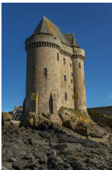
Vue générale depuis le sud-ouest. Le pied de la tour est soutenu par trois contreforts Phot. Jean-Marie Balliet IVR53_20263510491NUCA
