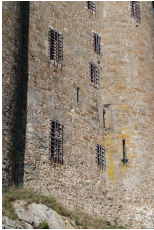
Vue de détail de l'élévation sud de la tour : deux mises en œuvre différentes sont visibles dans la maçonnerie
