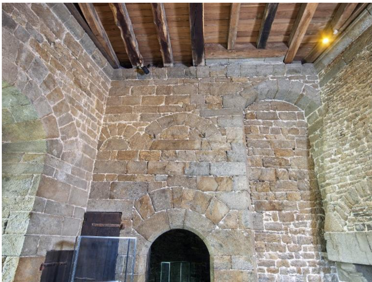
Vue intérieure de la tour Solidor : rez-de-chaussée, pièce intermédiaire, détail du mur de refend ouest. Au centre, la porte de la tour ouest ; à gauche, la porte des latrines (en niveau intermédiaire) ; à droite, la cheminée
