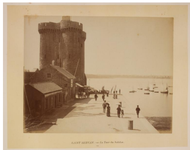
Vue de la Tour Solidor avant sa restauration, vers 1885 Phot. Auteur inconnu (phototype/ graphique), Repro. Auteur inconnu IVR53_20253510281NUCA
