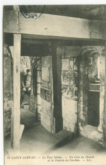
Vue intérieure de la tour Solidor : premier étage, tour nord, niveau intermédiaire à usage de dortoir, carte postale (LL). A gauche, le poteau est muni de plusieurs marches
