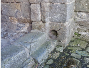
Vue de la tour Solidor : emplacement de l'essieu du tablier du pont-levis. La feuillure permet d'accueillir le tablier
