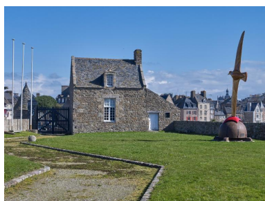
Vue du corps de garde implanté à l'entrée de la basse-cour et flanquant la porte : élévation sud-ouest. A droite, la sculpture-girouette baptisée l'Albatros Phot. Bernard Bègne IVR53_20253500584NUCA
