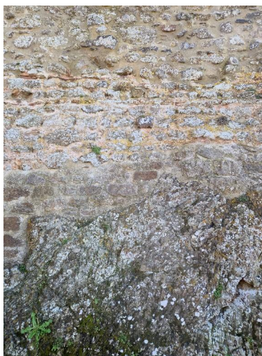
Vue de détail de l'élévation nord de la basse-cour : maçonnerie mêlant moellon et chaînage en brique correspondant au niveau d'occupation gallo-romain Phot. Guillaume Lécueillier IVR53_20263510535NUCA
