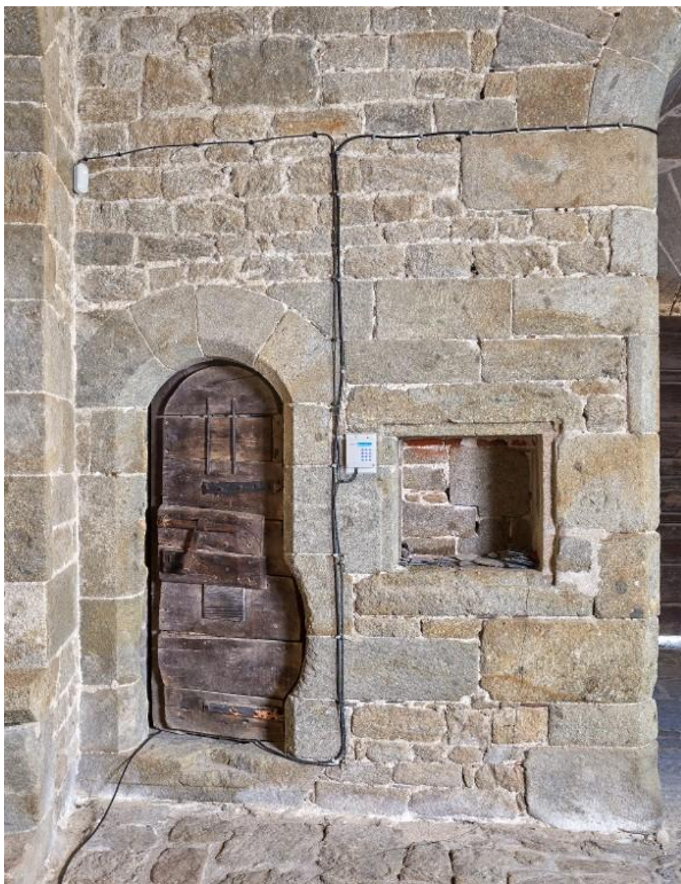
Vue intérieure de la tour Solidor : rez-de-chaussée, pièce intermédiaire, détail du mur est. Cette porte dessert la tour nord ; à droite, placard mural. Le passage de la porte a été élargi pour permettre le passage de tonneaux
