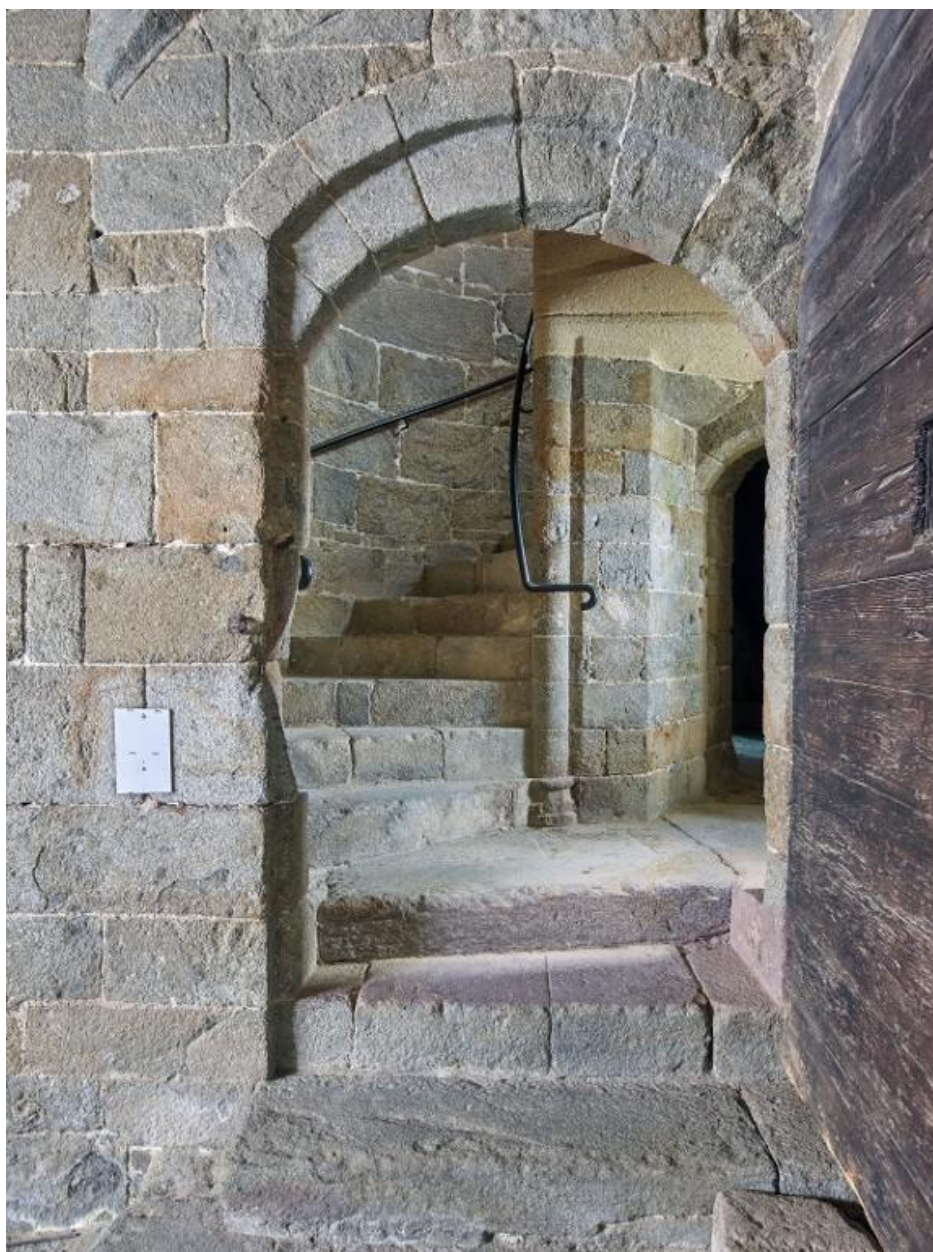
Vue intérieure de la tour Solidor : rez-de-chaussée, pièce intermédiaire, angle est. Cette porte dessert la tour est qui abrite l'escalier en vis
