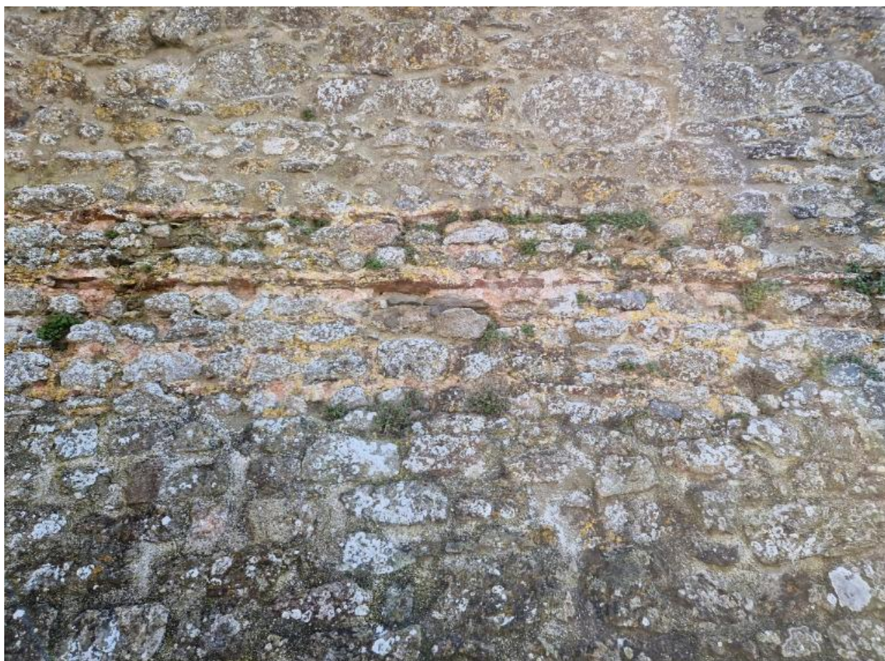
Vue de détail de l'élévation nord de la basse-cour : maçonnerie mêlant moellon et chaînage en brique correspondant au niveau d'occupation gallo-romain
