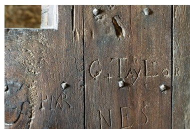
Vue intérieure de la tour Solidor : détail des graffitis de la porte du premier étage. On peut lire : G+TayLor ; PMR ; NES Phot. Léna Leroy IVR53_20253500642NUCA
