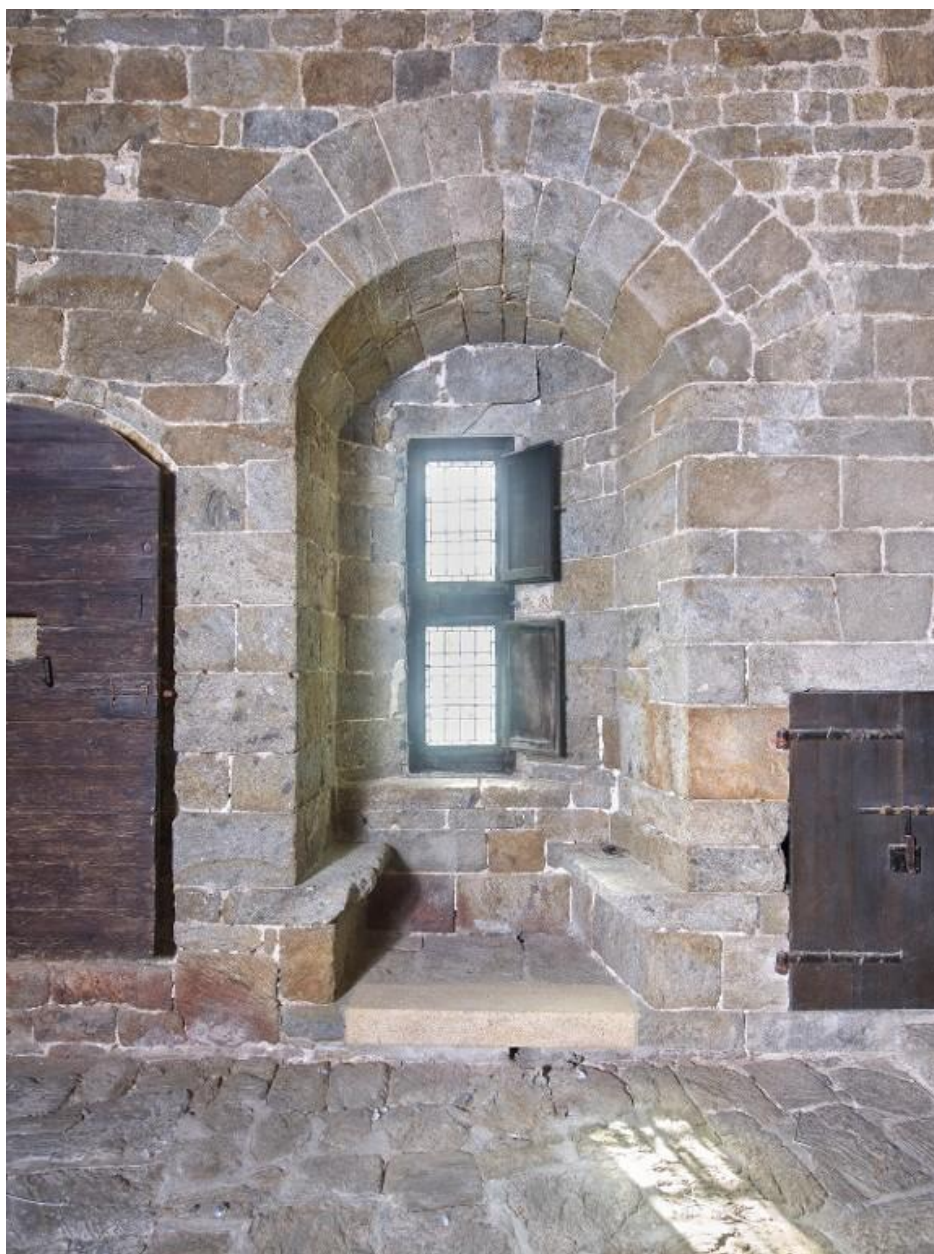
Vue intérieure de la tour Solidor : rez-de-chaussée, pièce intermédiaire, détail du mur sud, baie à double coussiège orientée vers le sud ; à droite, la porte d'un placard mural (ancienne poterne)
