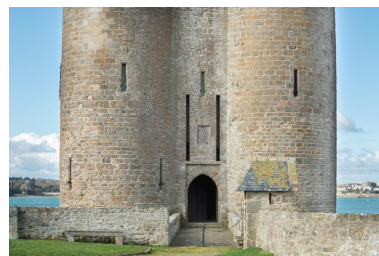
Vue de la tour Solidor depuis l'est-nord-est : rez-de-chaussée et premier étage percés d'arbalétrières-canonnières. Au centre, la porte d'entrée précédée d'un pont. A droite, guérite Phot. Léna Leroy IVR53_20253500616NUCA
