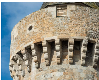
Vue de la tour Solidor depuis l'est-nord-est : détail du chemin de ronde crénelé équipé de mâchicoulis (sur console à quatre ressauts). Pierres plus récentes et remontage sont visibles Phot. Léna Leroy IVR53_20253500619NUCA
