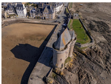
ue aérienne oblique depuis l'ouest : tour et basse-cour Phot. Jean-Marie Balliet IVR53_20263510492NUCA
