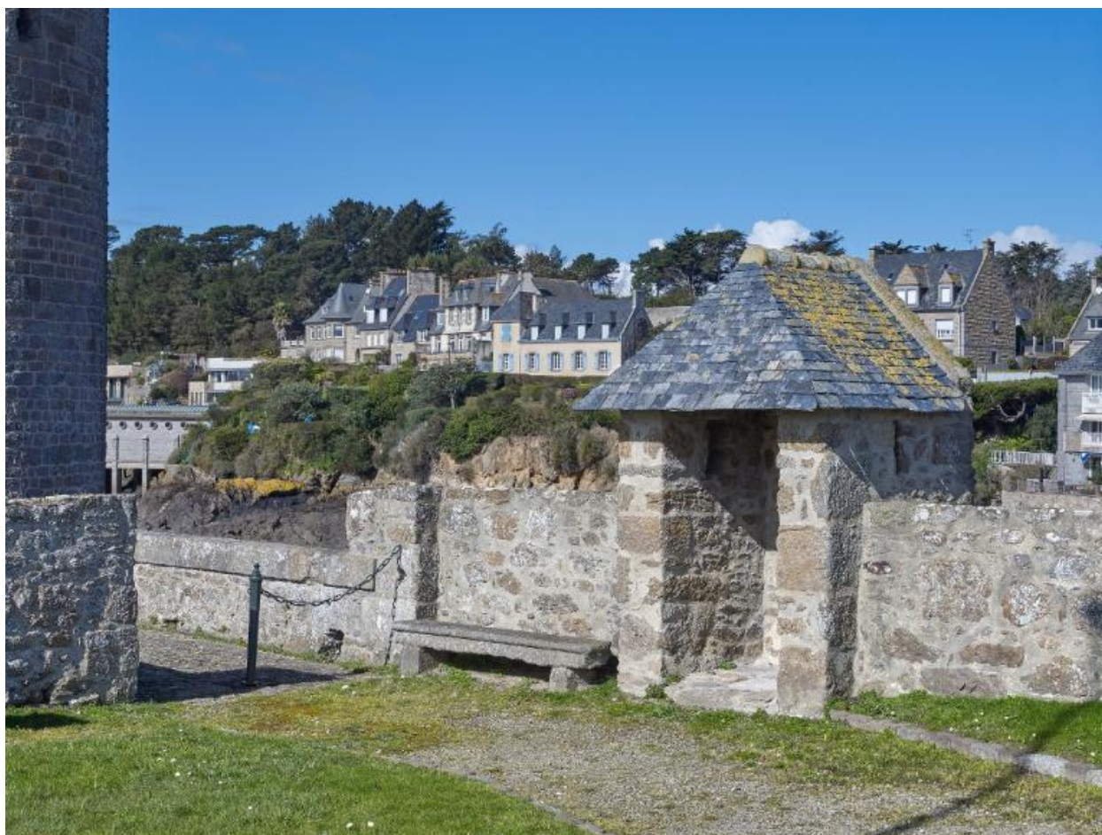
Vue de la guérite située en avant du pont d'accès à la tour
