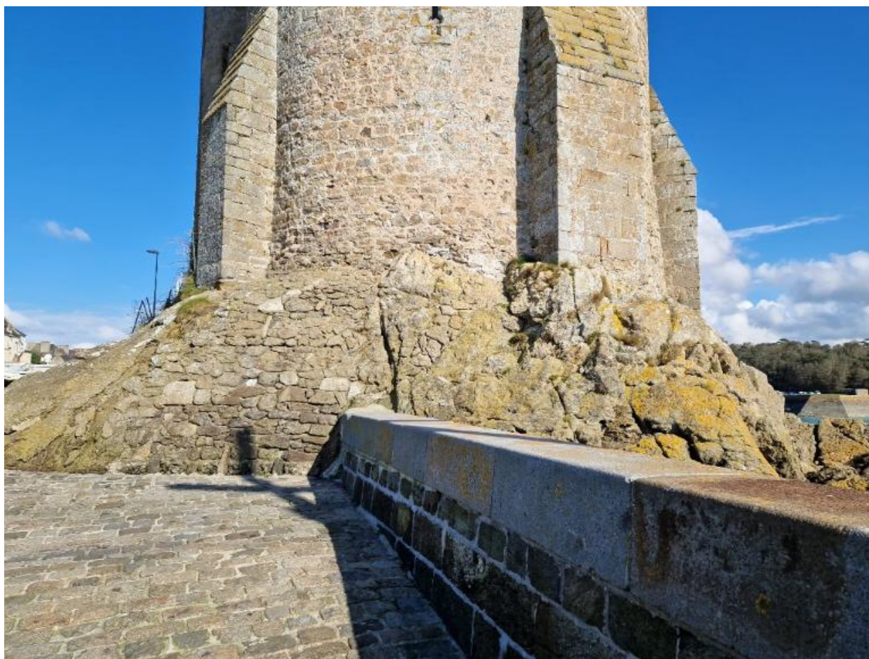
Vue du pied de la tour ouest, à la jonction avec le parapet de la cale. Un massif de maçonnerie soutient le contrefort nord (à gauche)
