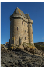
Vue générale depuis le sud-ouest. Le pied de la tour est soutenu par trois contreforts
