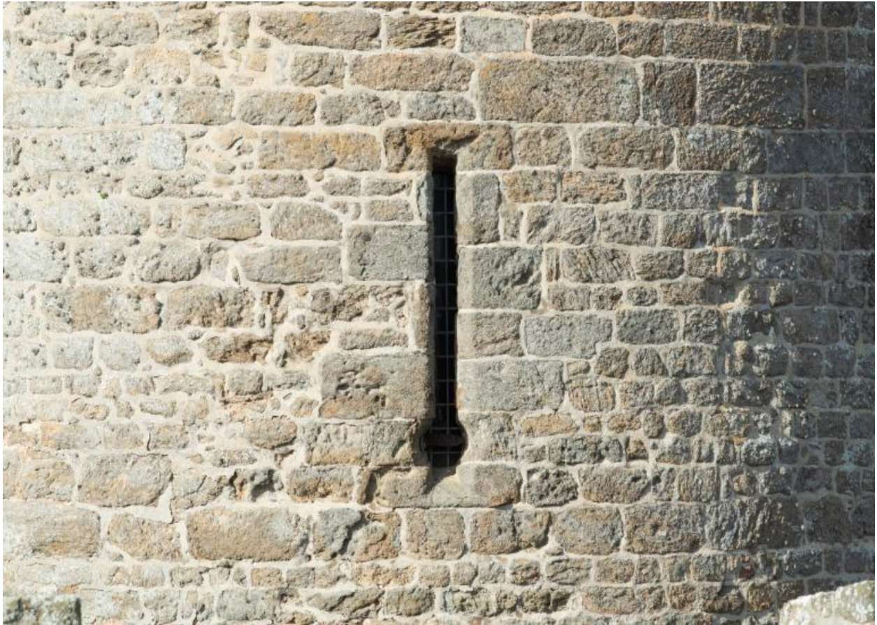
Vue de la tour Solidor : arbalétrière-canonnière (dépourvue d'arc de décharge) du rez-de-chaussée de la tour nord. Elle est orientée vers l'est
