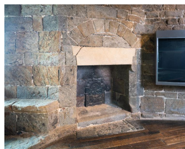
Vue intérieure de la tour Solidor : premier étage, tour ouest, cheminée à piédroit chanfreiné. A gauche, baie à double coussiège orientée vers le sud-ouest
