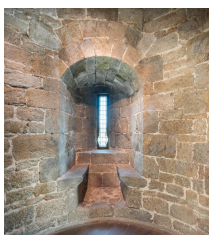
Vue intérieure de la tour Solidor : premier étage, tour est, arbalétrière-canonnière à double coussiège orientée vers l'est
