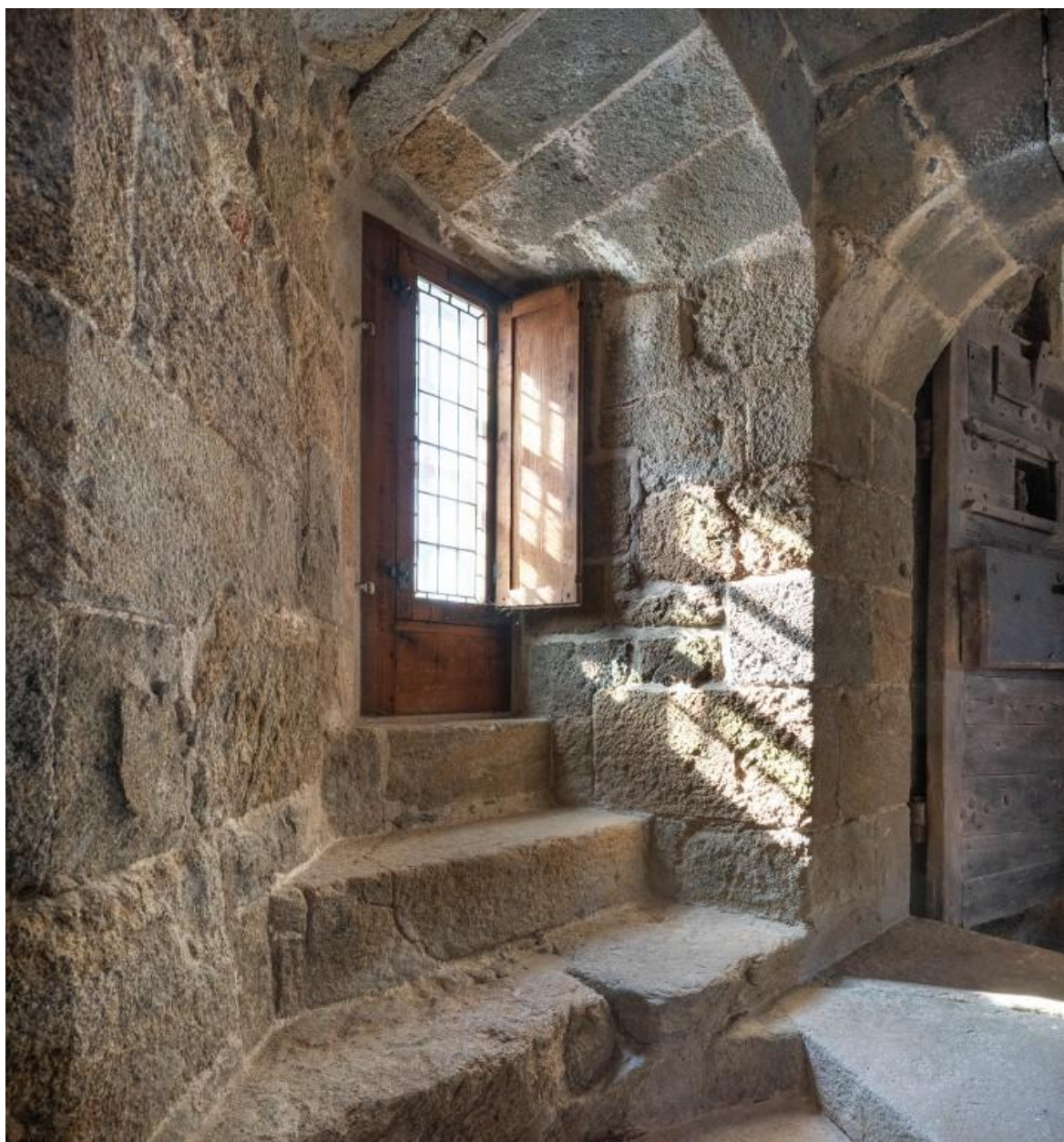
Vue intérieure de la tour Solidor : baie éclairant l'accès du premier étage depuis l'escalier en vis
