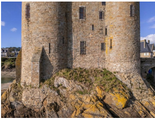
Vue aérienne oblique depuis le sud : élévation sud, détail du rez-de-chaussée et du premier étage. Un massif de maçonnerie supporte le contrefort sud de la tour ouest
