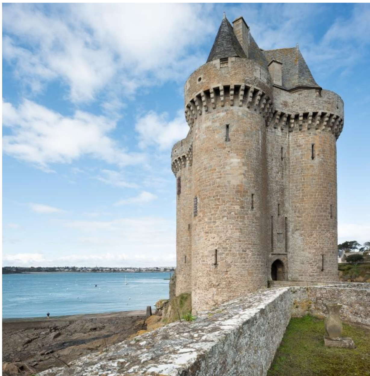
Vue de la tour Solidor depuis l'est-sud-est. Au premier plan à gauche, le parapet de la basse-cour
