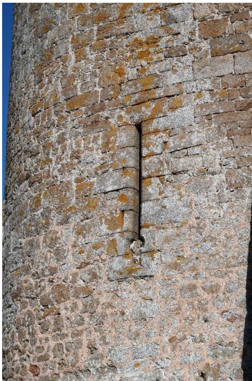
Vue de l'arbalétrière-canonnière ouest (dépourvue d'arc de décharge) du rez-de-chaussée de la tour ouest
