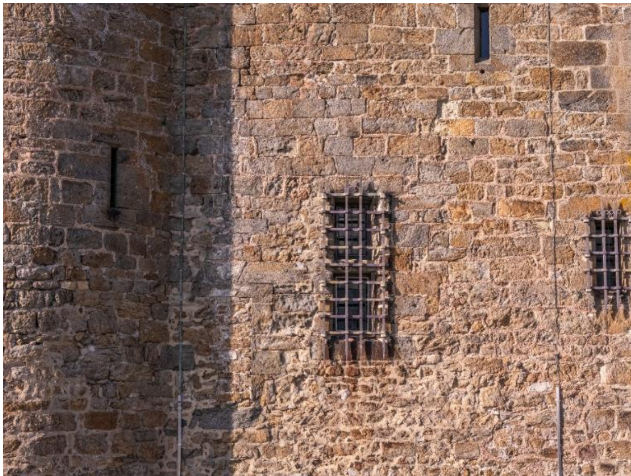
Vue aérienne oblique depuis le sud : détail de l'élévation sud de la tour. On distingue une poterne murée à gauche de la baie
