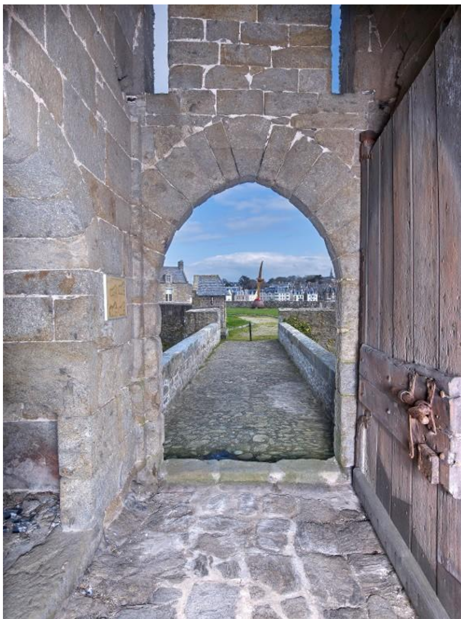
Vue intérieure de la tour Solidor : rez-de-chaussée, passage d'entrée avec porte en tiers-point débouchant vers l'est. Au-dessus de la porte se trouvent les rainures des flèches du pont-levis
