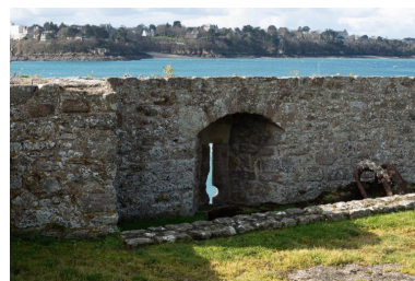
Vue de la basse-cour : arbalétrière-canonnière percée dans le parapet. Elle est orientée vers le sud-ouest Phot. Léna Leroy IVR53_20253500617NUCA
