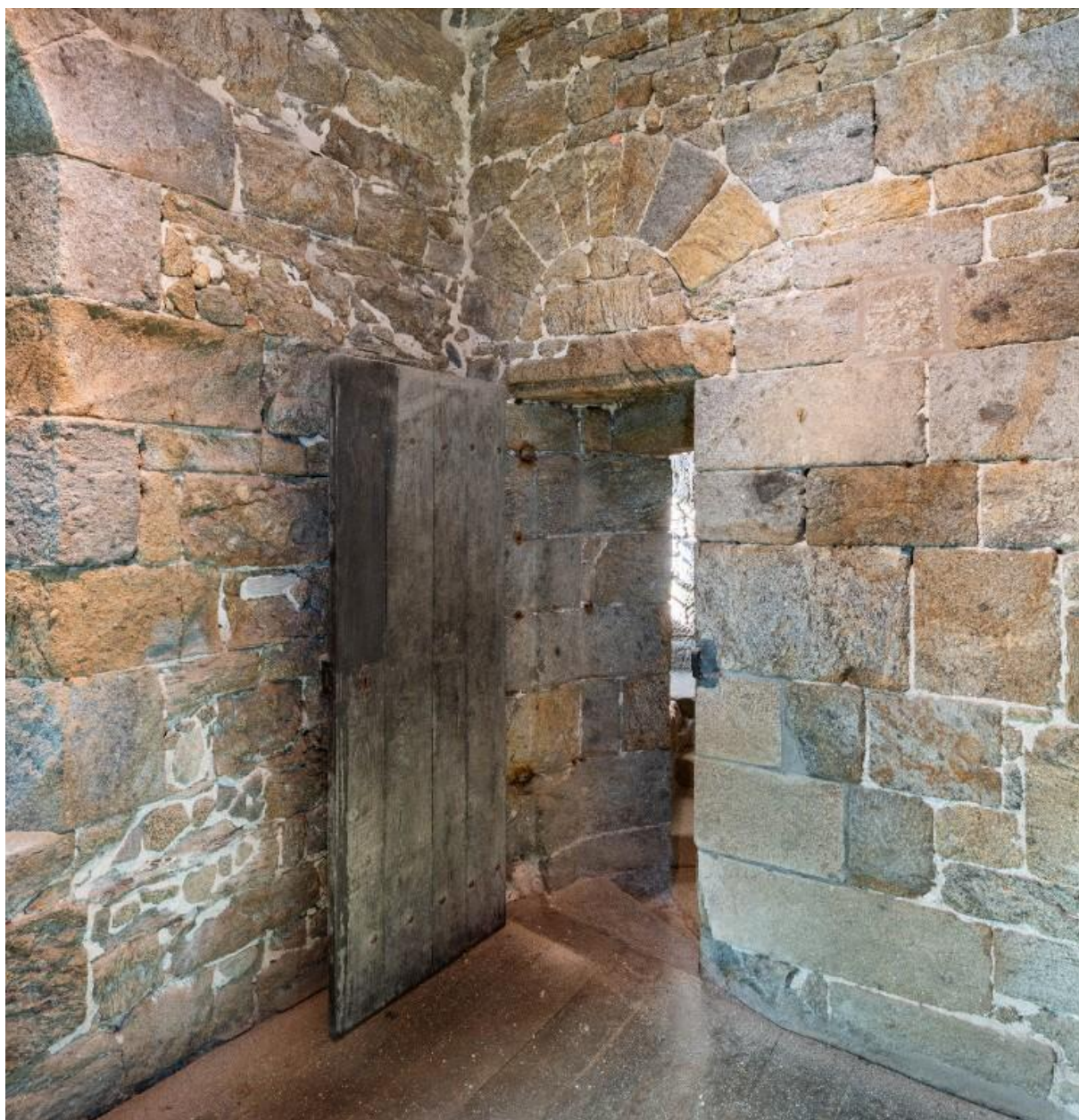
Vue intérieure de la tour Solidor : premier étage, tour est, porte à linteau droit du côté de l'intérieur (surmontée d'un arc de décharge)
