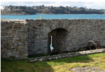
Vue de la basse-cour : arbalétrière-canonnière percée dans le parapet. Elle est orientée vers le sud-ouest
