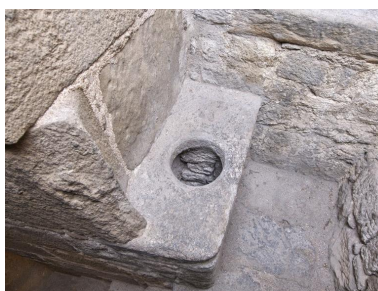
Vue intérieure de la tour Solidor : niveau intermédiaire accessible par quelques marches depuis le rez-de-chaussée, latrines. Elles sont éclairées vers le sud
