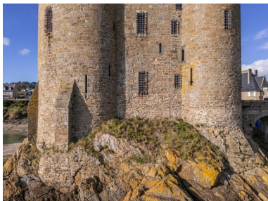
Vue aérienne oblique depuis le sud : élévation sud, détail du rez-de-chaussée et du premier étage. Un massif de maçonnerie supporte le contrefort sud de la tour ouest Phot. Jean-Marie Balliet IVR53_20253510344NUCA
