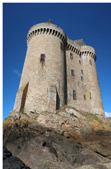
Vue générale de la tour en contreplongée depuis le sud-sud-ouest. Les consoles de mâchicoulis porte le parapet Phot. Guillaume Lécueillier IVR53_20263510547NUCA
