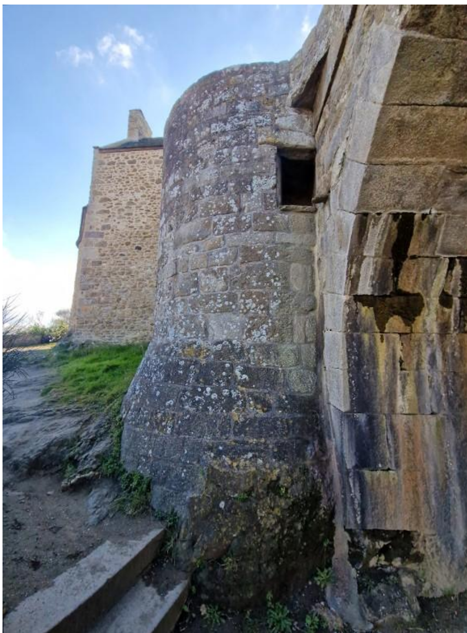
Vue de la tour sud du châtelet d'entrée de la basse-cour. La partie haute de la tour a été arasée. A droite, le pont dormant de la basse-cour
