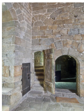
Vue intérieure de la tour Solidor : rez-de-chaussée, pièce intermédiaire, détail du mur de refend ouest. Au centre, la porte des latrines (en niveau intermédiaire) ; à gauche, placard mural (ancienne poterne) ; à droite, la porte de la tour ouest
