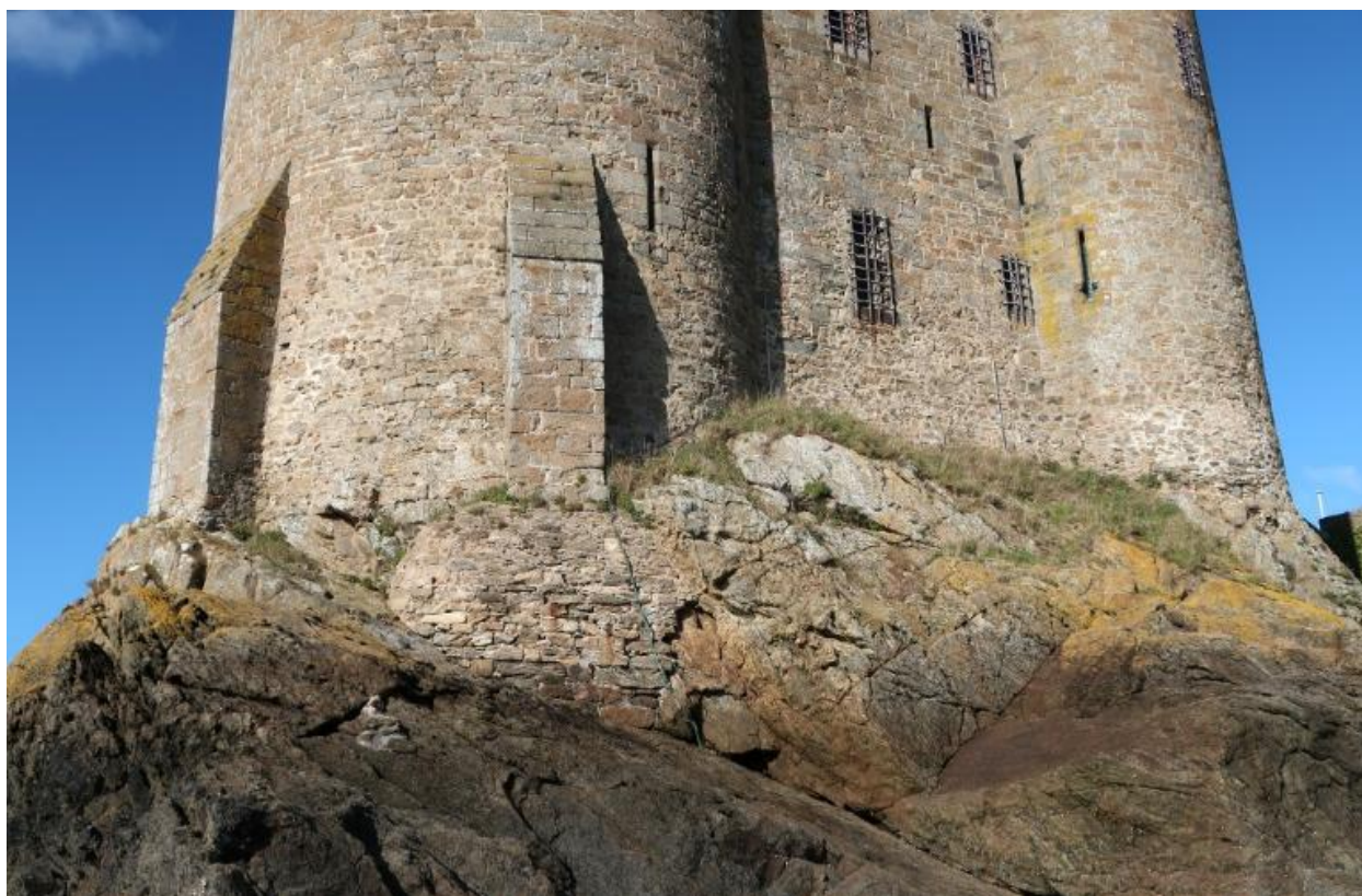
Vue du pied de l'élévation sud. Un massif de maçonnerie supporte le contrefort sud en pierre de taille de la tour ouest
