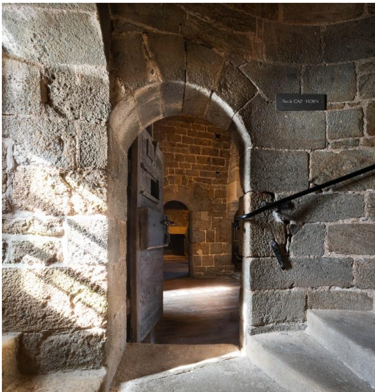
Vue intérieure de la tour Solidor : porte d'accès du premier étage depuis l'escalier en vis. Le dispositif de fermeture de la porte et le judas témoignent de l'utilisation carcérale de la tour
