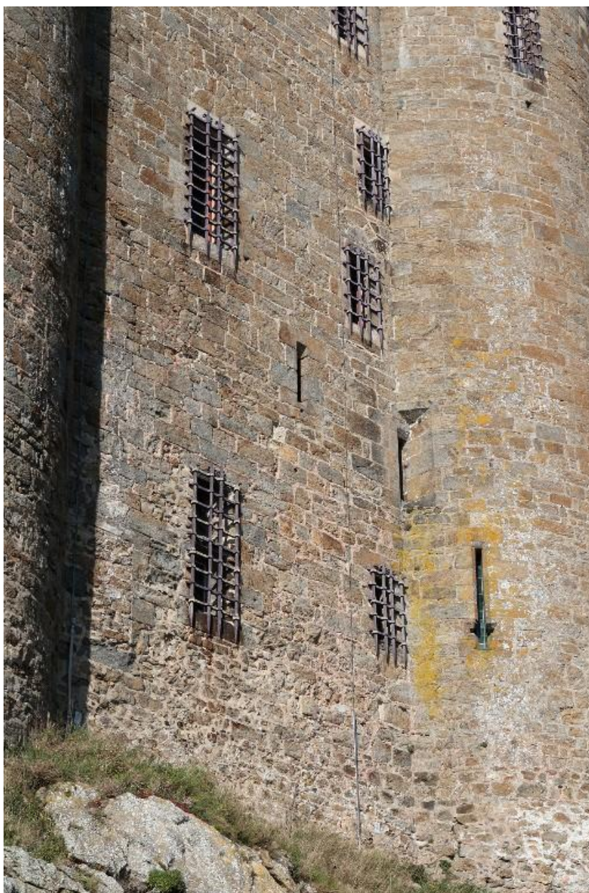
Vue de détail de l'élévation sud de la tour : deux mises en #uvre différentes sont visibles dans la maçonnerie
