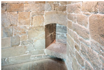
Vue intérieure de la tour Solidor : premier étage, tour est, cheminée (dépourvue de décor, son manteau est en arc segmentaire)
