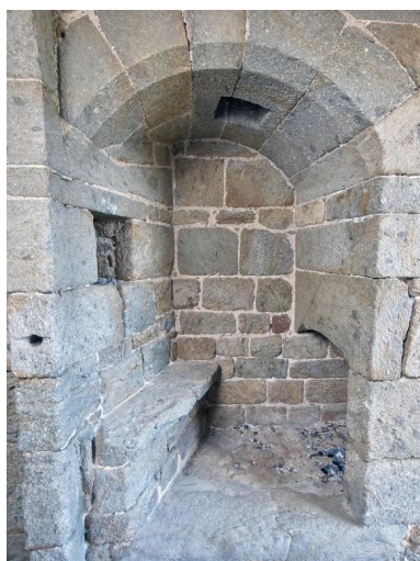
Vue intérieure de la tour Solidor : rez-de-chaussée, poste de garde implanté dans le passage d'entrée au nord. Il comprend un banc en pierre, une cheminée et une niche mural. Dans la voûte se trouve un assommoir accessible depuis le premier étage Phot. Bernard Bègne IVR53_20253500605NUCA
