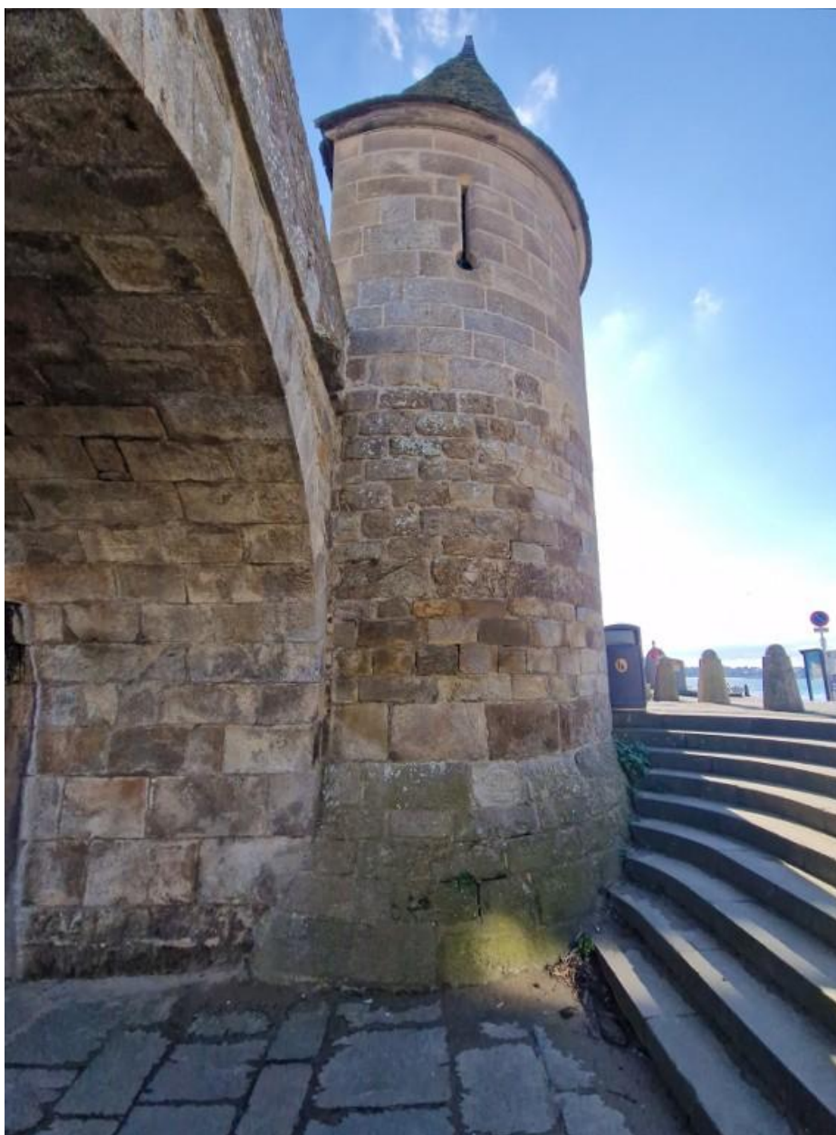
Vue de la tour nord du châtelet d'entrée de la basse-cour. La partie haute de la tour a fortement été restaurée. A gauche, le pont dormant de la basse-cour
