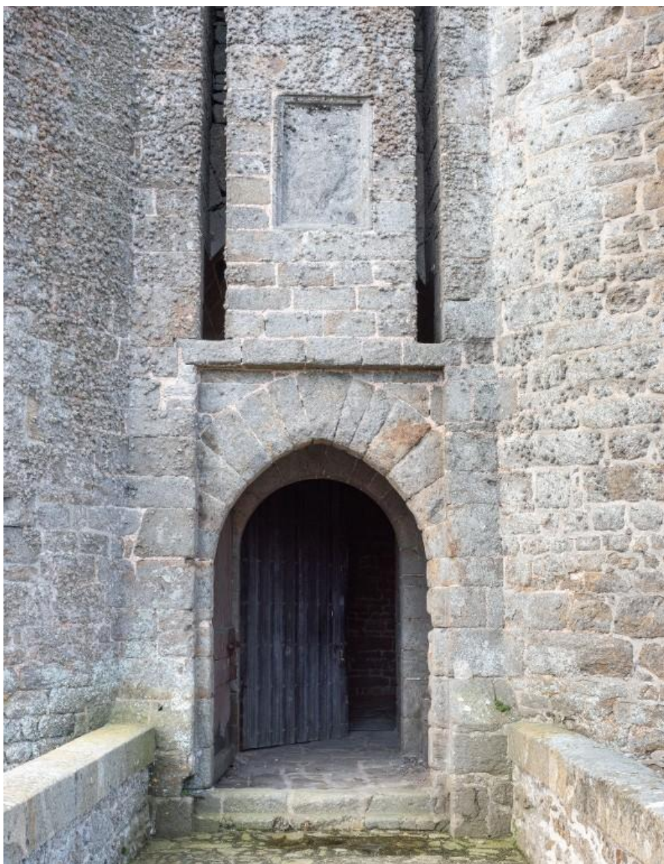
Vue de la tour Solidor : porte en tiers-point percée dans l'élévation est entre les deux tours. Au-dessus de la porte se trouvent les rainures des flèches du pont-levis ; au centre l'emplacement des armoiries
