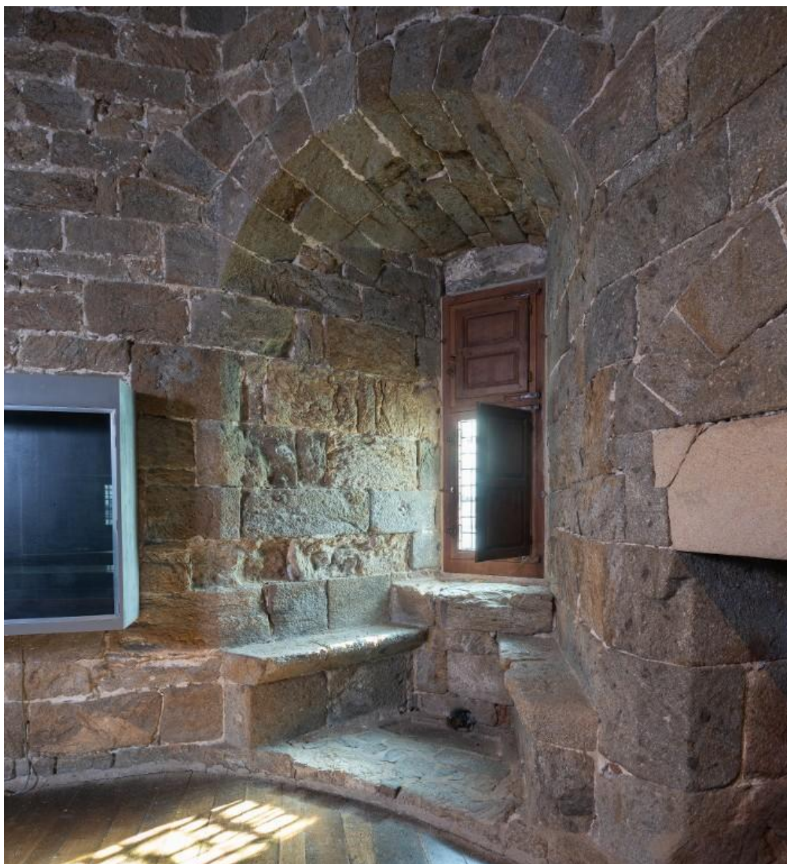
Vue intérieure de la tour Solidor : premier étage, tour ouest, baie à double coussiège orientée vers le sud-ouest. Elle est dotée d'un égout
