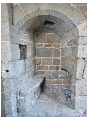
Vue intérieure de la tour Solidor : rez-de-chaussée, poste de garde implanté dans le passage d'entrée au nord. Il comprend un banc en pierre, une cheminée et une niche murale. Dans la voûte se trouve un assommoir accessible depuis le premier étage
