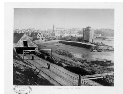
Vue de Saint-Servan du côté de Solidor, 3e quart du 19e siècle. Avant sa restauraion par l'architecte Albert Ballu, la tour Solidor présentait une couverture plus ramassée, mais authentique
