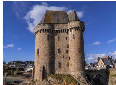
Vue aérienne oblique depuis le sud : tour et pont dormant Phot. Jean-Marie Balliet IVR53_20263510495NUCA
