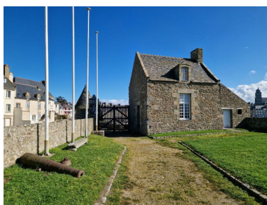
Vue du corps de garde implanté à l'entrée de la basse-cour et flanquant la porte. Au premier plan à gauche, un tube de canon de marine et une bombe pour mortier (les deux ne vont pas ensemble) Phot. Guillaume Lécueillier IVR53_20263510525NUCA
