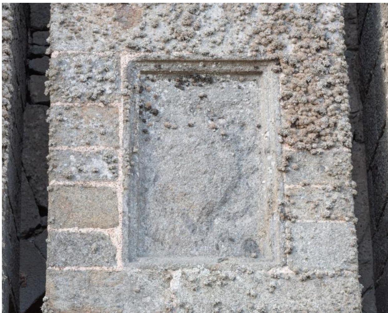
Vue de la tour Solidor : détail des armoiries implantées au-dessus de la porte. De part et d'autre se trouvent les rainures des flèches du pont-levis
