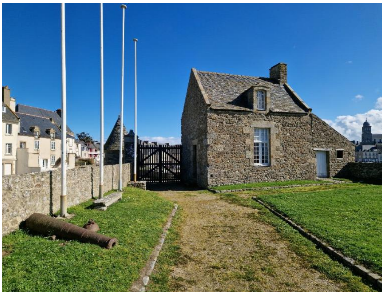
Vue du corps de garde implanté à l'entrée de la basse-cour et flanquant la porte. Au premier plan à gauche, un tube de canon de marine et une bombe pour mortier (les deux ne vont pas ensemble)
