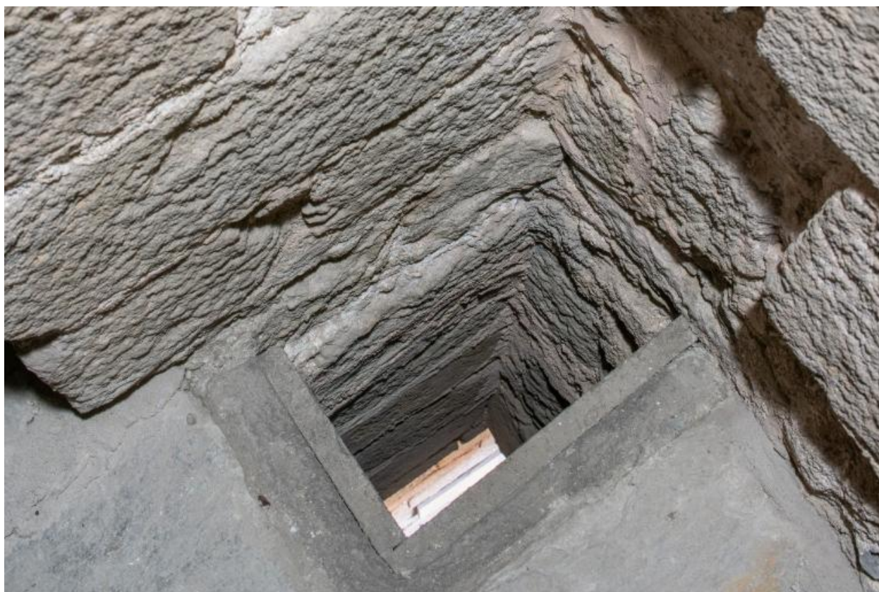
Vue intérieure de la tour Solidor : premier étage, corps de garde (petite tour nord et pièce située au-dessus du passage d'entrée), assommoir aménagé au-dessus du poste de garde
