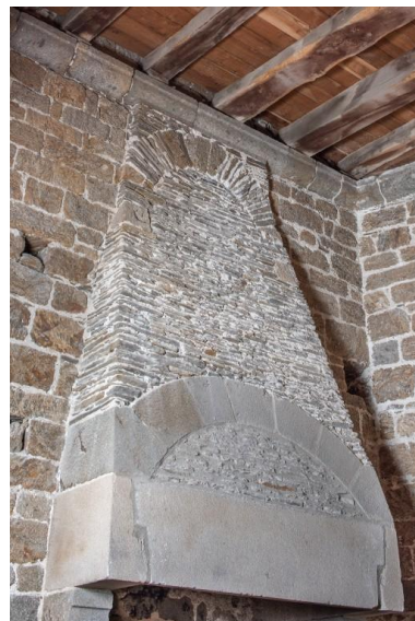
Vue intérieure de la tour Solidor : premier étage, pièce intermédiaire, hotte pyramidale de la cheminée adossée au mur de refend ouest Phot. Léna Leroy IVR53_20253500634NUCA
