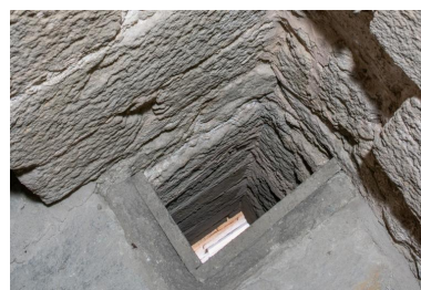
Vue intérieure de la tour Solidor : premier étage, corps de garde (petite tour nord et pièce située au-dessus du passage d'entrée), assommoir aménagé au-dessus du poste de garde
