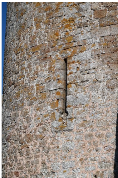
Vue de l'arbalétrière-canonnrière ouest (dépourvue d'arc de décharge) du rez-de-chaussée de la tour ouest Phot. Guillaume Lécueillier IVR53_20263510544NUCA
