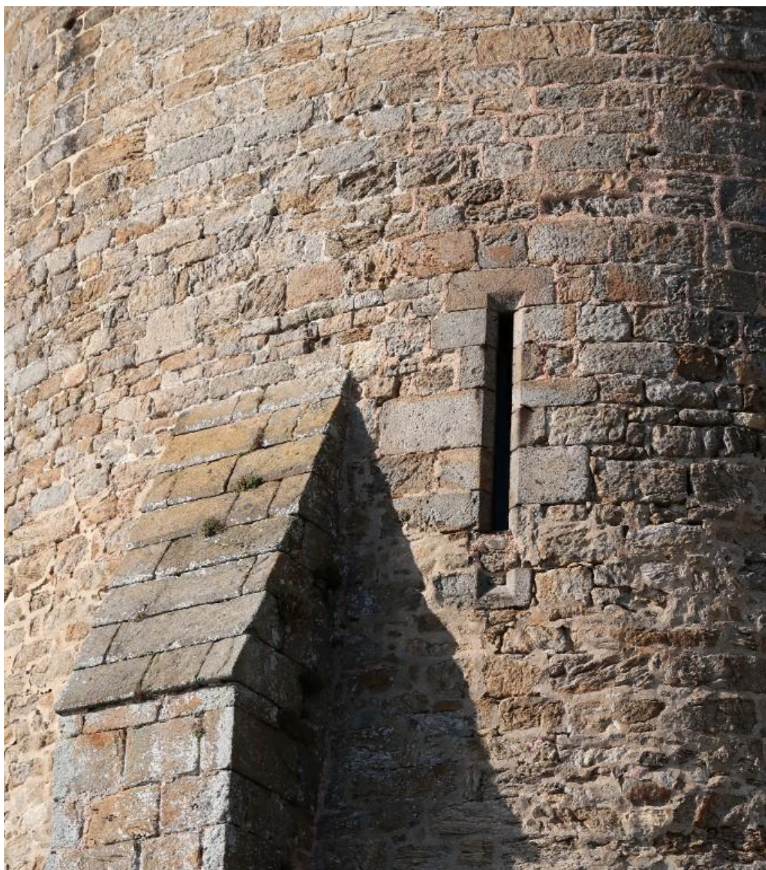
Vue de l'arbalétrière-canonnière sud (dépourvue d'arc de décharge) du rez-de-chaussée de la tour ouest. A gauche, contrefort sud en pierre de taille
