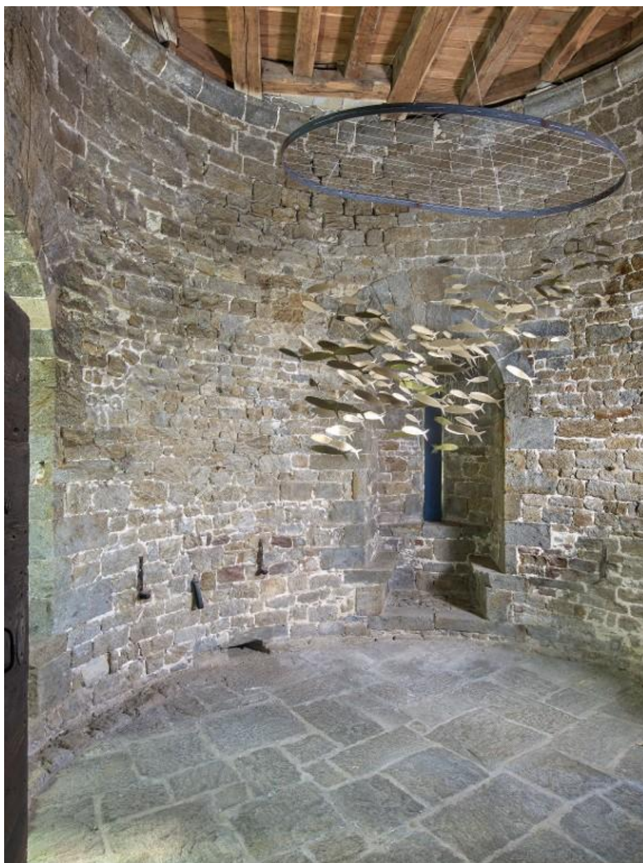
Vue intérieure de la tour Solidor : rez-de-chaussée, tour ouest, arbalétrière-canonnière à double coussiège orientée vers le nord. Au niveau du sol se voit l'arase de la fondation (correspondant à la tour primitive) et un égout
