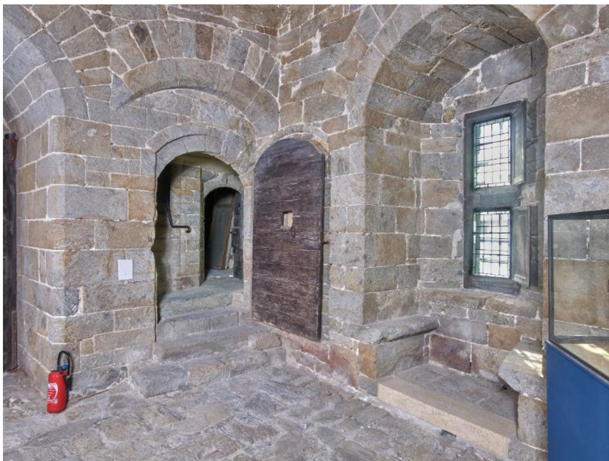
Vue intérieure de la tour Solidor : rez-de-chaussée, pièce intermédiaire, angle est. La porte au centre dessert la tour est qui abrite l'escalier en vis. A droite, baie à double coussiège orientée vers le sud ; à gauche, le passage d'entrée
