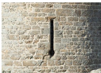
Vue de la tour Solidor : arbalétrière-canonnière (dépourvue d'arc de décharge) du rez-de-chaussée de la tour nord. Elle est orientée vers l'est Phot. Léna Leroy IVR53_20253500614NUCA
