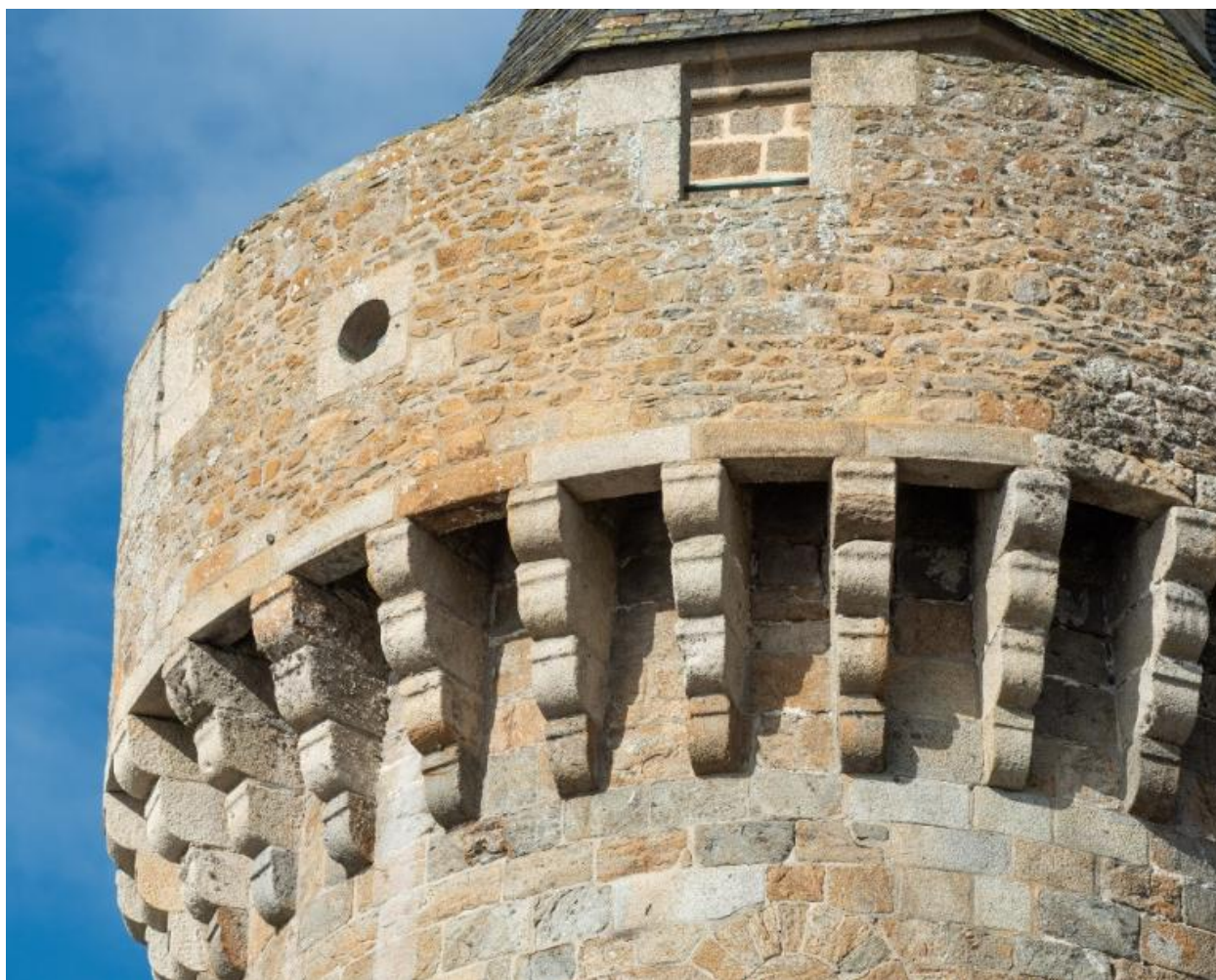
Vue de la tour Solidor depuis l'est-nord-est : détail du chemin de ronde crénelé équipé de mâchicoulis (sur console à quatre ressauts). Pierres plus récentes et remontage sont visibles
