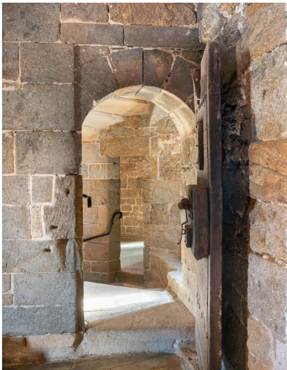
Vue intérieure de la tour Solidor : premier étage, pièce intermédiaire, porte d'accès depuis l'escalier en vis (ouverte). Le dispositif de fermeture de la porte et le judas témoignent de l'utilisation carcérale de la tour. Elle comporte des graffitis
