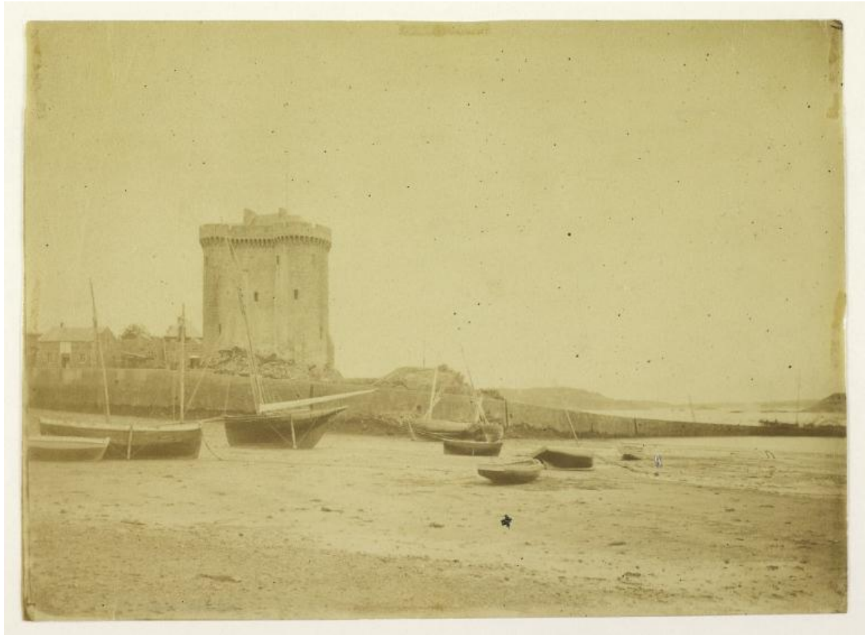
Vue de la Tour Solidor avant restauration
