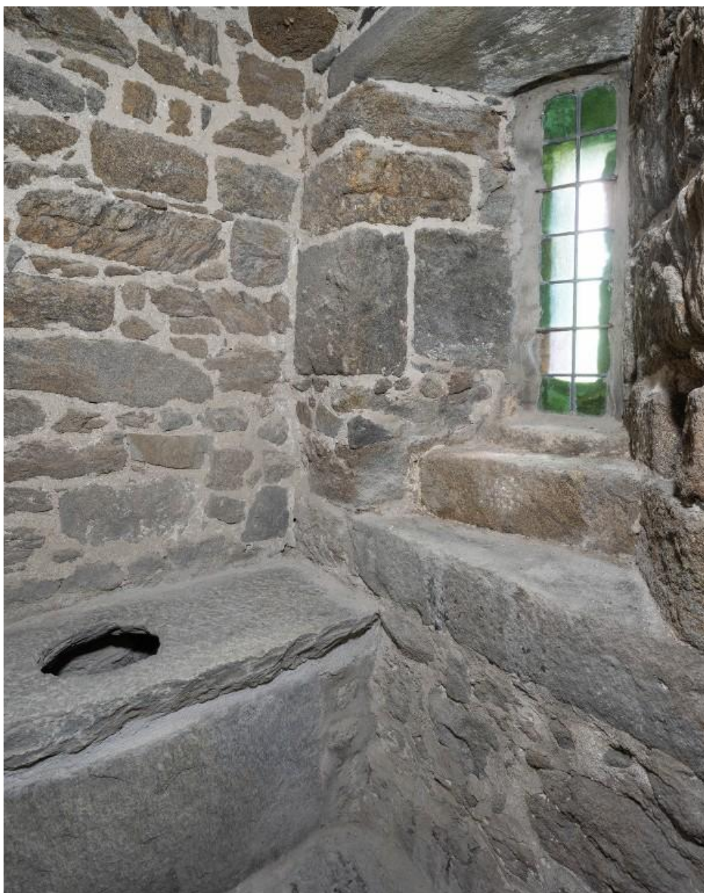
Vue intérieure de la tour Solidor : premier étage, tour ouest, latrines. Elles sont éclairées par une arbalétrière orientée vers le sud
