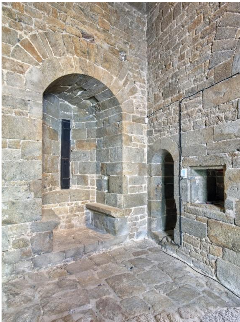
Vue intérieure de la tour Solidor : rez-de-chaussée, pièce intermédiaire, angle nord, arbalétrière-canonnière à double-coussiège orientée vers le nord. La porte à droite dessert la tour nord ; à droite, placard mural
