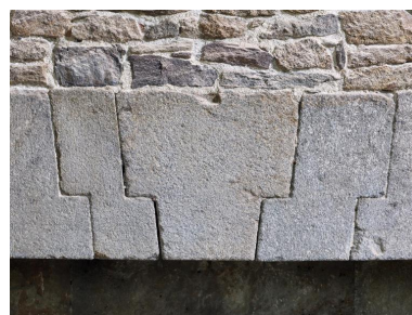
Vue intérieure de la tour Solidor : rez-de-chaussée, pièce intermédiaire, détail de la mise en oeuvre du manteau de cheminée en pierre de taille de granite Phot. Bernard Bègne IVR53_20253500589NUCA
