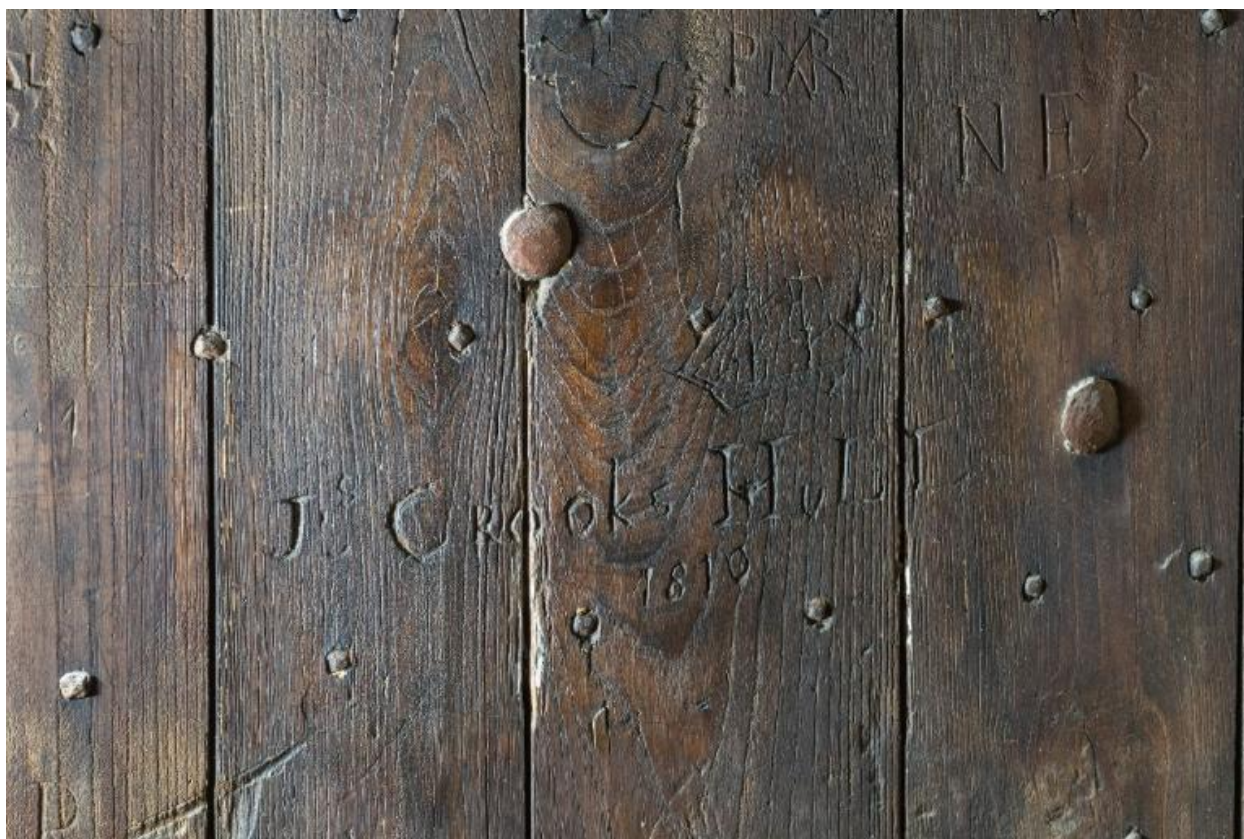
Vue intérieure de la tour Solidor : détail des graffitis de la porte du premier étage. On peut lire : J Crooks HuLC 1810 ; PMR ; NES et identifier un brick (voilier à deux mâts)
