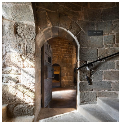
Vue intérieure de la tour Solidor : porte d'accès du premier étage depuis l'escalier en vis. Le dispositif de fermeture de la porte et le judas témoignent de l'utilisation carcérale de la tour Phot. Léna Leroy IVR53_20253500628NUCA
