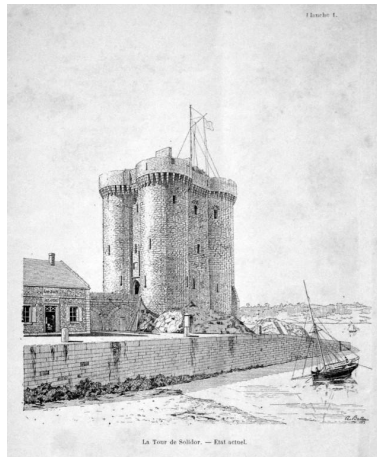
Vue de la tour Solidor depuis le nord : état avant travaux, dessin d'Albert Ballu, architecte, planche n° 1, 1883. Au sommet de tour se dresse un mât de pavillon. Les arches du pont sont occupées Phot. Auteur inconnu (phototype/graphique) IVR53_20253510319NUC
