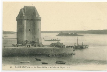
Vue générale de la tour Solidor depuis le nord-nord-ouest, carte postale (LL) Repro. Archives départementales d'Ile-et-Vilaine, Phot. Auteur inconnu (phototype/graphique) IVR53_20253510368NUCA
