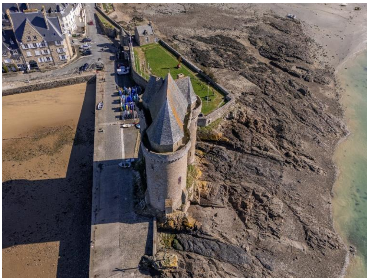
Vue aérienne oblique depuis l'ouest-sud-ouest. Le pied de la tour ouest est soutenu par trois contreforts
