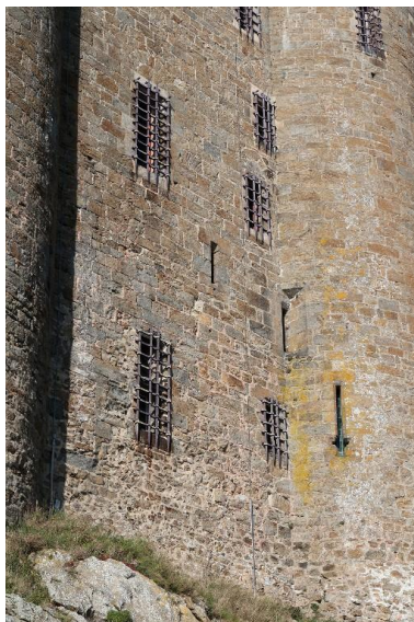
Vue de détail de l'élévation sud de la tour : deux mises en œuvre différentes sont visibles dans la maçonnerie Phot. Guillaume Lécueillier IVR53_20263510548NUCA
