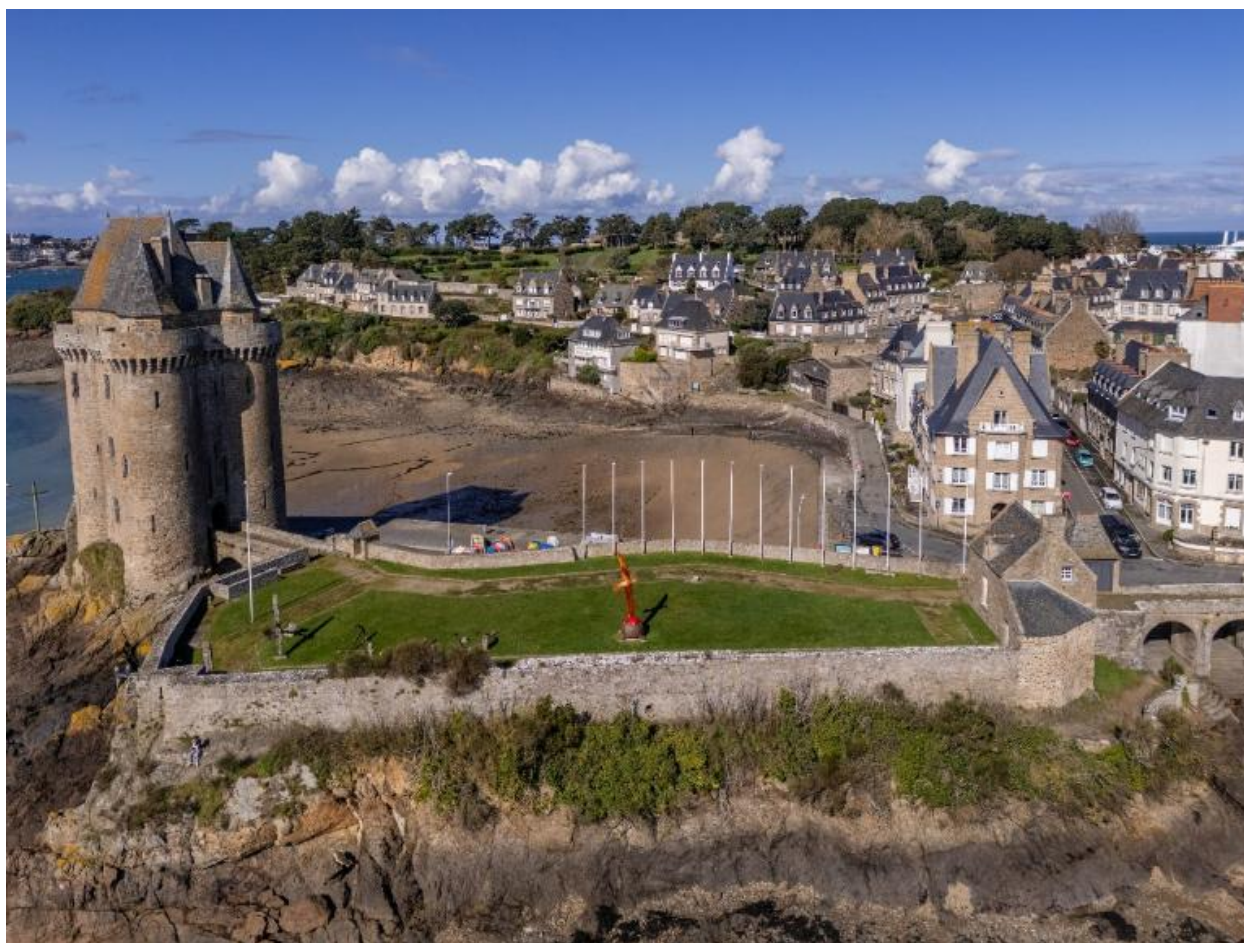
Vue aérienne oblique depuis le sud-est : tour, pont et basse-cour. En arrière-plan, Saint-Servan et la pointe de la Cité d'Aleth
