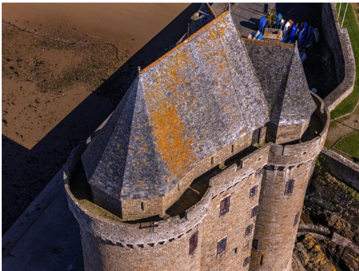
Vue aérienne oblique depuis le sud-ouest : étage de comble coiffé d'un toit conique complexe en ardoise
