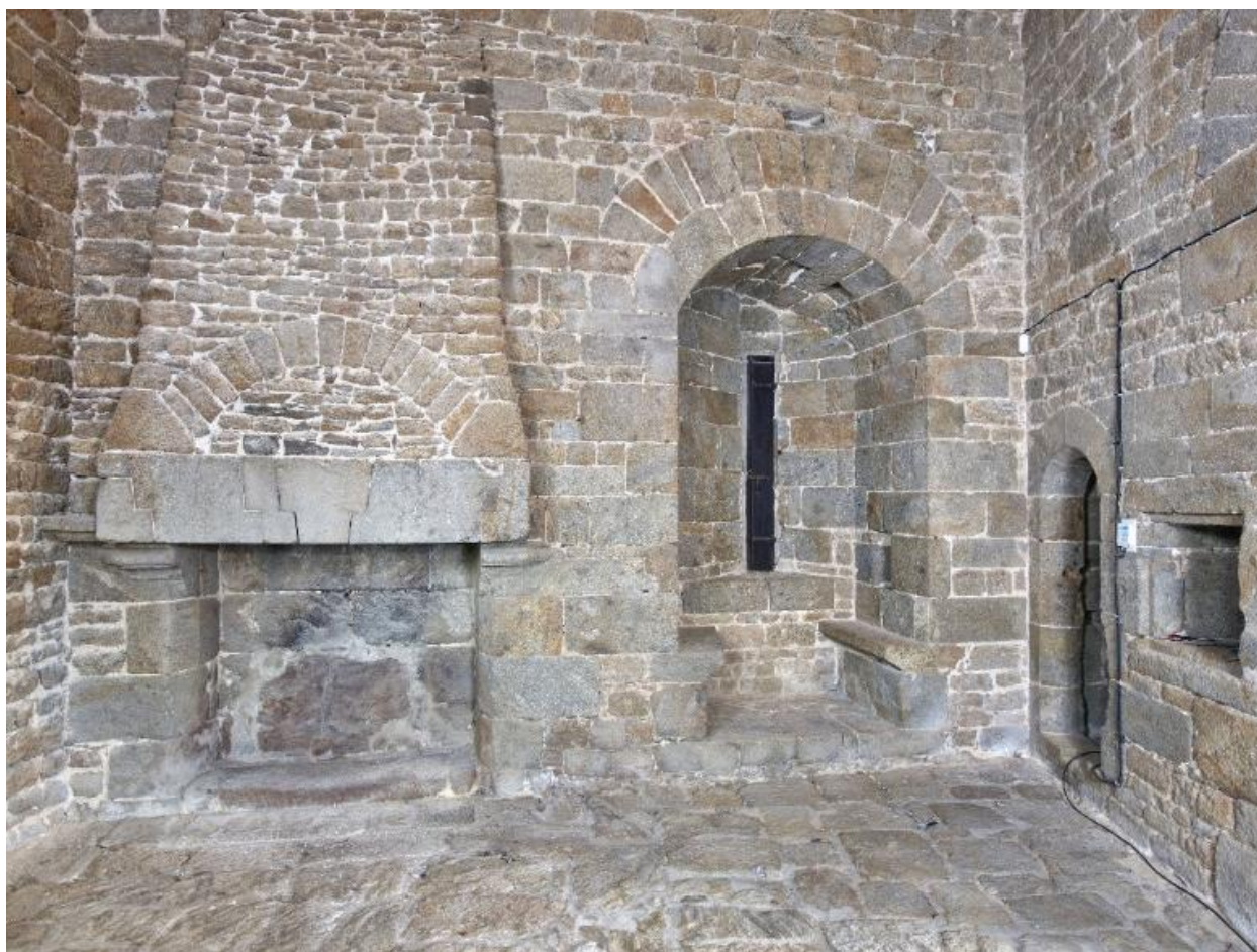
Vue intérieure de la tour Solidor : rez-de-chaussée, pièce intermédiaire, mur nord avec cheminée et arbalétrière-canonnnière à double coussiège orientée vers le nord
