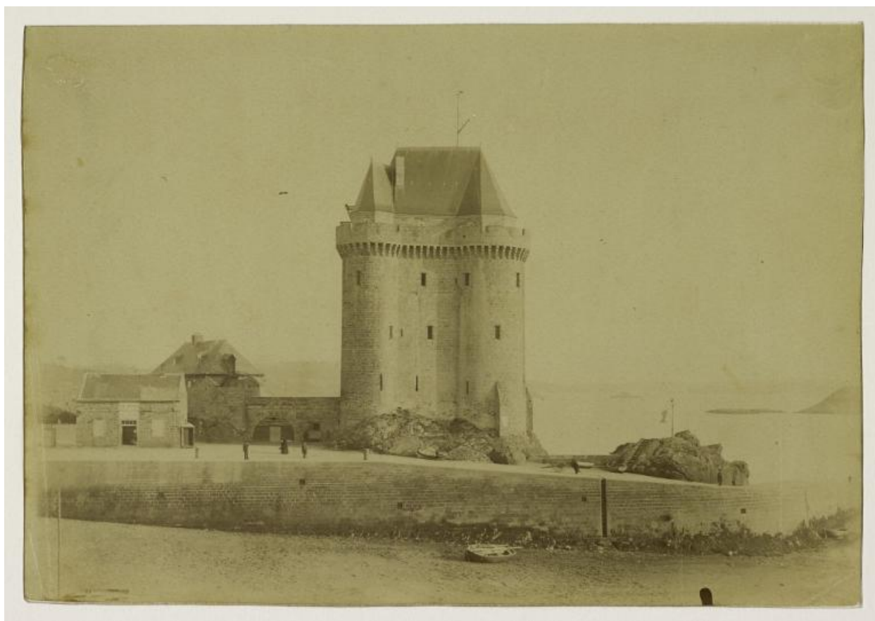
Vue de la Tour Solidor après restauration
