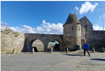
Vue de l'élévation nord du pont dormant et du châtelet d'entrée de la basse-cour. La partie haute de la tour a fortement été restaurée
