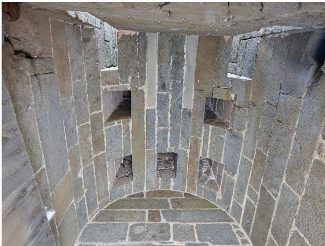
Vue intérieure de la tour Solidor : rez-de-chaussée, détail de la voûte du passage d'entrée avec ses cinq assommoirs accessibles depuis le premier étage
