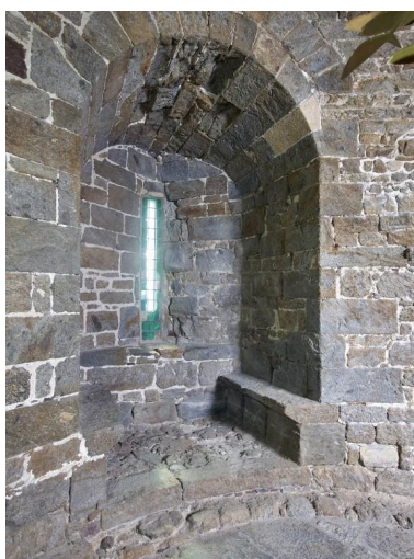
Vue intérieure de la tour Solidor : rez-de-chaussée, tour ouest, arbalétrière-canonnière à double coussiège orientée vers l'ouest. Au niveau du sol se voit l'arase de la fondation (correspondant à la tour primitive)
