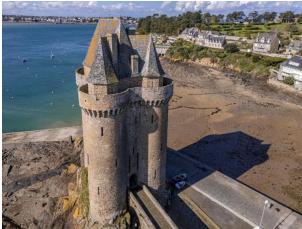
Vue aérienne oblique depuis l'est : tour et pont dormant. L'étage de comble coiffé d'un toit conique complexe en ardoise
