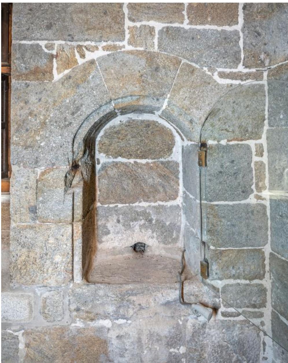
Vue intérieure de la tour Solidor : premier étage, pièce intermédiaire, placard mural (en arc plein cintre). Il est doté d'un égout
