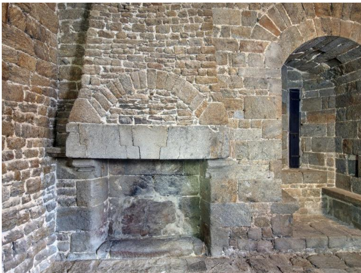
Vue intérieure de la tour Solidor : rez-de-chaussée, pièce intermédiaire, mur nord avec cheminée. A droite, arbalétrière-canonnière à double coussiège orientée vers le nord
