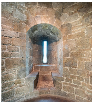
Vue intérieure de la tour Solidor : premier étage, tour est, arbalétrière-canonnière à double coussiège orientée vers l'est Phot. Léna Leroy IVR53_20253500627NUCA
