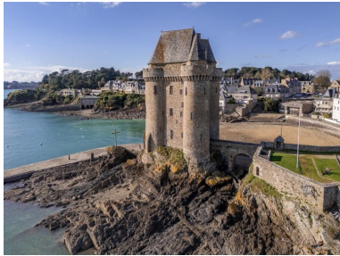
Vue aérienne oblique depuis le sud-est : tour, pont et basse-cour. La basse-cour est percée d'une poterne. En arrière-plan, Saint-Servan et la pointe de la Cité d'Aleth Phot. Jean-Marie Balliet IVR53_20253510338NUCA
