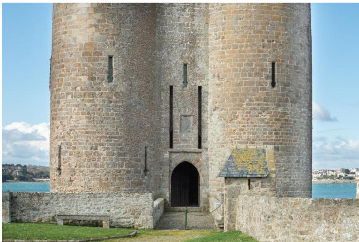
Vue de la tour Solidor depuis l'est-nord-est : rez-de-chaussée et premier étage percés d'arbalétrières-canonnières. Au centre, la porte d'entrée précédée d'un pont. A droite, guérite
