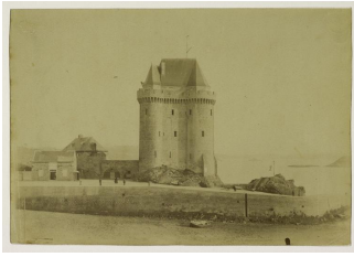
Vue de la Tour Solidor après restauration
