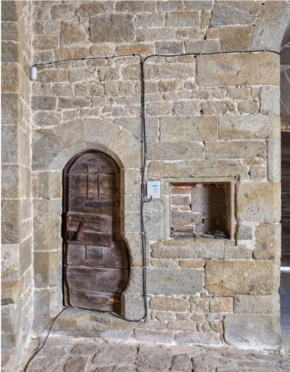
Vue intérieure de la tour Solidor : rez-de-chaussée, pièce intermédiaire, détail du mur est. Cette porte dessert la tour nord ; à droite, placard mural. Le passage de la porte a été élargi pour permettre le passage de tonneau
