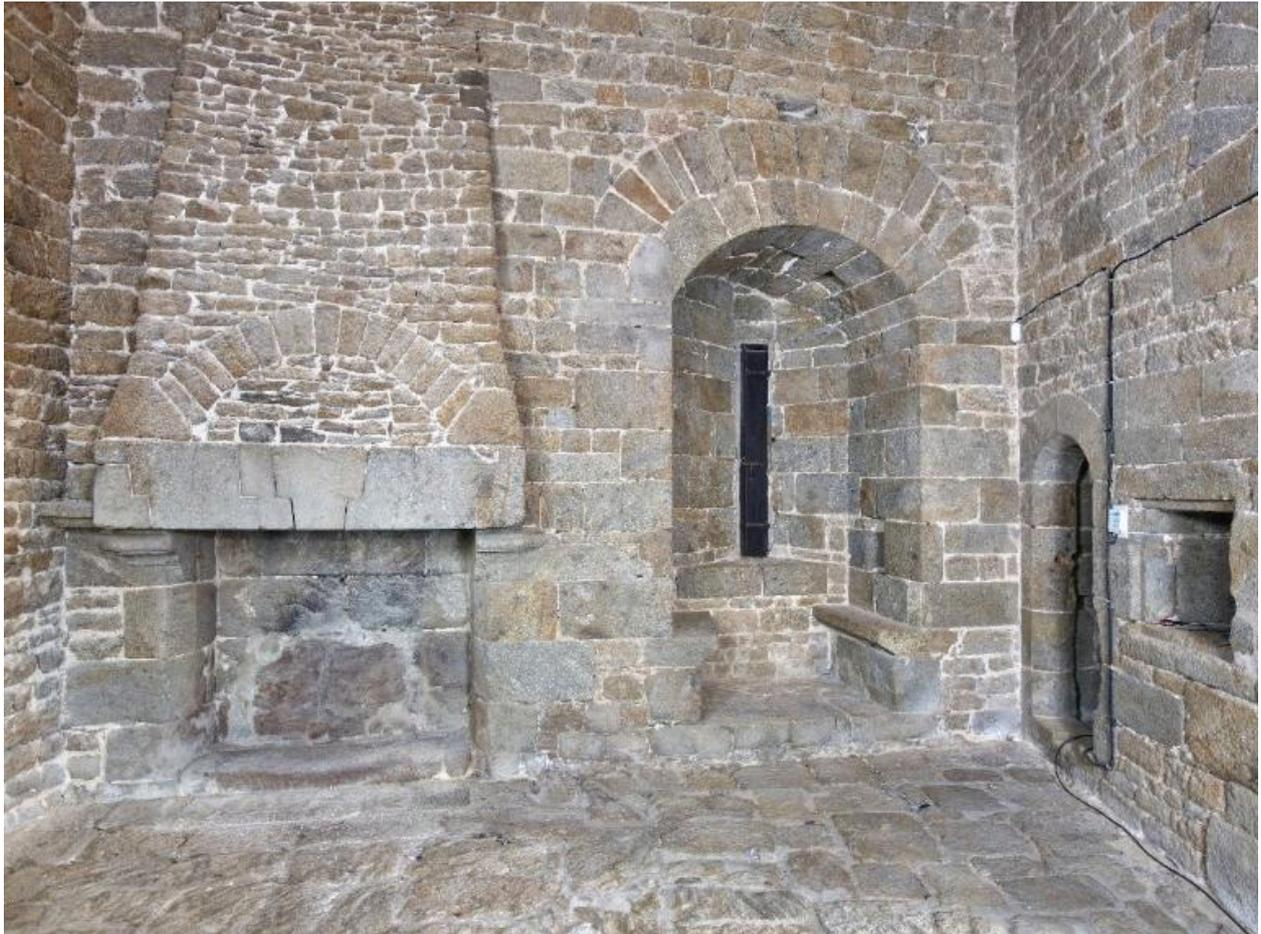
Vue intérieure de la tour Solidor : rez-de-chaussée, pièce intermédiaire, mur nord avec cheminée et arbalétrière-canonnrière à double coussiège orientée vers le nord
