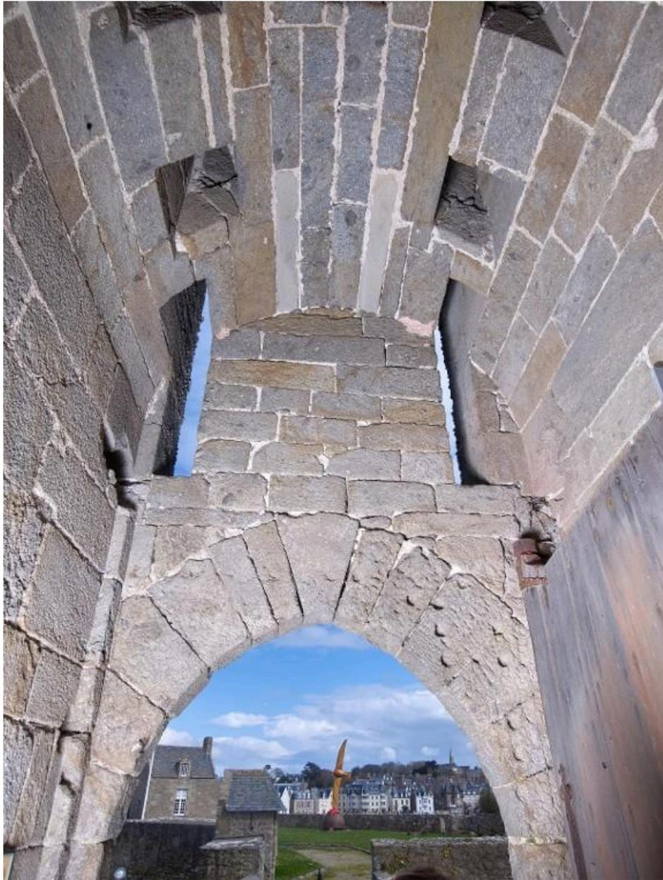
Vue intérieure de la tour Solidor : rez-de-chaussée, détail de la voûte du passage d'entrée avec ses assommoirs accessibles depuis le premier étage. Au-dessus de la porte en tiers-point se trouvent les rainures des flèches du pont-levis
