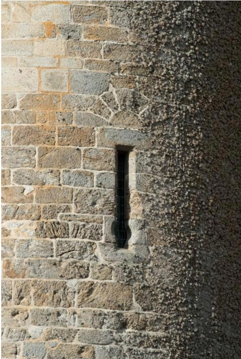
Vue de la tour Solidor : arbalétrière-canonnière du premier étage de la tour est (surmontée d'un arc de décharge). Elle est orientée vers le nord-est
