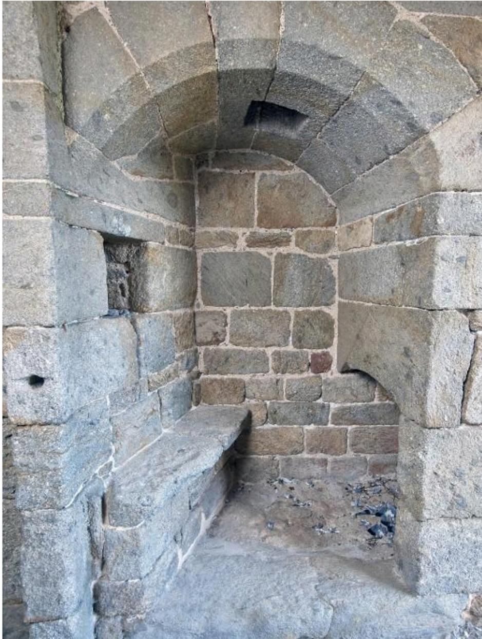
Vue intérieure de la tour Solidor : rez-de-chaussée, poste de garde implanté dans le passage d'entrée au nord. Il comprend un banc en pierre, une cheminée et une niche mural. Dans la voûte se trouve un assommoir accessible depuis le premier étage
