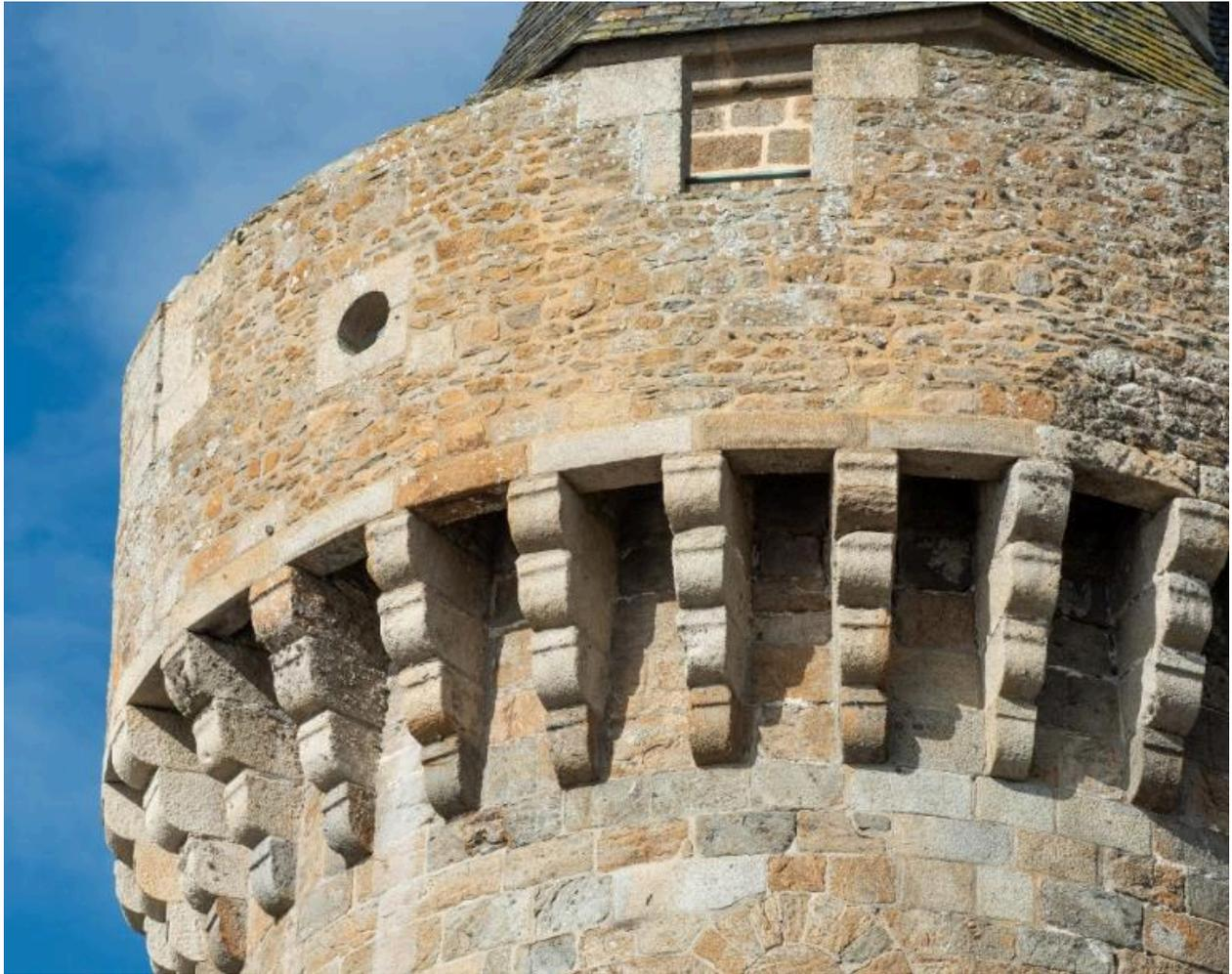
Vue de la tour Solidor depuis l'est-nord-est : détail du chemin de ronde crénelé équipé de mâchicoulis (sur console à quatre ressauts). Pierres plus récentes et remontage sont visibles
