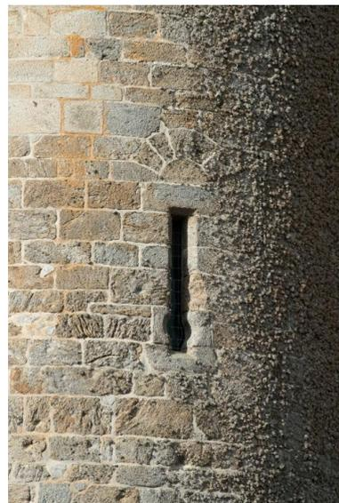
Vue de la tour Solidor : arbalétrière-canonniers du premier étage de la tour est (surmontée d'un arc de décharge). Elle est orientée vers le nord-est
